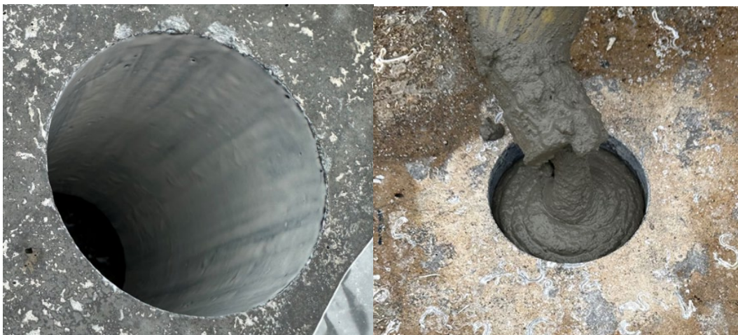
FIGUR 11 REPARASJON AV BORHULL A) ETTER PÅFØRING AV MAPEPOXY LR OG B) FYLLING MED MAPEI CONFIX. FOTO: EVA RODUM, STATENS VEGVESEN.
