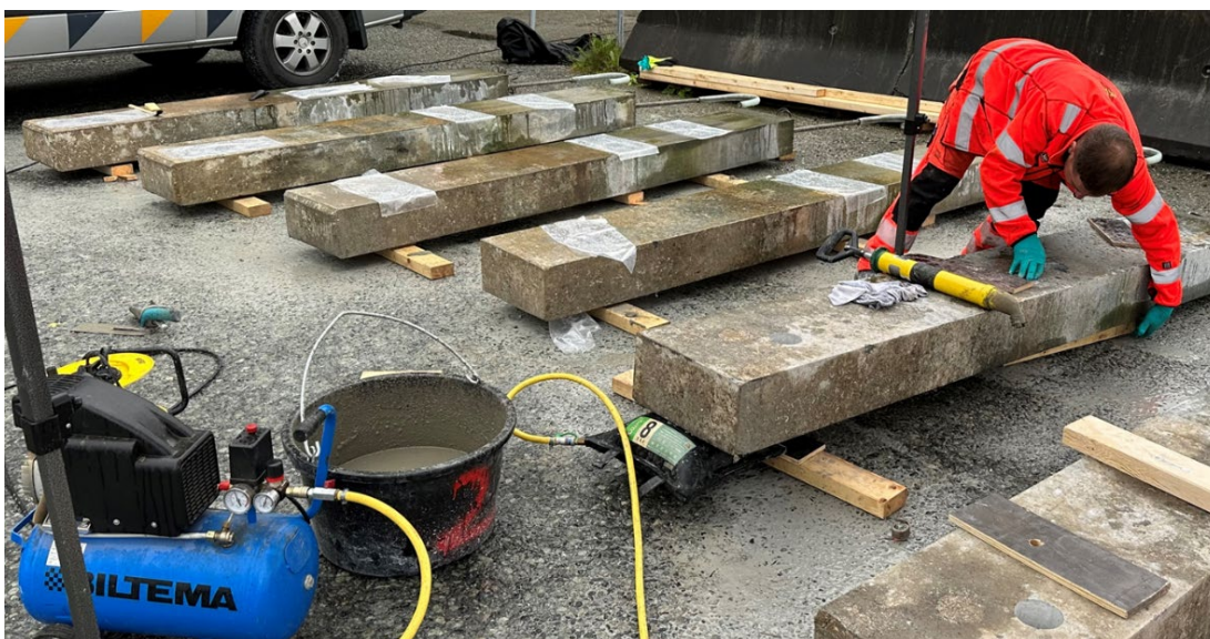
FIGUR 12 OPPJEKKING AV BJELKE VED BRUK AV LUFTPUTE OG PLASSERING AV FORSKALING. FOTO: EVA RODUM, STATENS VEGVESEN.
