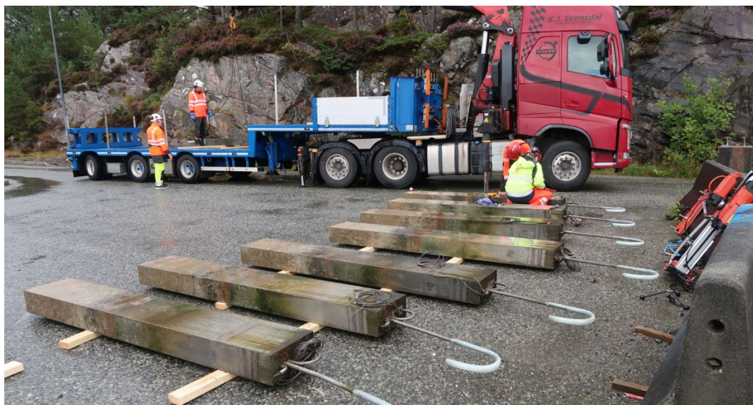
FIGUR 2 FOTO AV ELEMENTENE OPPLAGT PÅ STRØ FORAN FERJEKAIEMMEN. FOTO: EVA RODUM, STATENS VEGVESEN
