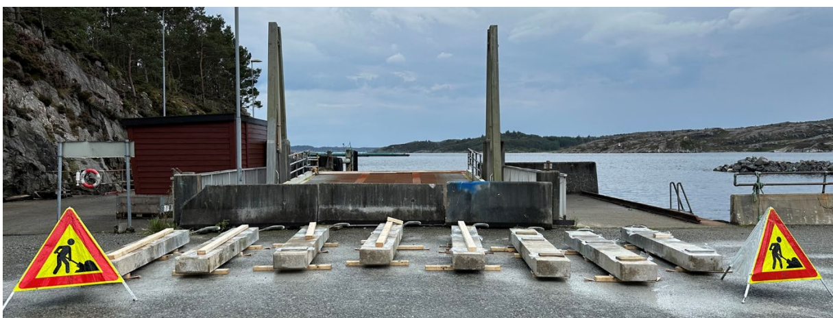
FIGUR 13 ELEMENTENE ETTER UTFØRT REPARASJON AV BORHULL. FOTO: EVA RODUM, STATENS VEGVESEN.
