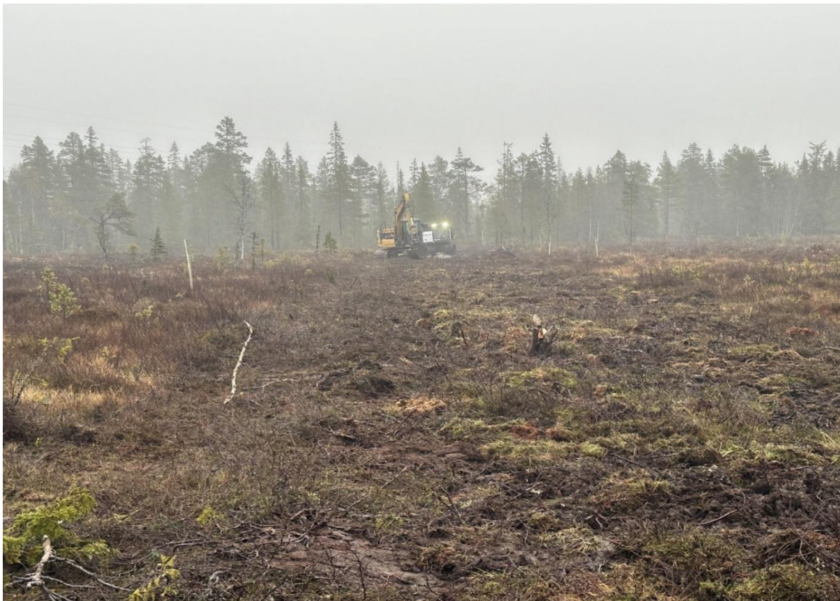
Figur 31: Bilde tatt rett etter tetting av grøft. Foto: Even Stensrud
