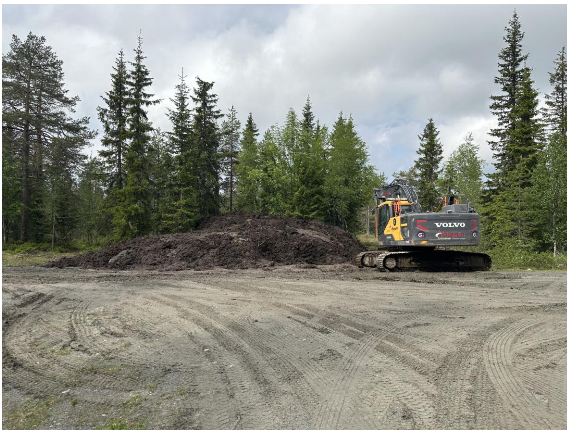
Figur 15: Torvmasser plassert på mellomlager, rett ved innkjøringen til myrområdet. Foto: Even Stensrud
