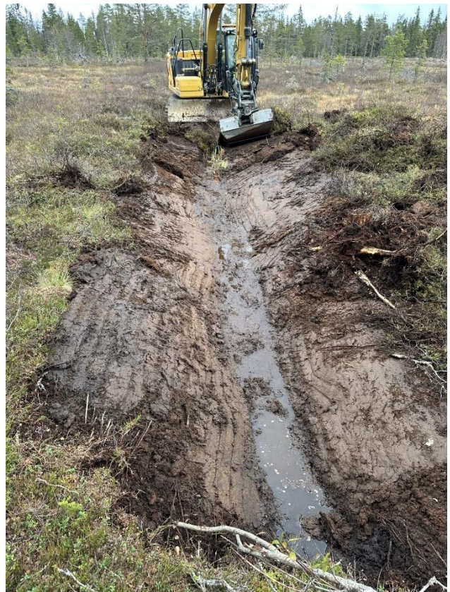
Figur 22 og 23: Bilder fra grøfter hvor en og en arbeidsoperasjon ble utført i hele grøftens lengde. Foto: Even Stensrud.
