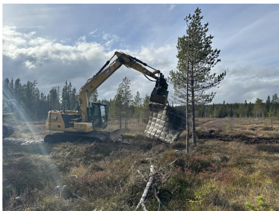
Figur 12 og 13: Gravemaskin (15 tonn) og Hjullaster Volvo 110 i arbeid. Foto: Even Stensrud
