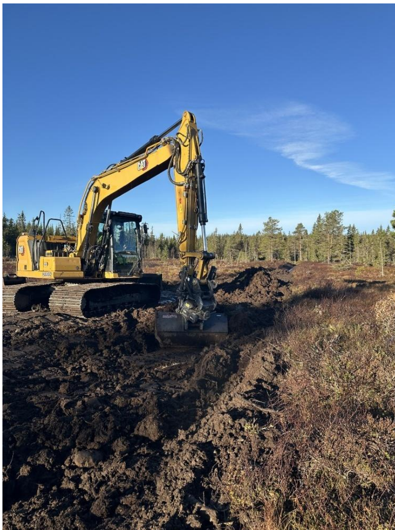
Figur 21: Plassering av bredbeltet gravemaskin på siden av grøften. Foto: Even Stensrud.
