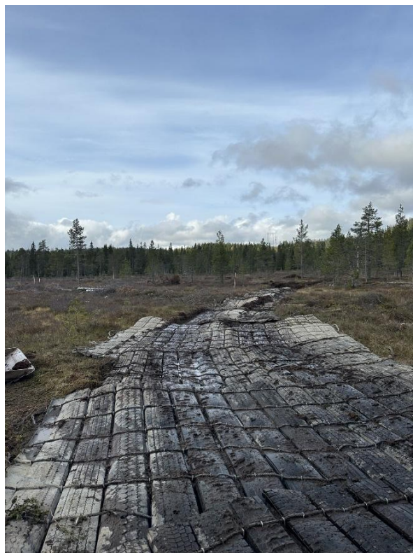
Figur 19 og 20: Skytematter i grøft og grunnforsterkning med skytematter. Foto: Even Stensrud
