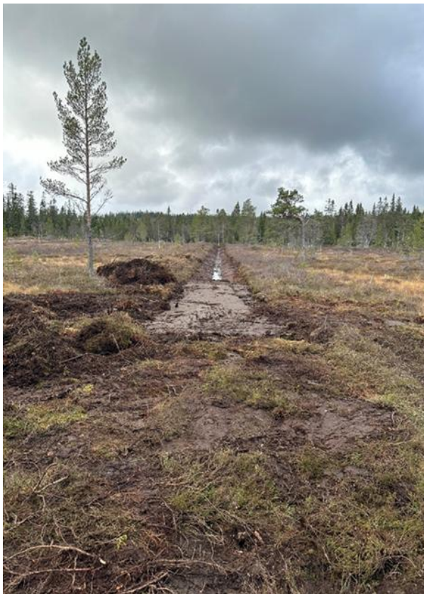
Figur 22 og 23: Bilder fra grøfter hvor en og en arbeidsoperasjon ble utført i hele grøftens lengde. Foto: Even Stensrud.
