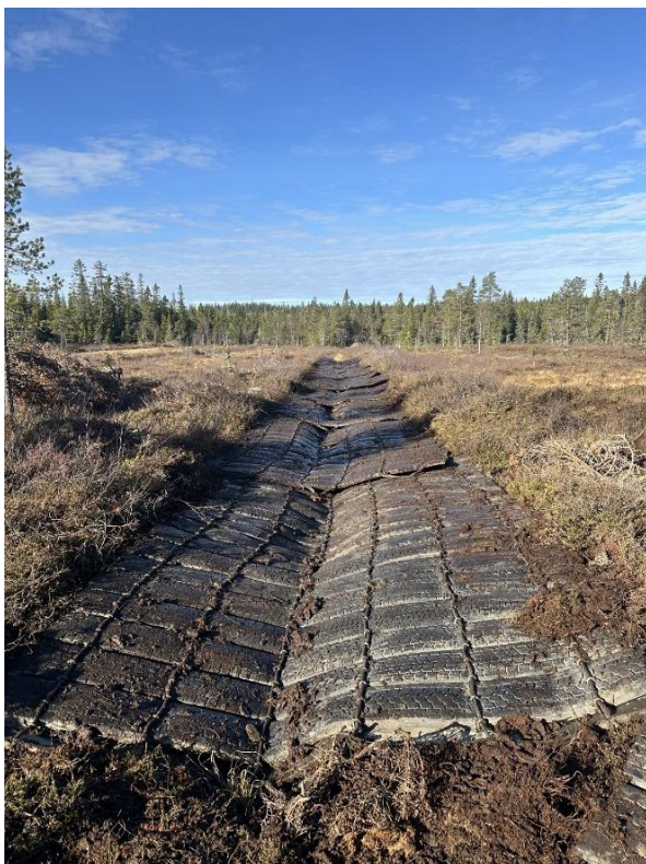
Figur 19 og 20: Skytematter i grøft og grunnforsterkning med skytematter. Foto: Even Stensrud
