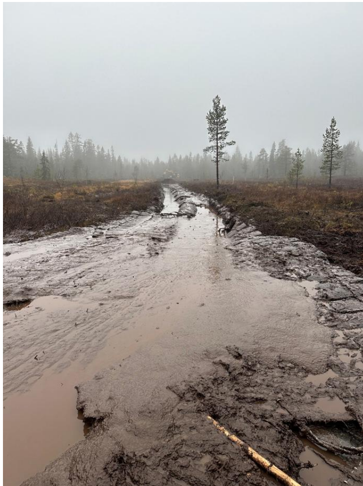
Figur 18: Mye nedbør under restaurering av en av grøftene. Foto: Even Stensrud.
