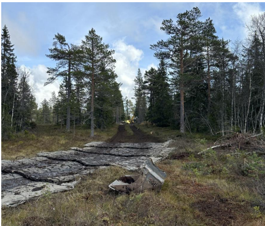
Figur 16: Bilde viser tilkomstveien på myren, hvor det ble lagt ut skytematter. Foto: Even Stensrud
