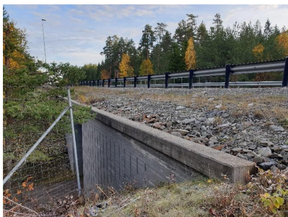
Figur 1 Brynjordsveen til venstre, Sørbryn til høyre. Begge er betongkulverter på Rv 3
