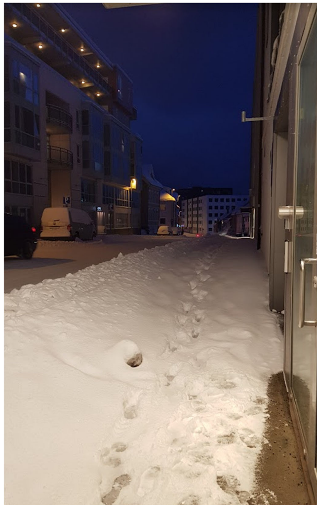
Figur 32 Fortau i Tromsø 03.02.2022 - kjørevei brøytet, fortau snødekket og tining klarer ikke å trenge gjennom etter stort snøfall.
