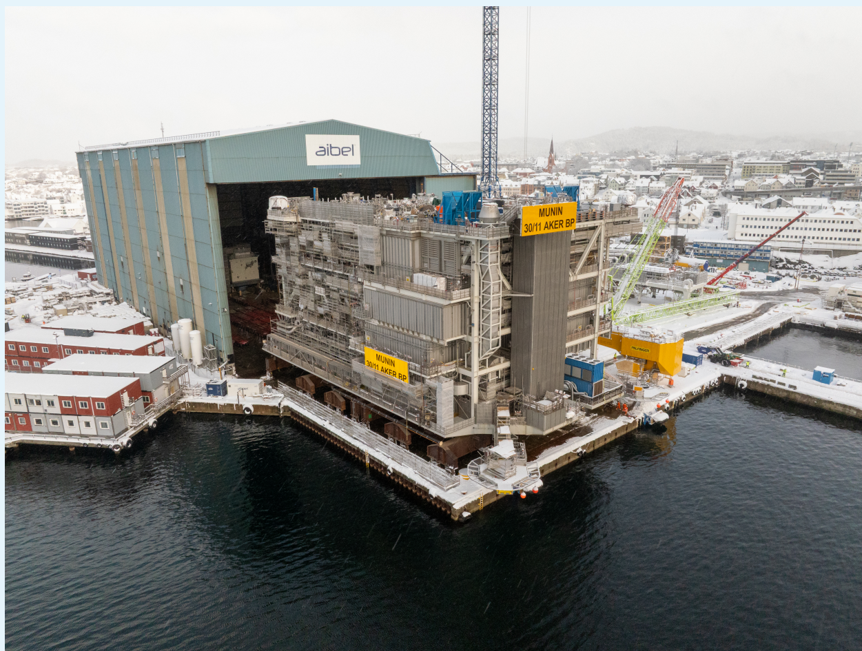
Munin er en ubemannet produksjonsinnretning som er en del av Yggdrasil-utbyggingen i Nordsjøen. (Foto: Aibel/Woldcam)
