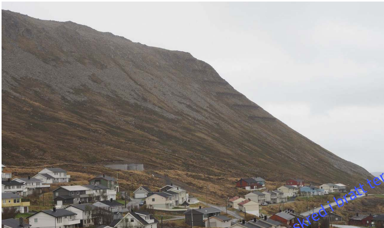
Figur 11: Storfjellet og fjellsiden over bebyggelsen i Skytterveien og kommunens Vanntårn øverst. Til høyre sees støtteforbygningene mot snøskred ovenfor Holmbukt.
