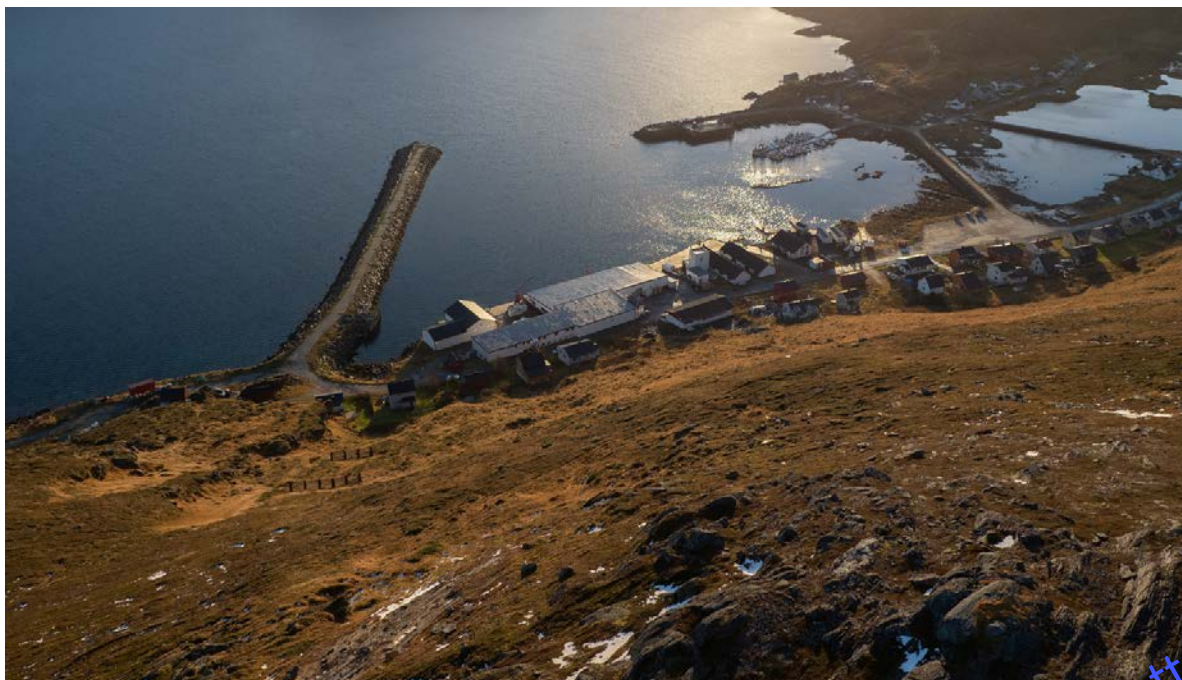
Figur 7: Nordre del av kartleggingsområdet sett fra lufta over toppen av skråningen. Her sees renneformasjoner og de gamle støtteforbygningene tydelig.
