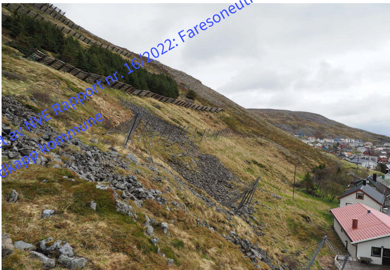
Figur 25: Støtteforbygningene over Øvre St.Hansvei. Øvre del er gammel og av stål og trestokker, mens i nedre del er det supplert med wirenett.
