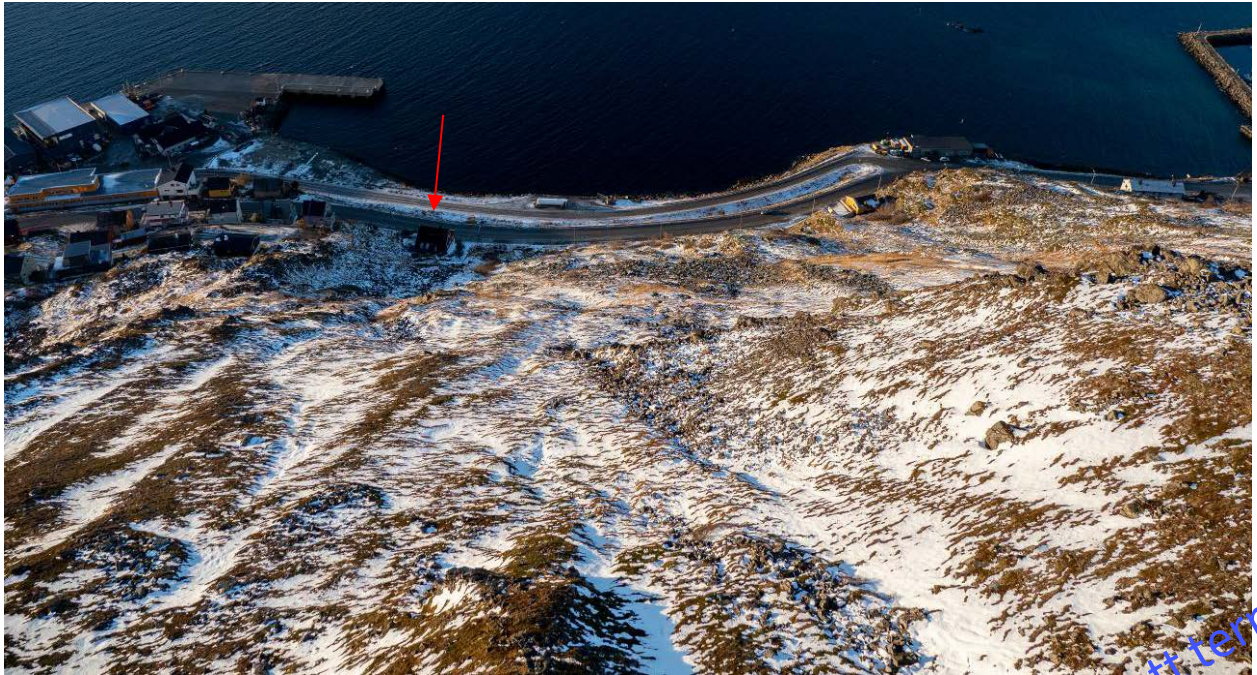
Figur 20: Skredbanene over Nordkappgata 25. Huset er merket med rød pil.
