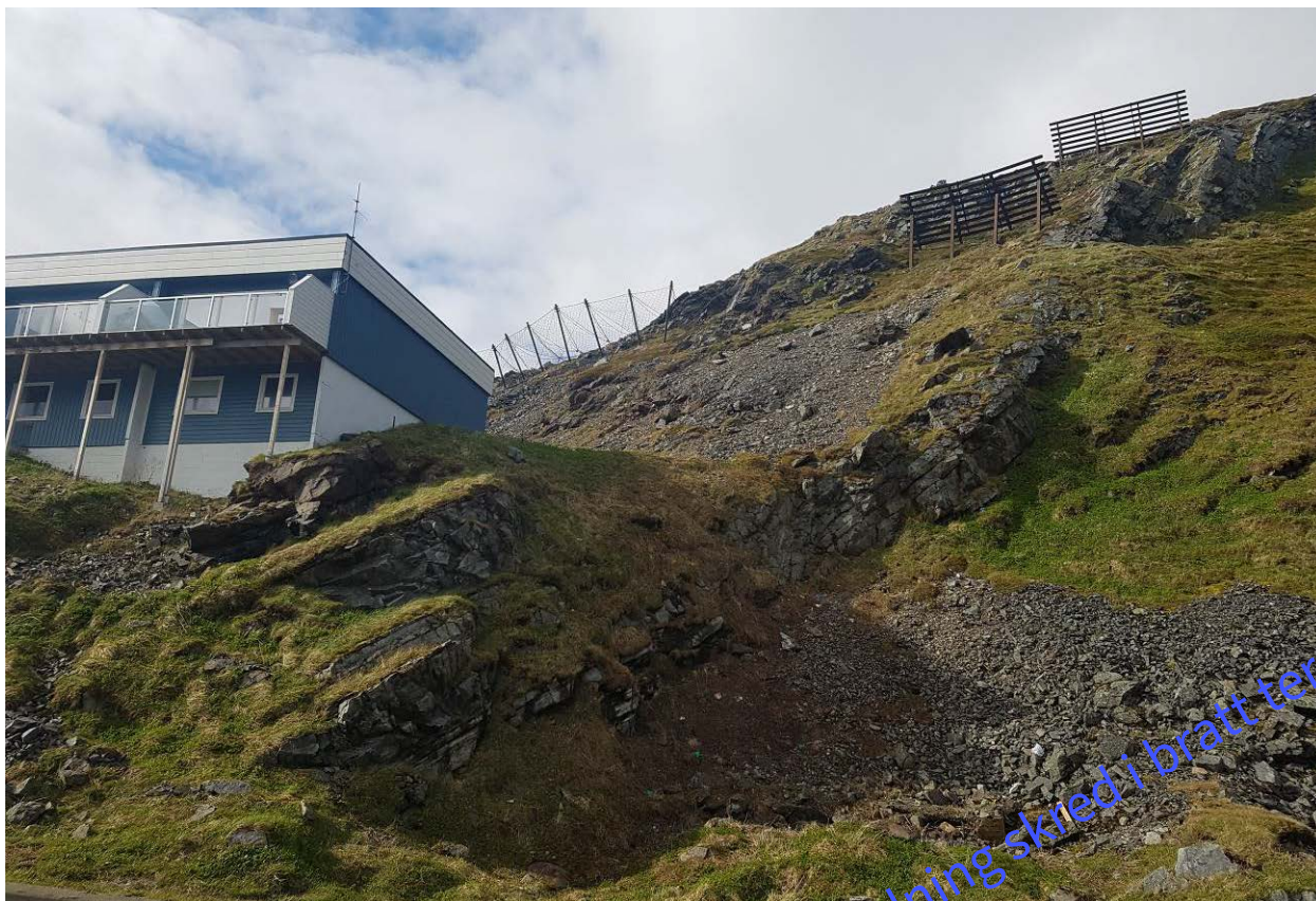
Figur 32: Deler av skråningen ved Hjellevassen. Området er delvis sikret med støtteforbygninger, både stiver av stål og wirenett.
