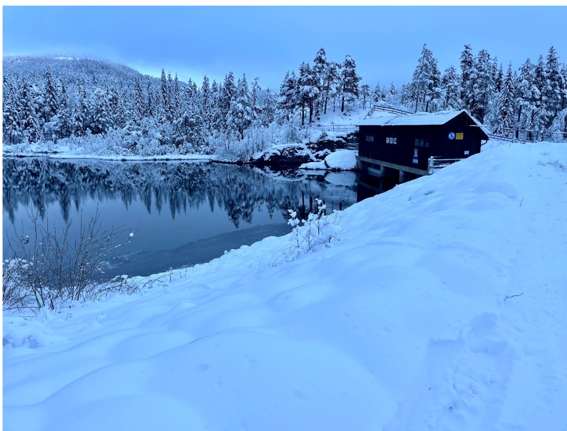
Figur 22: Foto av demningen. Toppen av konstruksjonen under bygget på demningen ligger på +1.5 m over HRV (som er høyden benyttet som terskel for beregning av overtopping). Fyllingsdammen nærmest har en terrenghøyde på + 3.8 m over HRV.
