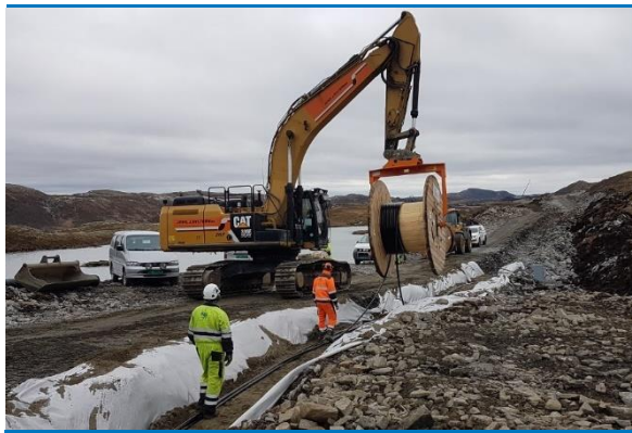
Figur 2-5. Legging av høyspentkabel (jordkabel) i Roan vindkraftverk
