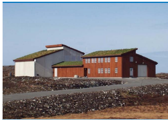
Figur 2-4. Transformatorstasjon og servicebygg ved Smøla vindkraftverk
