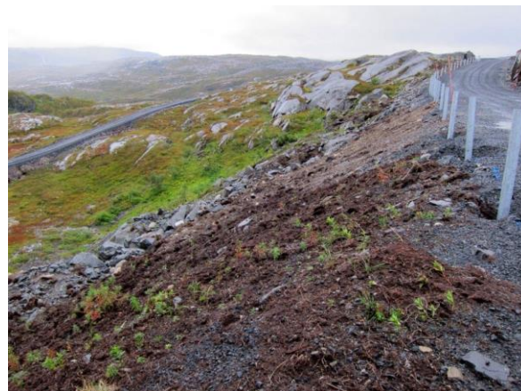
Figur 2-8. Vei i fjellterreng med skrint jordsmonn, samt partier med bart fjell innimellom. Nygårdsfjellet vindkraftverk.
