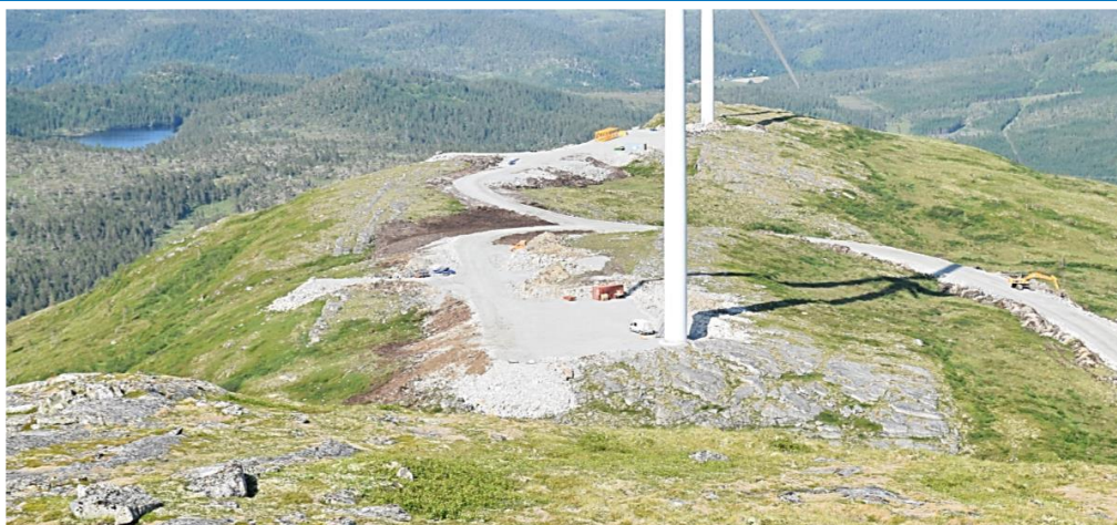
Figur V-3: Før og etter istandsetting av hjelpeanlegg (snuplass, veiforlenger, boom support og hjelpekranplasser) ved vindkraftverk i kupert terreng
