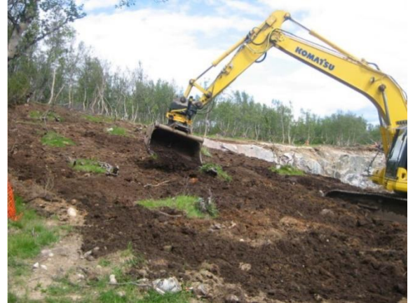
Figur 2-9 Utlekking av transplanterte vegetasjonsflak ved istandsetting av steinbrudd i Bitdalen
