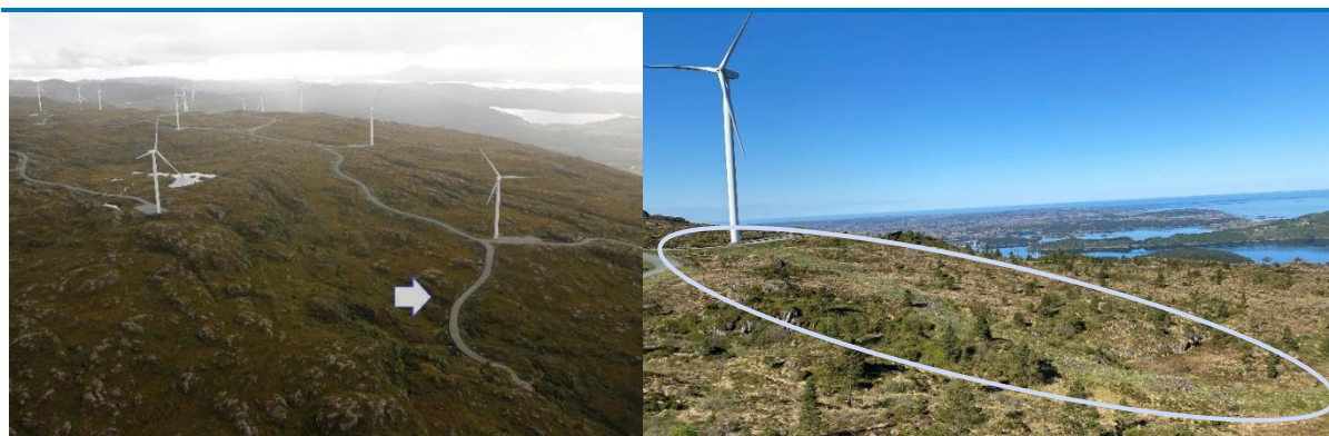
Figur 3-3 Tilbakeføring av 184 meter internvei i Midtfjellet vindkraftverk, før og etterbilde. Området som er tilbakeført er ligger innenfor det markerte området i bildet til høyre
