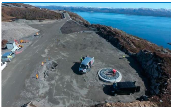
Figur 2-3. Kranoppstillingsplass med fjellforankret turbinfundament, Hundhammerfjellet vindpark
