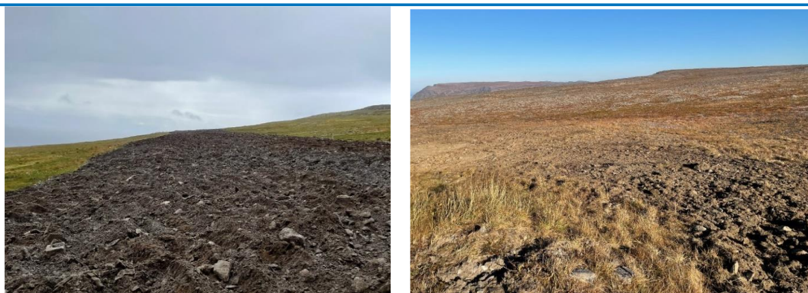
Figur V-6: Til høyre vises en ferdig arrondert vei og til venstre ferdig arrondert terreng
