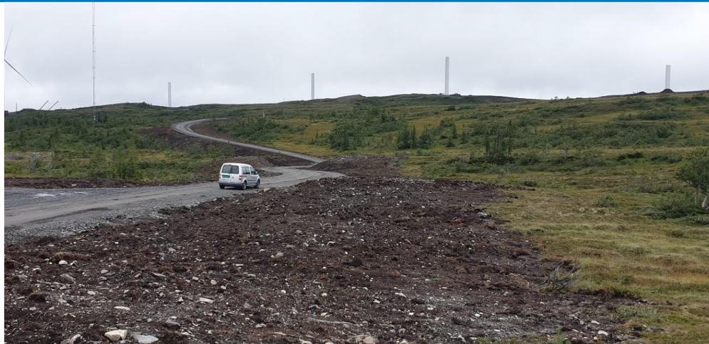
Figur V-4: Eksempel på istandsetting av terreng for anlegg 2, med utlegging av jord og god overgang til eksisterende terreng
