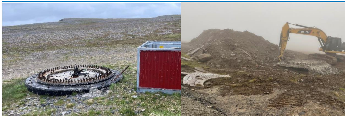
Figur V-5: Turbinfundament etter demontering av turbin (høyre). Fundamentene pigges ned før terreng planeres og område tildekkes (venstre)
