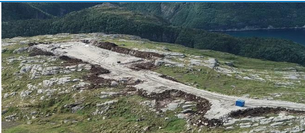
Figur V-1: Øverste bilde viser en hovedkranplass som ligger i skjæring mens hjelpeanleggene ligger på fylling. Nederste bilde er manipulert og viser situasjonen der vendehammer er fjerna, og det er lagt til rette for revegetering på øvrige hjelpeanlegg.
