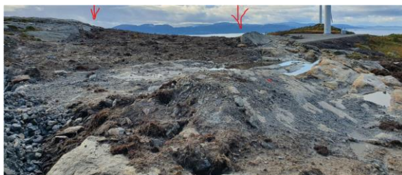
Figur 2-7. Tilbakeført vei som lå gjennom dyp tosidig fjellskjæring (markert med røde piler), Hundhammerfjellet vindkraftverk.
