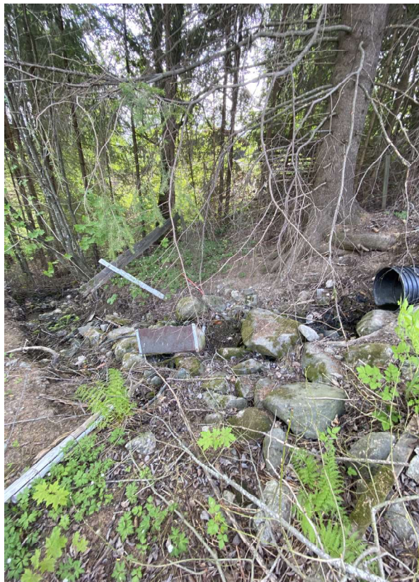
Figur 3-5: Større stein ved utløp av rør.
