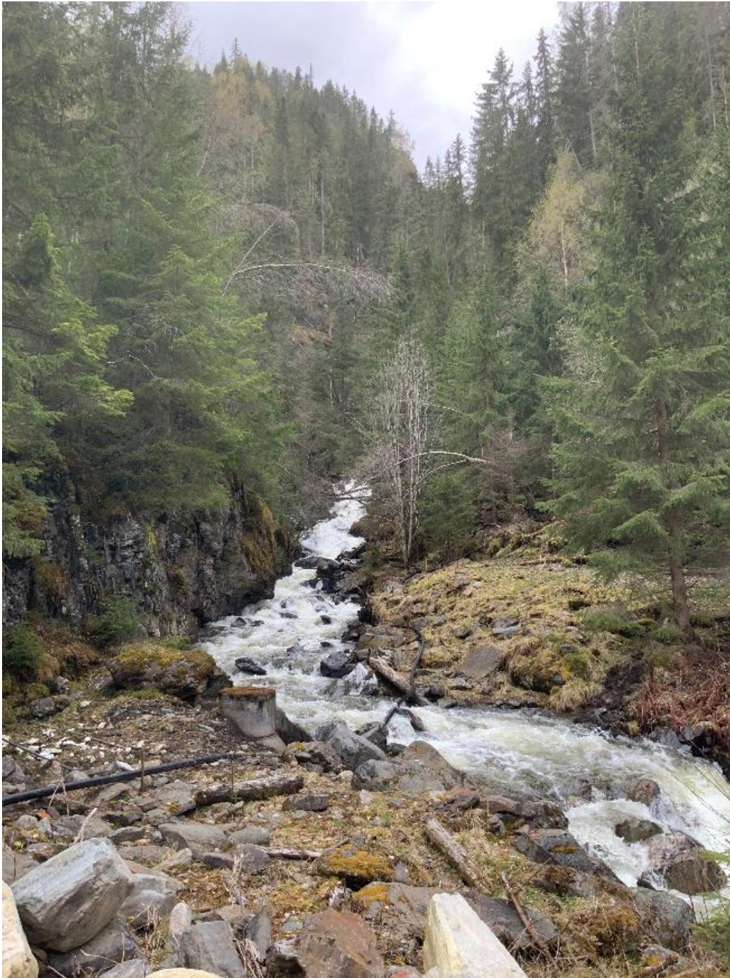
Figur 1-7 Forbygning Ulbergsåa topp vifte.
