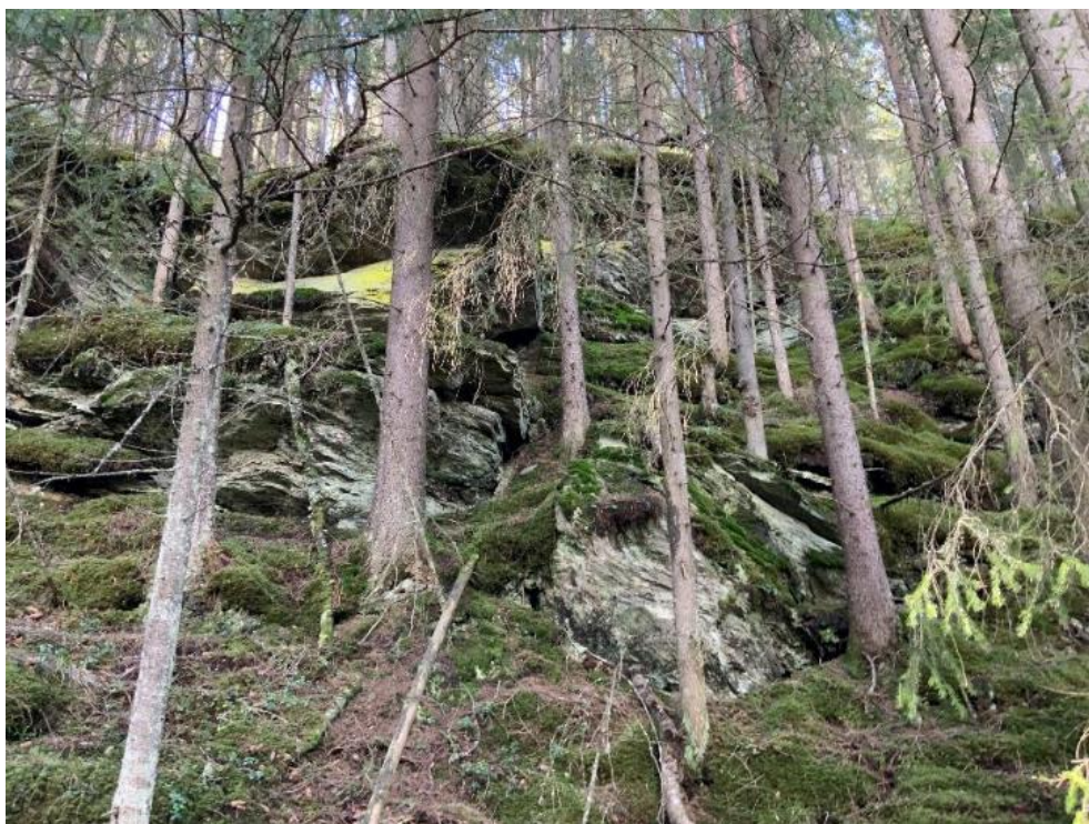
Figur 1-15 Blottlagt berg opp for Gålåvegen 262. Lite eller ingen aktivitet. Frostsprengt stein kan gli ut. Området har ikke potensial for utløp som starter med fall.
