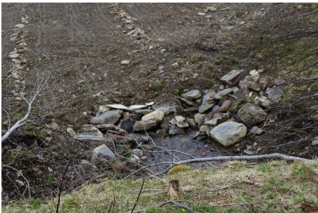
Figur 1-11 Nydyrket og lukket drenering, Muruteigen
