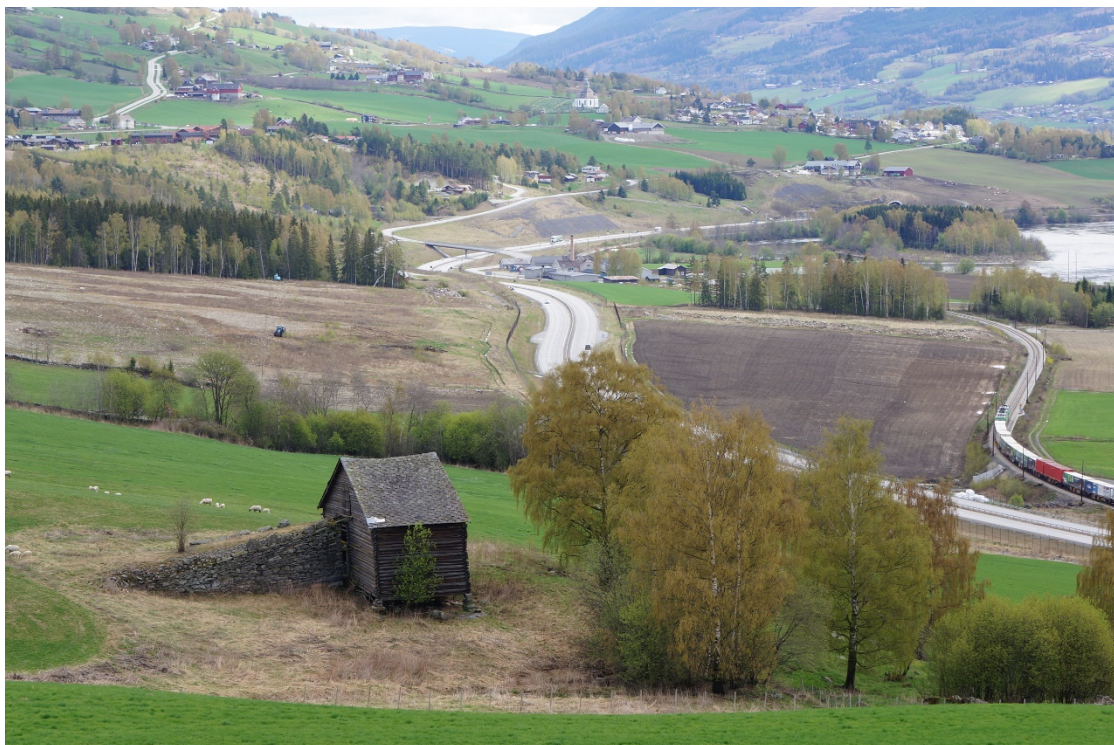
Figur 1-19 Vifta til Augla har blitt ryddet de siste årene. Det er gjort tiltak for å begrense fare mot ny E6 og jernbane.
