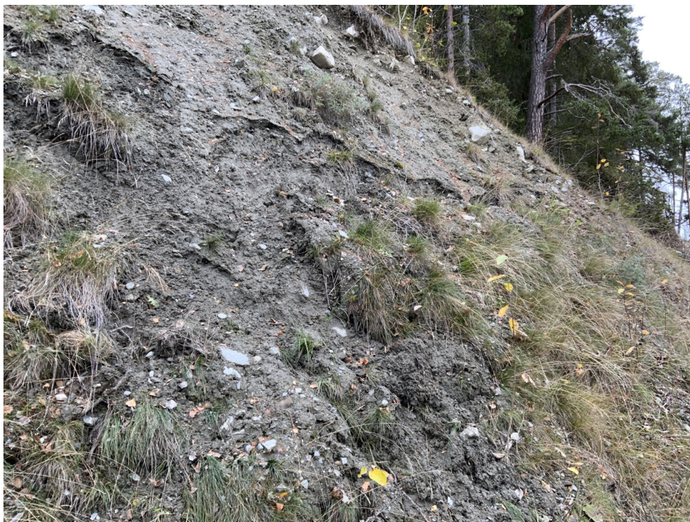
Figur 1-16 Grunn glidning og sig av skjæringer lang Dålåstigen. Massene blir generelt grovere sørover Dålåstigen.
