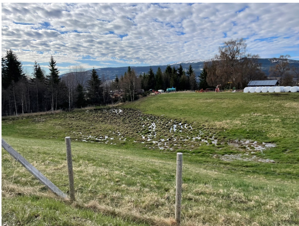
Figur 1-18 Øverbygdvegen opp for Strype. Dam, vannansamling.
