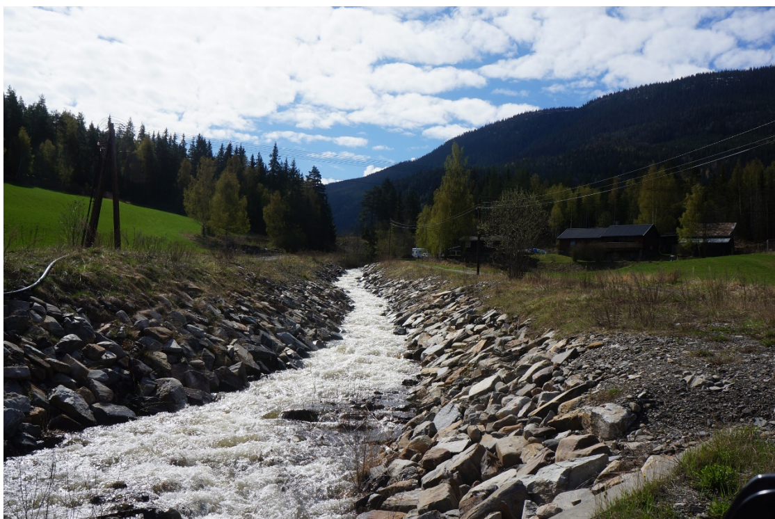
Figur 6-8 Ulbergsåa er kanalisert og erosjonssikret. Her fra partiet opp for Vollen – Haugland. Skreddarstugu til høyre.
