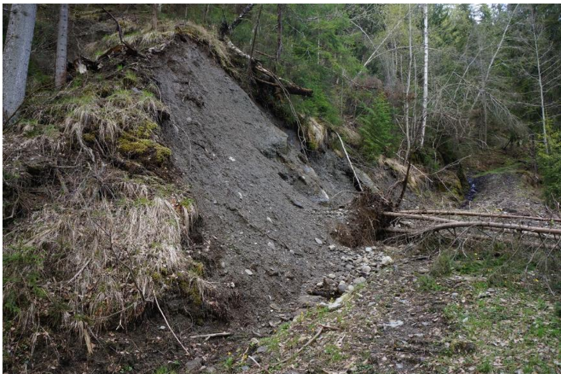
Figur 1-14 Nedrast skjæring på hogstveg. Mye finstoff.
