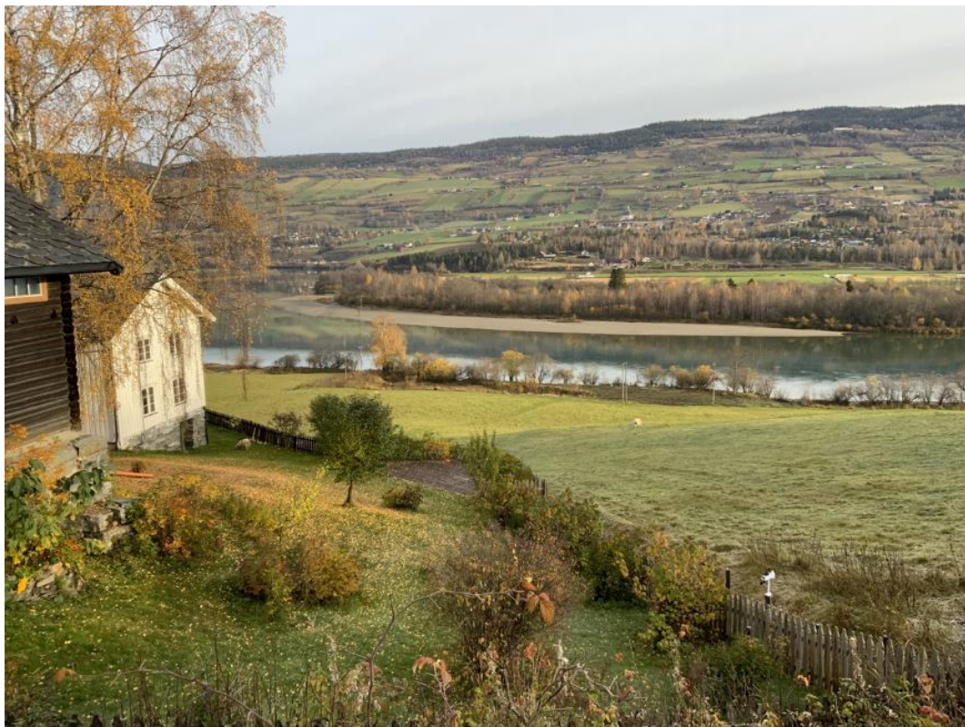
Figur 1-8 Forlengelse av renne sør for Muruteigen gård. Her snur renna seg litt mot nord. Våningshuset vurderes å ligge i kanten av utløp på skred som følger renna.
