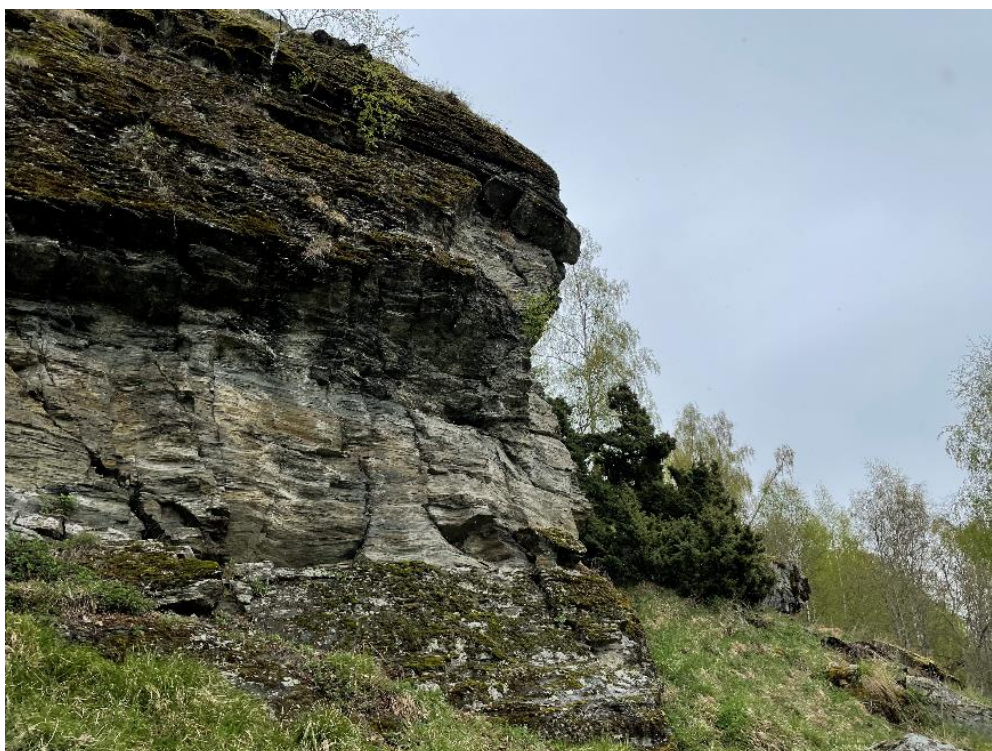
Figur 1-7 Skrentparti med små blokker i utfall, detalj fra figur ovenfor til høyre i foto., Forråbakkan.
