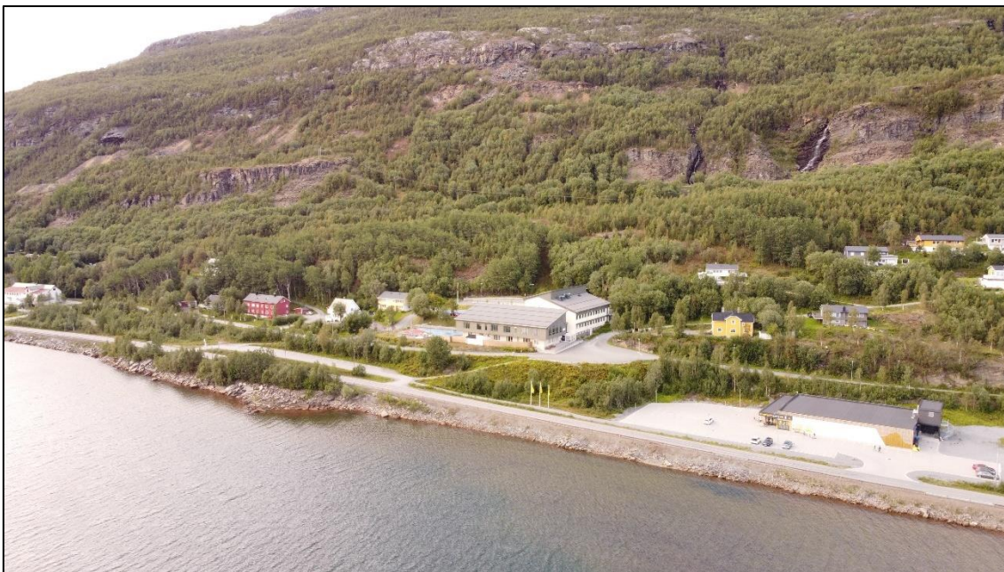
Figur 3: Sulitjelma skole sentralt i bildet. Leirelva og tilførselsbekk renner ned en berghylle bak/over skolen. Gikenveien (ikke synlig i bildet) er plassert langs nedkanten til denne hyllen.
