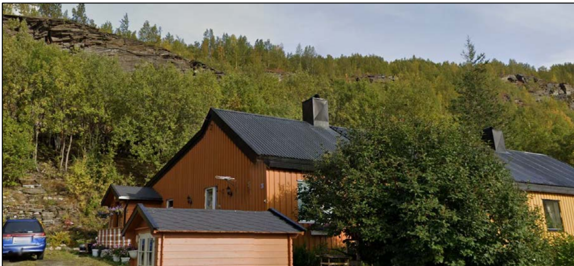
Figur 26: Skrent bak hus på Sjeidehusbakken 69 A og B, Sandnes
