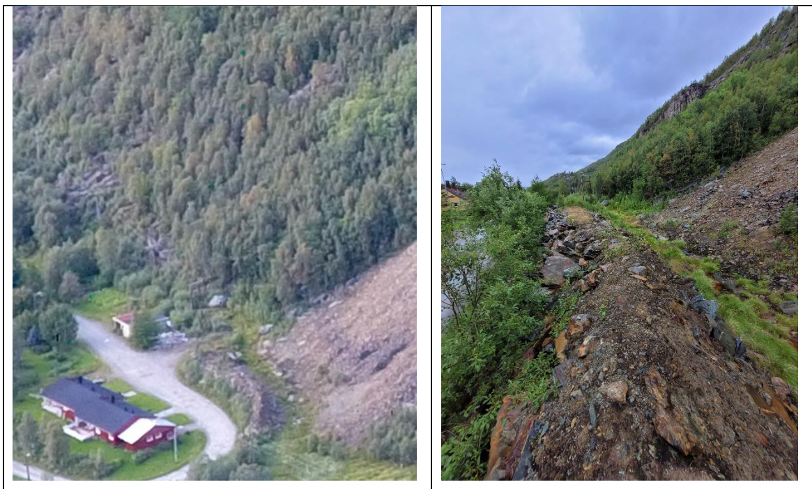
Figur 15: Oversikt og nærbilde av eksisterende skredvoll i nedkant av gruvetipp ved Mons Pettervei 17 og 19.
