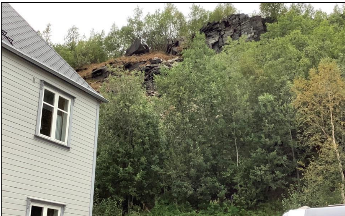
Figur 27: Bratt skrent bak bolig med adresse Sandnes 37.
