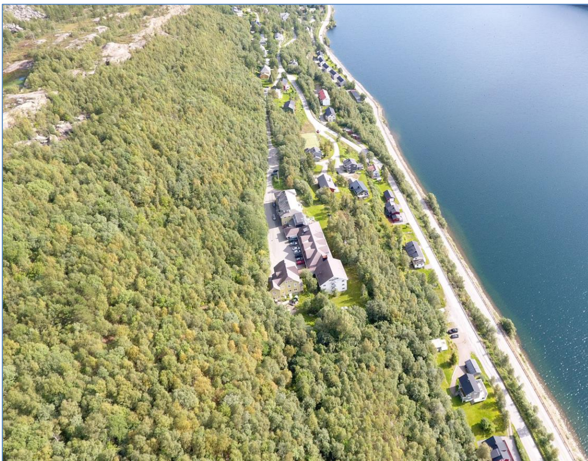
Figur 35: Steinsprang vil kunne nå frem til bebyggelsen ved Sulitjelma Hotel og østover mot Mons Pettervei. Legg merke til den flate hyllen i topp skrent.
