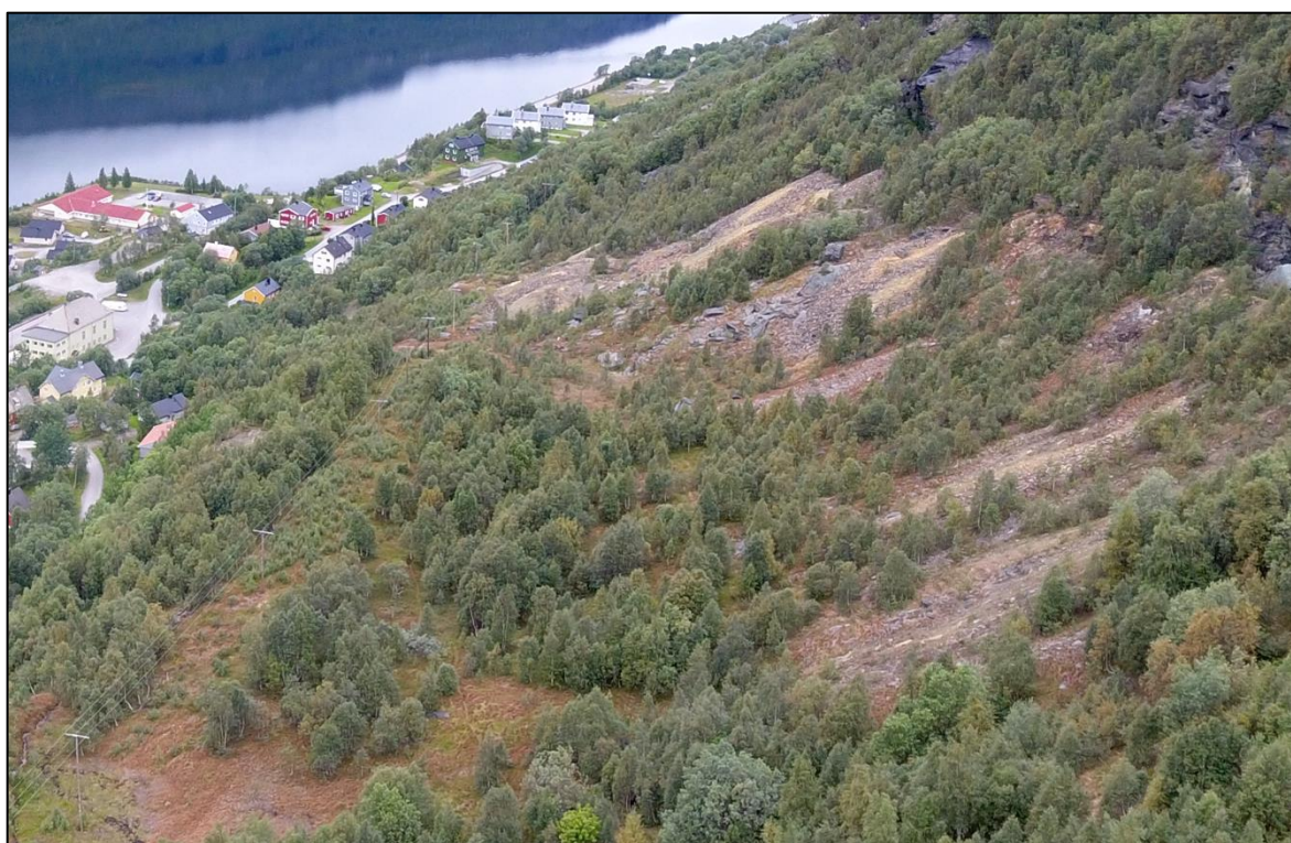
Figur 38: Gamle gruvetipper over bebyggelsen og Gikenveien, like nord/nordøst for kirken. Tippene har ujevne, haugete former med varierende helningsvinkler, og fremstår i all hovedsak som drenerte.
