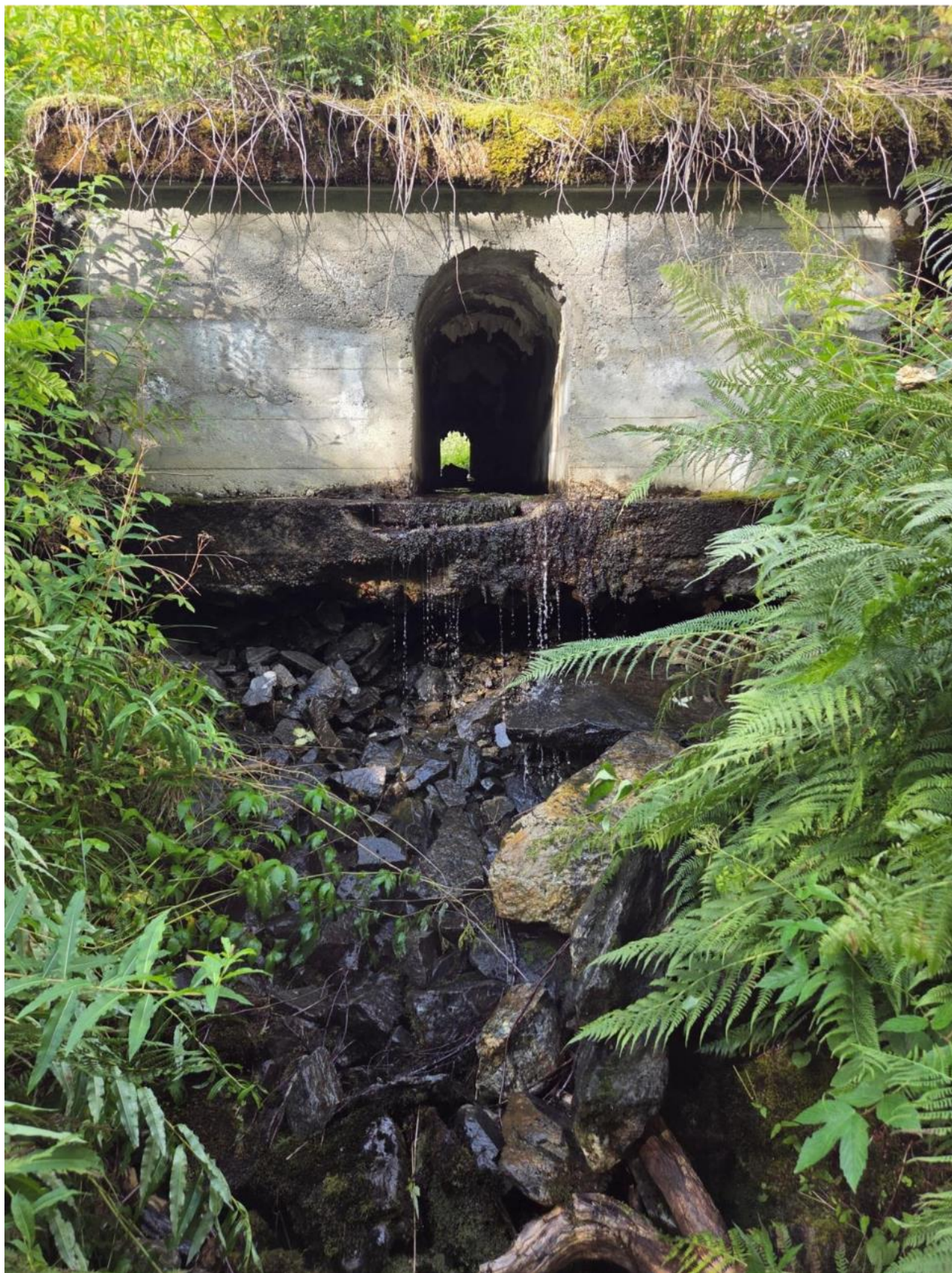
Figur 5-5: En av flere forbilegningsløsninger ved Reitan med uheldig utforming.
