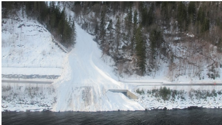
Figur 7.7—1 — Bru bygd som sikringstiltak mot skred. Fv. 37 Tinnsjøvegen, Telemark. Brua er for smal og lav til å ta unna skredmassene. Foto: Audun Langelid, Statens vegvesen.
