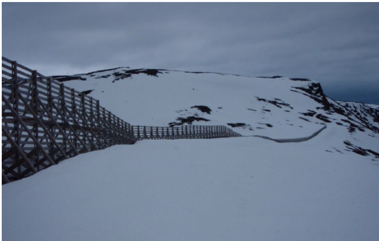
Figur 7.6—1 — Snøskjermer montert for å samle snø på lovart side av skredområdet. Fv. 8050 Nordvågen, Finnmark. Foto: Harald Norem, Statens vegvesen.
