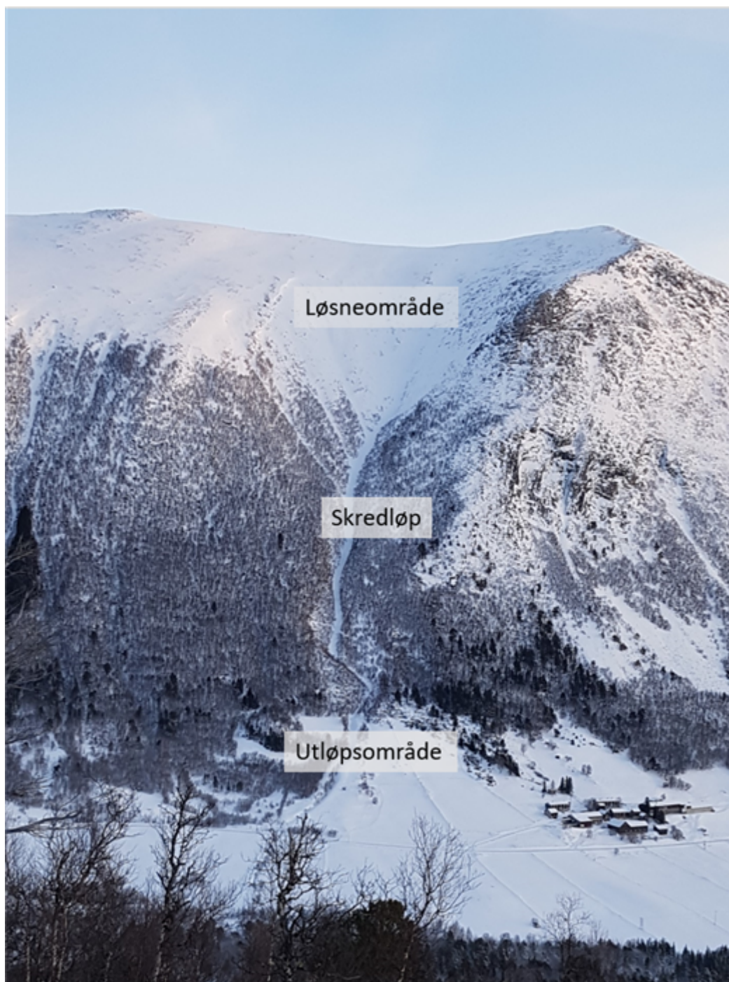
Figur 5—1 — Inndeling av skredbane i løsneområde, skredbane og utløpsområde. Vinndalsfonna, fv. 6514 i Trøndelag. Foto: Eivind Juvik, Statens vegvesen.
