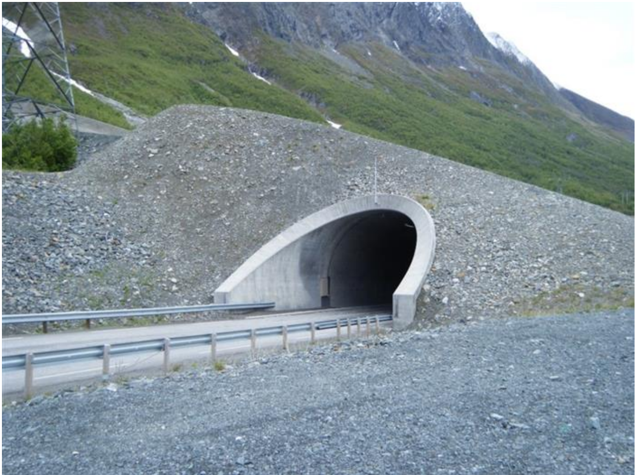
Figur 7.8—1 — Eksempel på skredoverbygg med sirkulær utforming. Fv. 91 ved Ura i Troms. Foto: Gunne Håland, Statens vegvesen.
