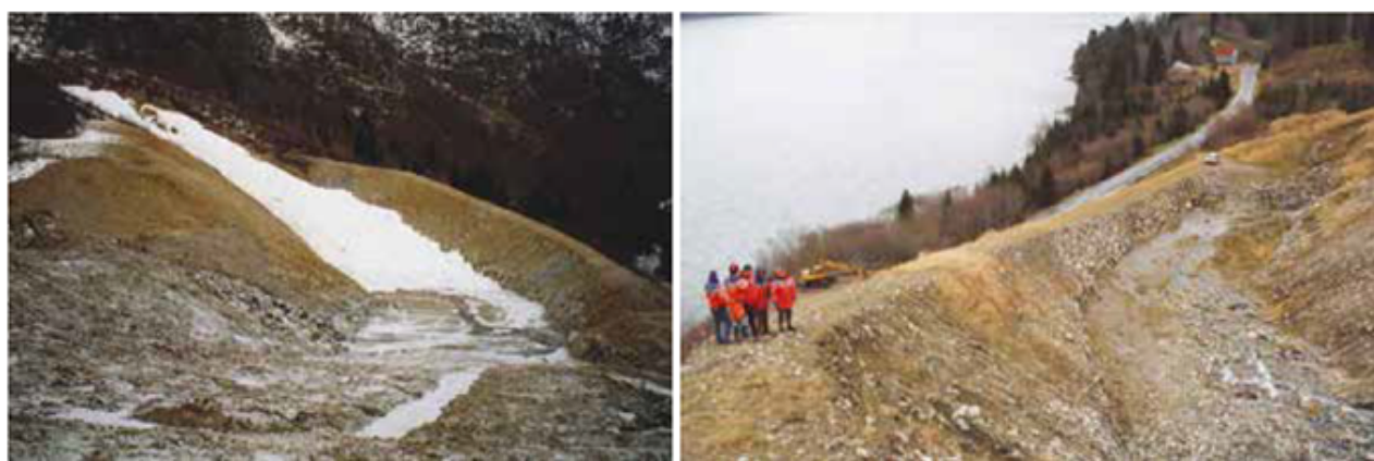
Figur 7.4.2—2 — Eksempel på ledenvoll for sikring mot snøskred og sørpeskred. Vollkrona er ikke bygget med jevn stigning i øvre del av vollen og på dette partiet har skredet gått over vollen. Vinklelen mellom skredet og veten er for stor til at vollen gir god sikringseffekt. Rv.13 Sandvika, Sogn og Fjordane. Foto: Harald Norem, Statens vegvesen.
