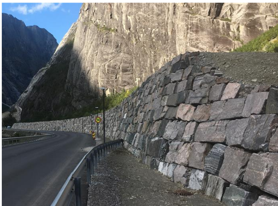
Figur 7.4.3.2—2 — Voll bygget for å sikre mot skredvind. Dølsteinfonna på E136 i Romsdal. Foto: Heidi Bjordal, Statens vegvesen.
