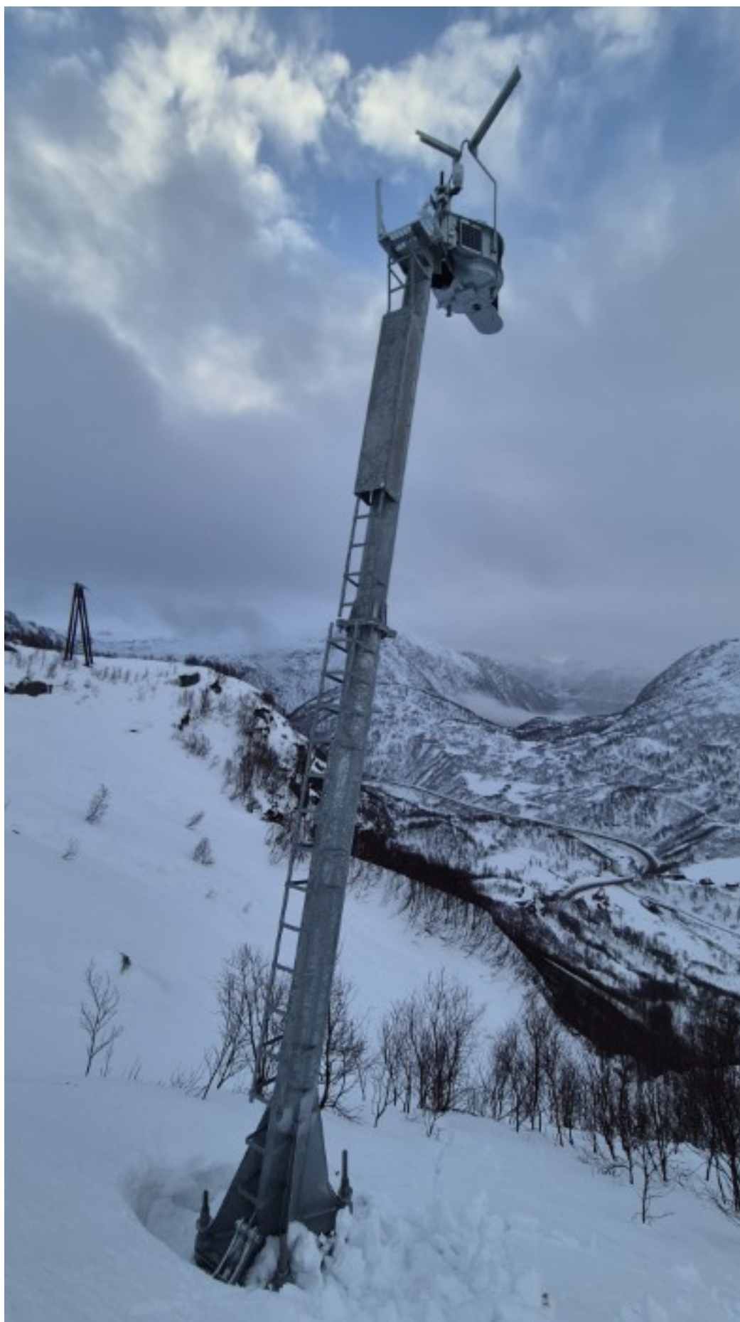
Figur 7.3.1—1 — Snøskredtårn fra Wyssen montert ved E134 over Haukelifjell. Foto: Markus Eckerstorfer, Statens vegvesen.
