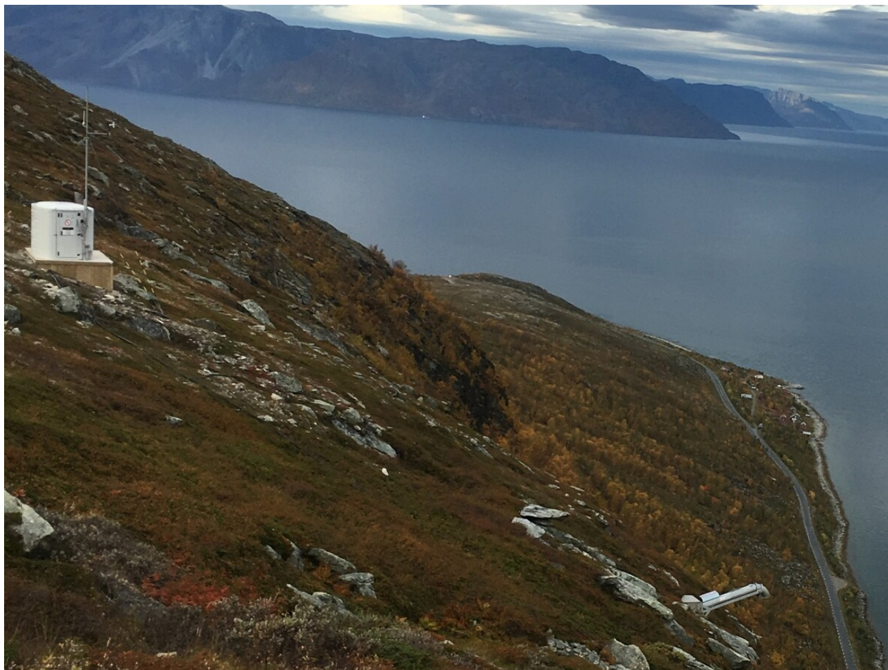
Figur 7.3.1—3 — Øverst: Gasskanoner montert i tilknytning til fv. 883 i Skillefjord i Finnmark. Nederst: Oversiktsbilde som viser teknisk bygg montert i bakkant av gasskanonene i Skillefjord. Bygget inneholder styringsenhet, batterier og gass for anlegget. Foto: Heidi Bjordal, Statens vegvesen.
