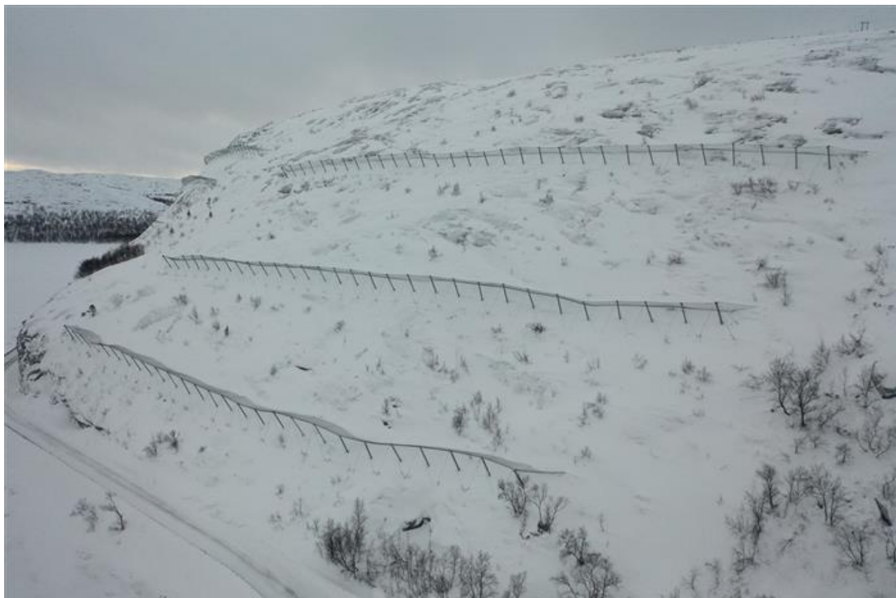
Figur 7.5—2 — Sikring med snønett langs fv. 8110 ved Svartaksla i Finnmark. Foto: Trond Jøran Nilsen, Finnmark fylkeskommune.
