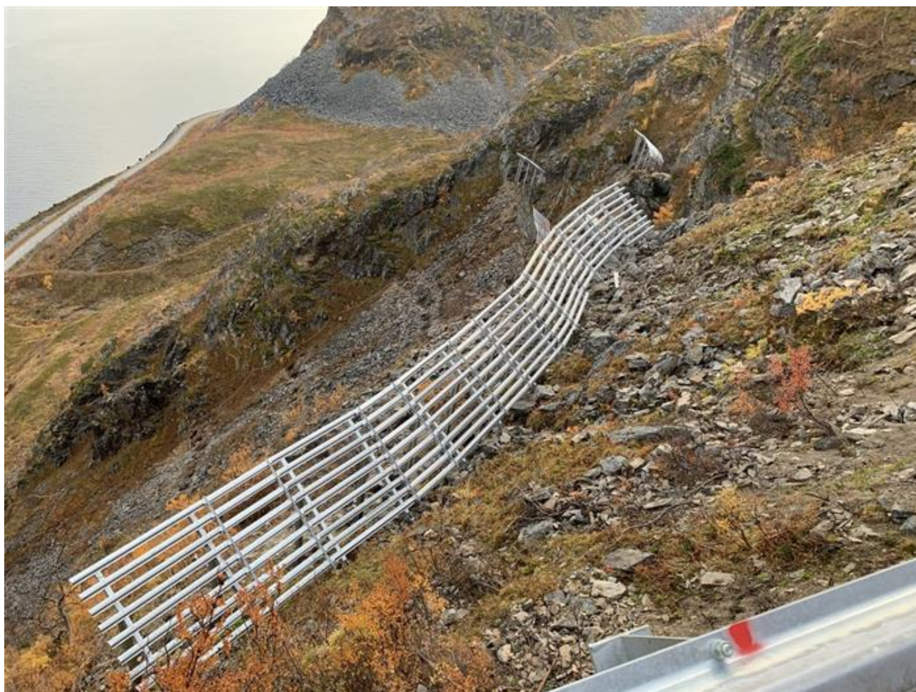
Figur 7.5—1 — Sikring med stive stålbroer langs fv. 8074 ved Ivarsfjord i Finnmark. Foto: Trond Jøran Nilsen, Finnmark fylkeskommune.
