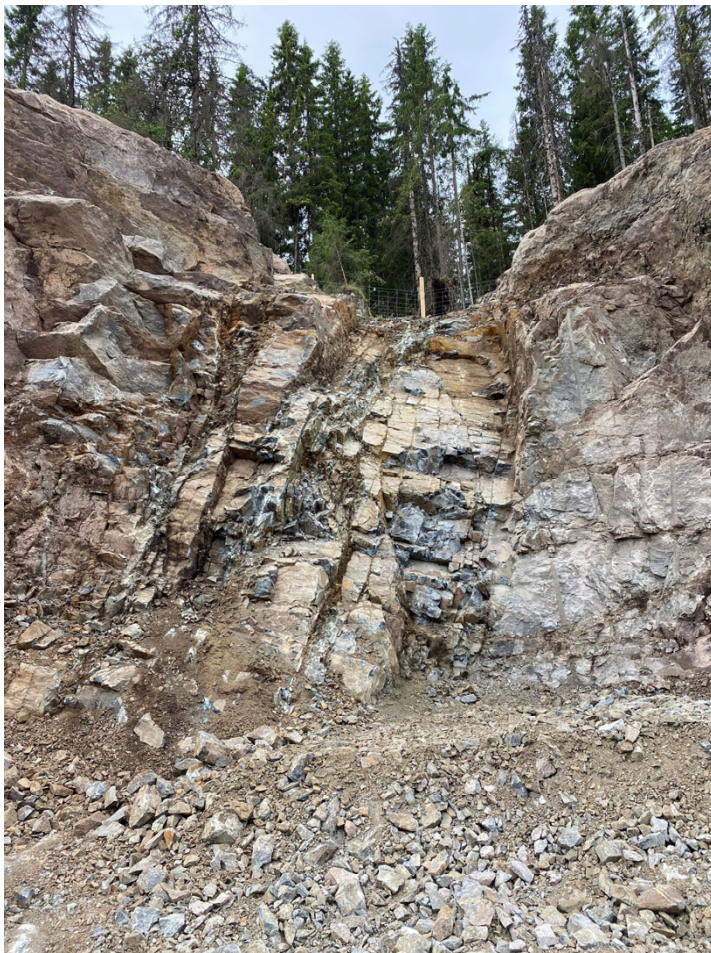
Fig. 6 Svakhetszone i rombeporfyr på E16 Sandvika-Skaret-prosjektet.
