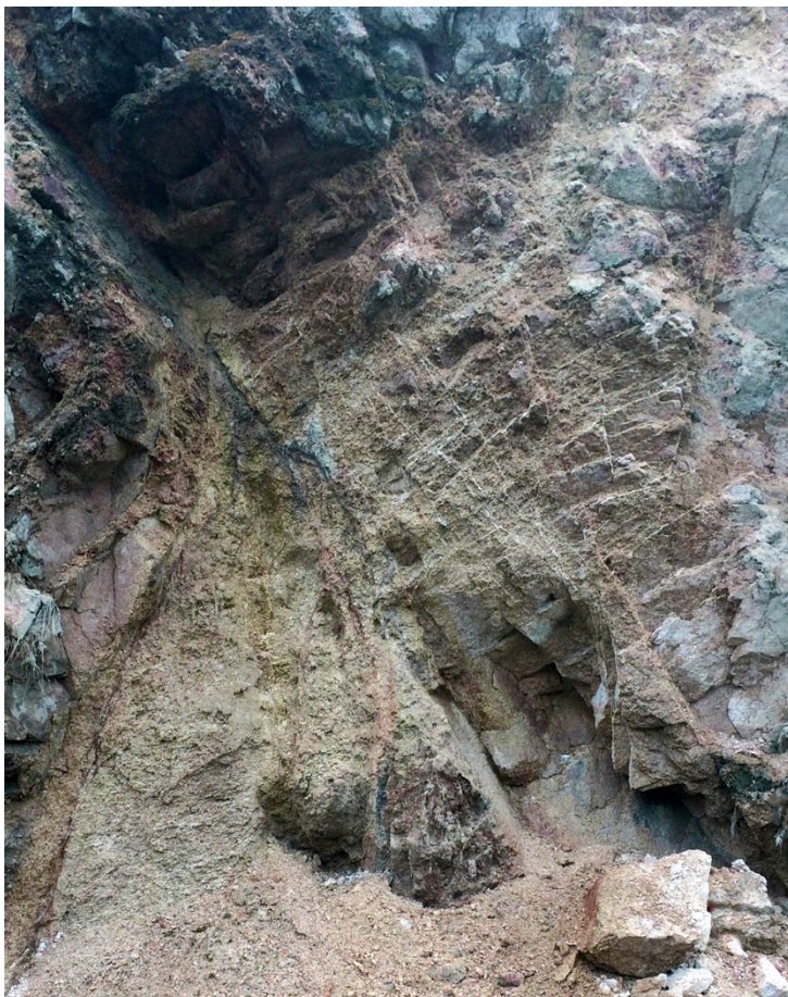
Fig. 11 Veiskjæring rett utenfor Drammen. Svakhetssonen krysser Kleivenetunnelen på E18
