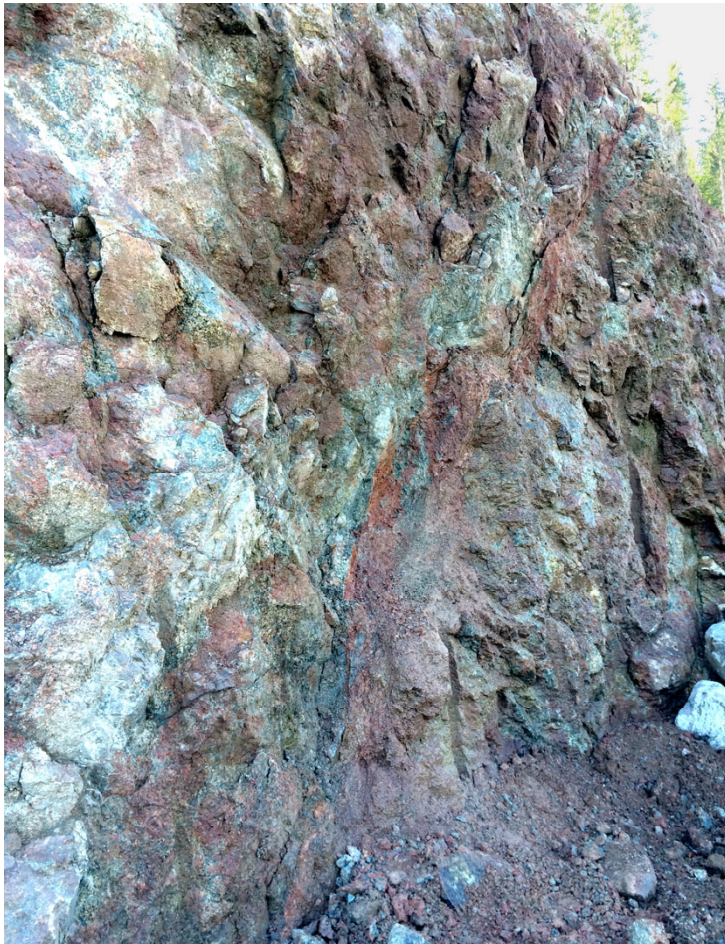
Fig. 10 Veiskjæring rett utenfor Martineåstunnelen på E18 Bommestad–Sky-prosjektet nært Larvik
