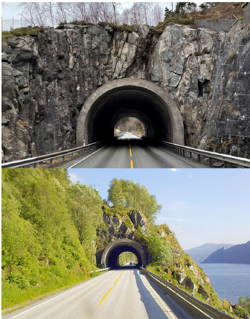
Fig. 16 Kleinslåtntunnelen på E16 i Vaksdal kommune mellom Bergen og Voss. 55 meter lang og åpnet i 1970. Typisk eksempel på vegtunnel drevet etter prinsipper fra vannkraftutbyggingen. Bergsikret med bolter og noe sprøytebetong. Over: Sett fra sør. Under: Sett fra nord.
