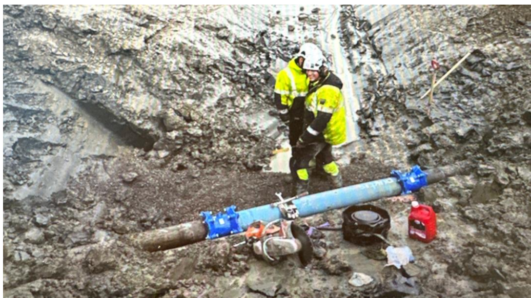
(kommunalteknikk drift ved bruddområdet 27.05)
