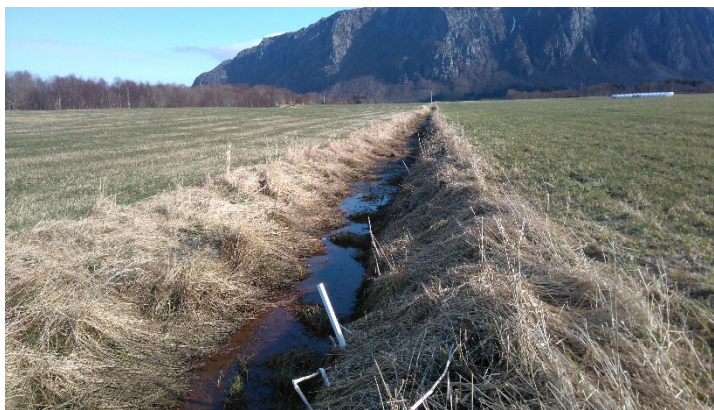
Figur 1-7 Bilde av kanalen nokre år seinare. Grasvekst har medverka til stabilisering, og vasstraumen i kanalen har liten eroderande kraft. Grasvekst på kantane av kanalen kan etter kvart koma til å redusere fri overflateavrenning av vatn til kanalen.
