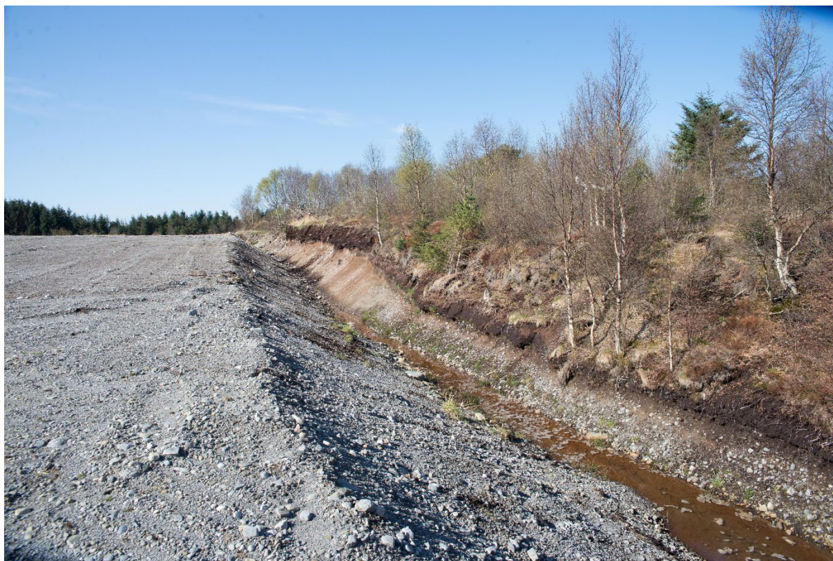
Figur 1-8 Bildet viser ein enno ikkje ferdigstilt kanal på andre sida av teigryggen, på ein del av arealet som ligg få meter høgare i terrenget. Mineralmassen har sterkt vekslende men stadvis høgt innhald av fråsikt (grus og småstein). Sand utgjer hovudfraksjonen, dominert av grovsand og mellomsand, noko silt og lite leire.
