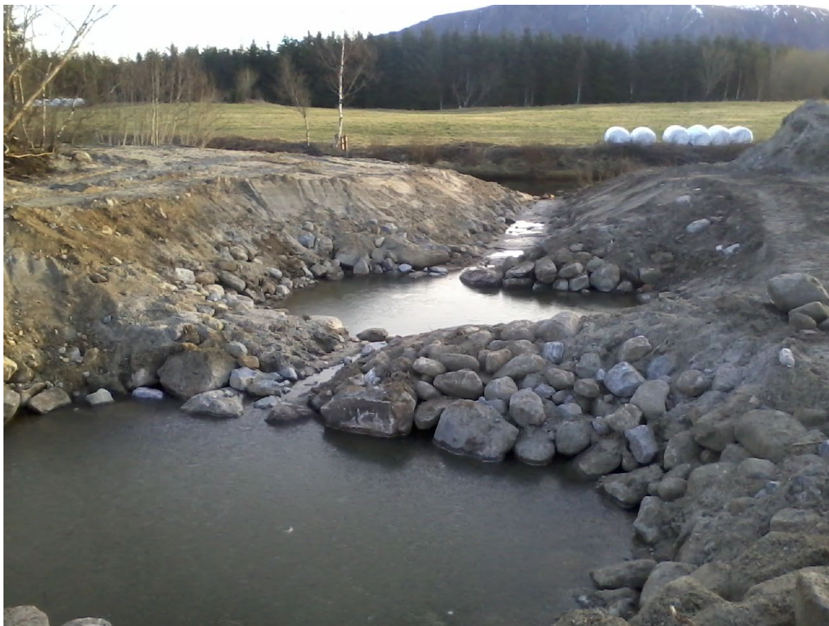
Figur 1-10 Fangdammar for sedimentering av erodert materiale med næringsstoff i tilknytning til kanal. Sedimentert materiale i fangdam etter oppreinsking er eigna som jordforbetrande materiale.
