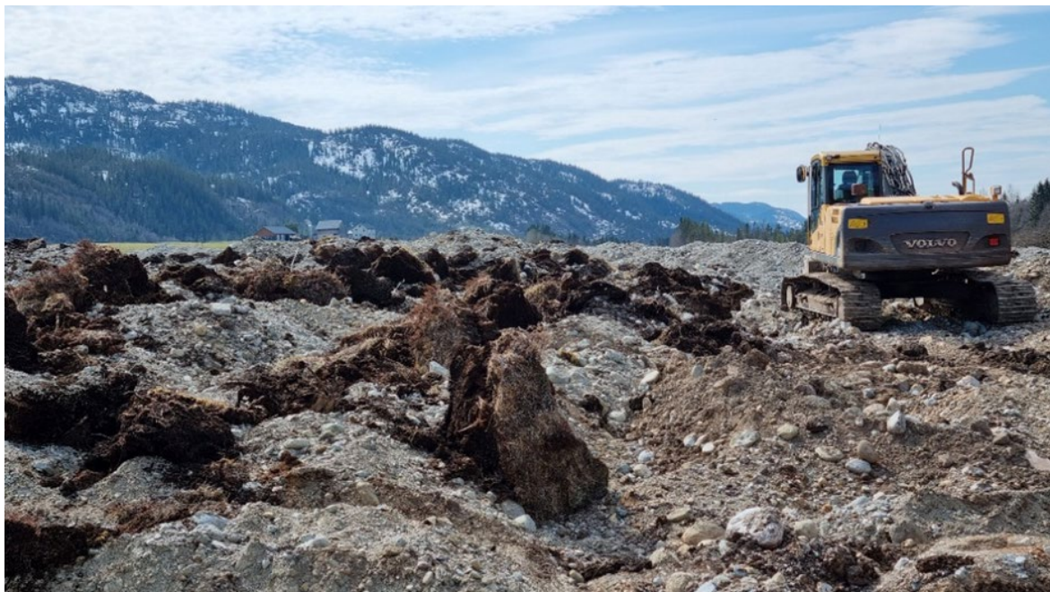
Figur 1-13 Areal under omgraving i området Myran, Indre Fosen. Ved omravinga er laget av mineralmasse frå undergrunnen som er lagt oppå nedgravd torvlag så tjukt at areala vert karakteriserte som mineraljord ved jordsmonnkartlegging.
