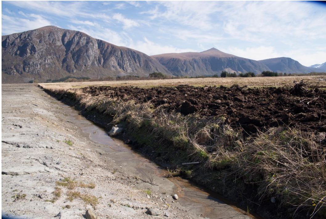
Figur 1-6 Bildet viser utfordringer i arbeidet knytt til omgraving og graving av kanal på eit areal der det er stor del finsand, i tillegg til mykje silt og noko leire. Karakterisering av tekstur veksla mellom siltig finsand, lettleire og siltig mellomleire. Materialet har liten stabilitet, og ein ser erosjonsspor og vanskar med stabil kanalkant. På andre sida av kanalen er det areal som ikkje er omgravid, og som er drenert med røyrgrøfter.
