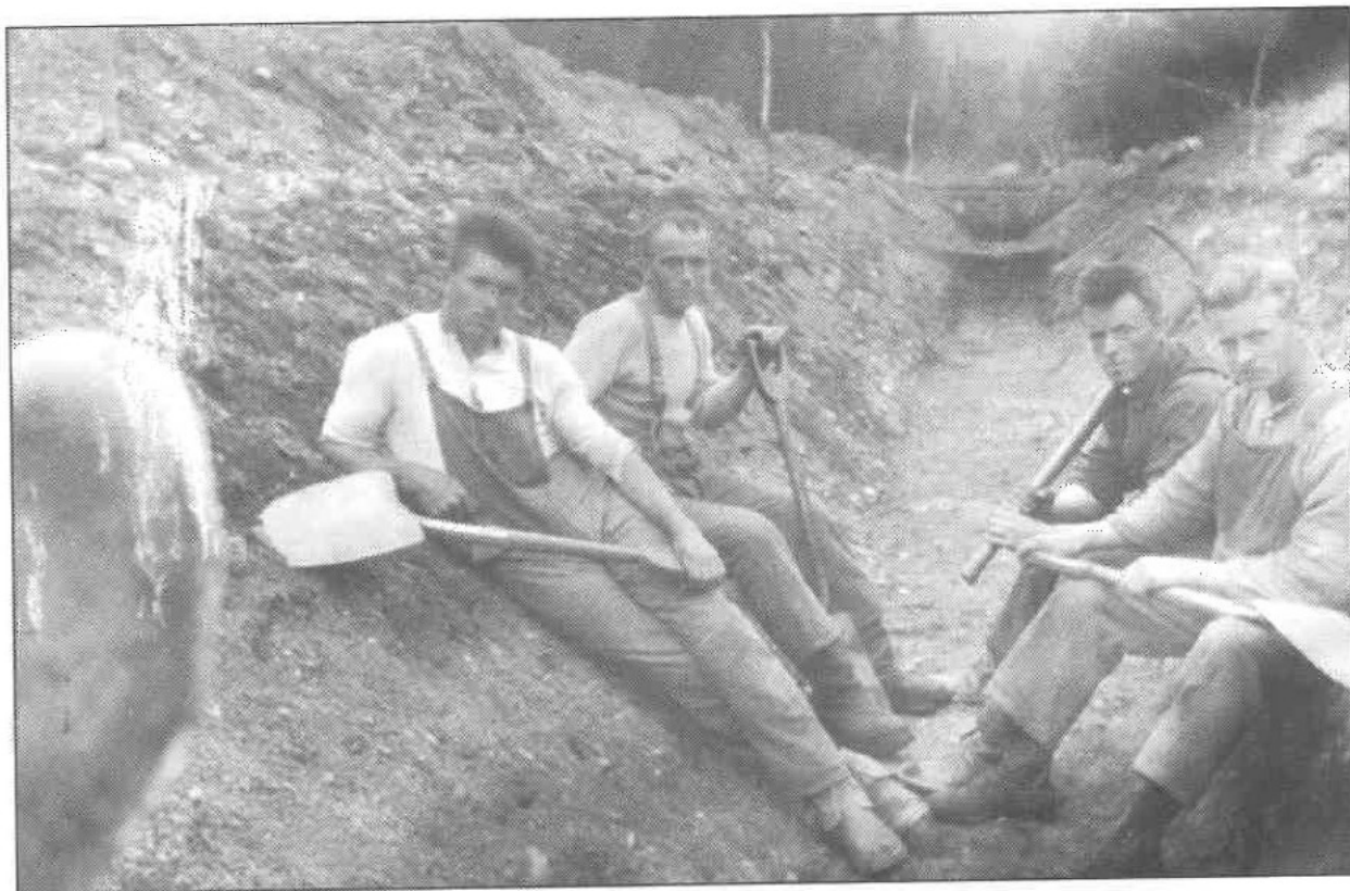
Graving av hovedavløpskanalen (Storkanalen) mellom Oppheim og Vollan. Kanalen er 1 m bred i bunnen nær 2 m dyp. I overflaten er den ca. 5 m bred. Alt oppkastet for hand. Personene i kanalen fra venstre: Aksel Lyngseth, Johan Arent Berget, Sigurd Tangstad, Paul Aune.
