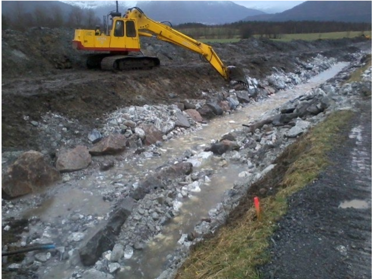
Figur 1-9 Steinsetjing og plastring av kanal for å hindra erosjon på areal med omgravd myr. Risiko for erosjon er særleg stor når mineralmaterialet i botn og sidene av kanalen har mykje silt og sand, og det tidvis er stor vassføring med eroderande kraft. Det er Ole Eidsæter som utførte arbeidet. Ole Eidsæter har utført mykje omgravingsarbeid i Møre og Romsdal.
