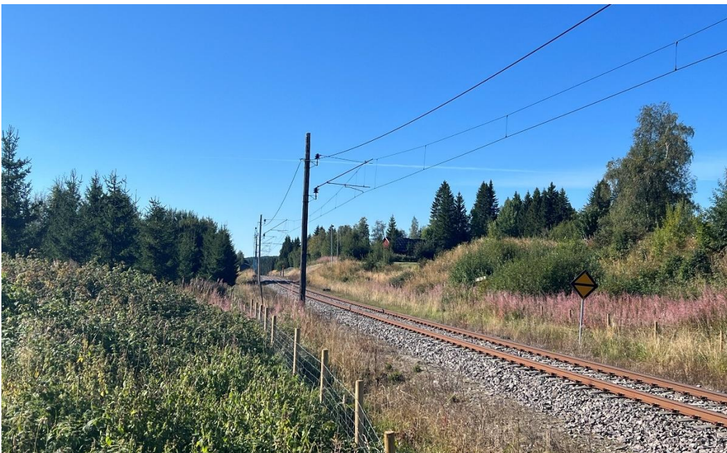
Siktforhold fra planovergangen i retningen toget kom ifra. Foto: SHK
