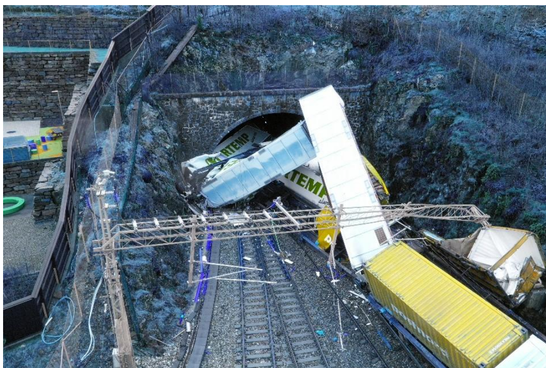
Avsporede vogner i tunnelåpningen til Arnanipatunnelen. Foto: SHK
