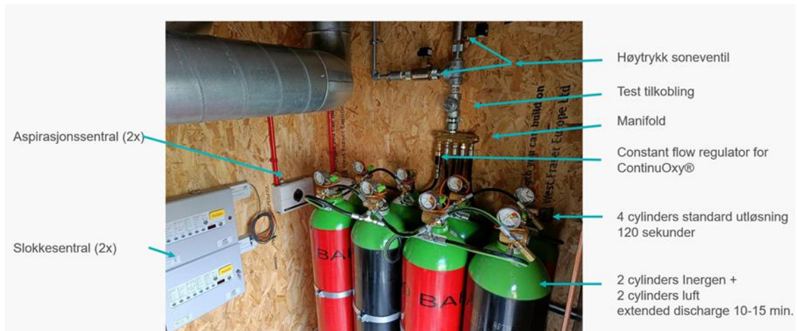
bilde 13 Flaskebanken Bøheiveien
