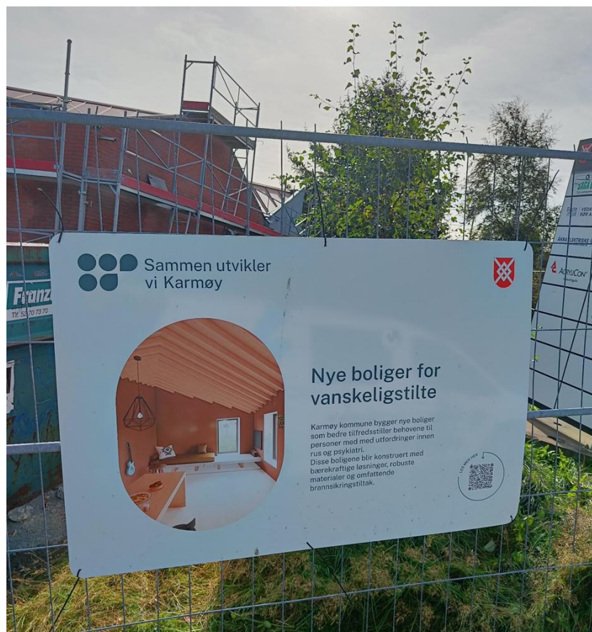
bilde 2 Fra byggeplassen Bøheiveien
