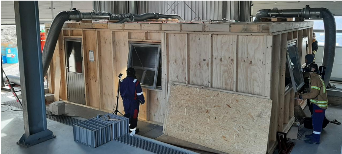
bilde 10 Fra branntester i leiligheten i Hall of flame HVL
