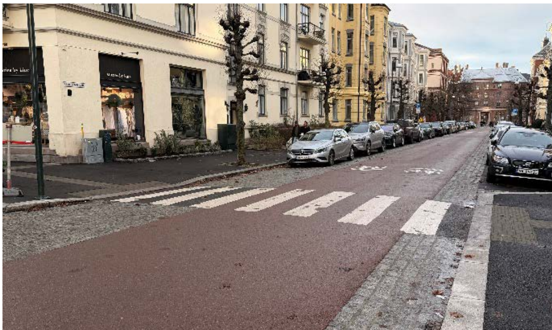
Figur 2.1: Løvenskiolds gate kjennetegnes av et vanlig gangfelt med nedfelt fortau, brosteinskant, smal veibane med rød asfalt, ledelinjer, og markering av gangfelt over en sykkelprioritert gate.
