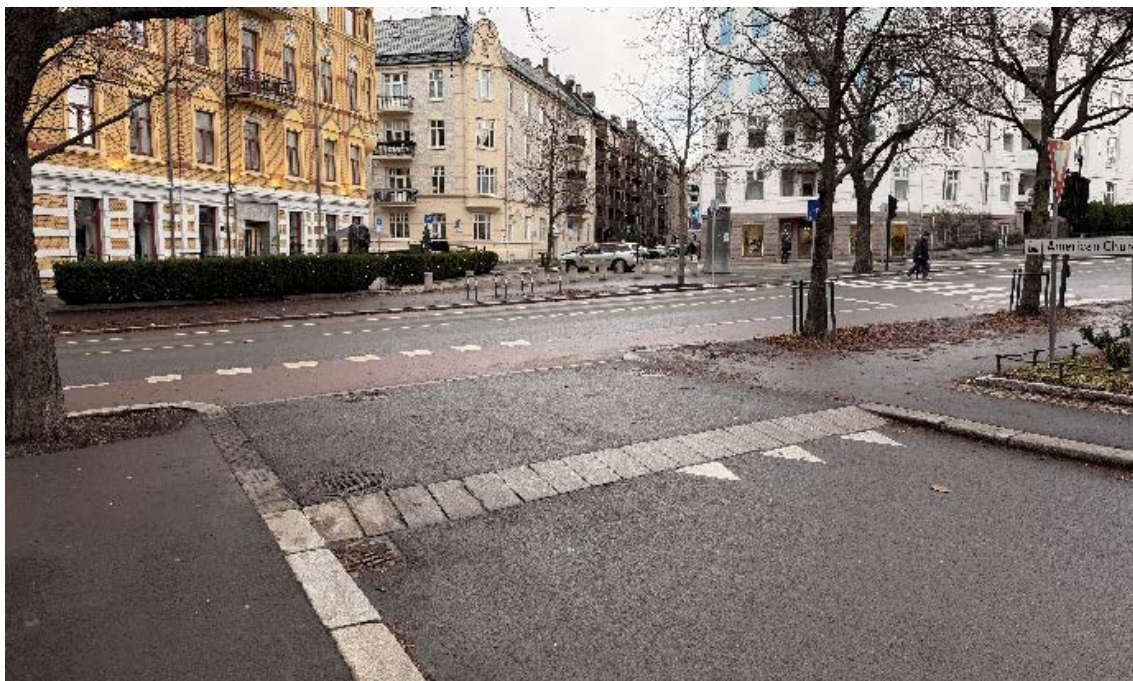
Figur 2.3: Gjennomgående fortau ved Fritzners gate har en enkel varsellinje i kontrasterende farge og asfalt både på fortau og overgang.
