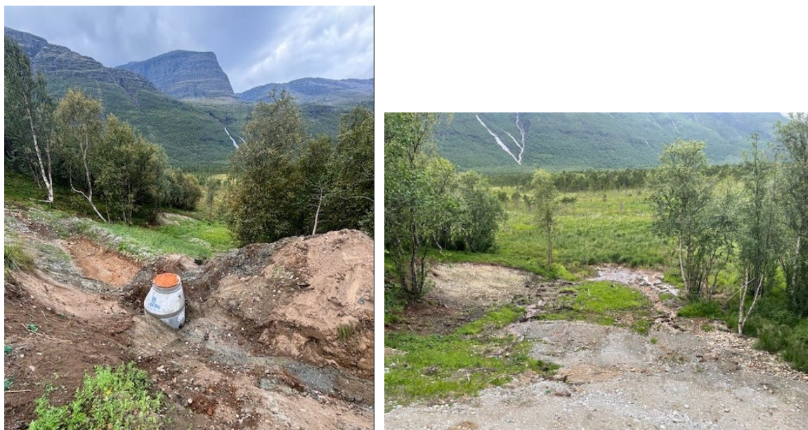
Figur 9. Tiltak 2024: Ny sigevannskum nedstrøm for deponi som samler opp vann i drenerør under deponi er etablert. Vannprøve pkt. 2 i kart figur 4.
