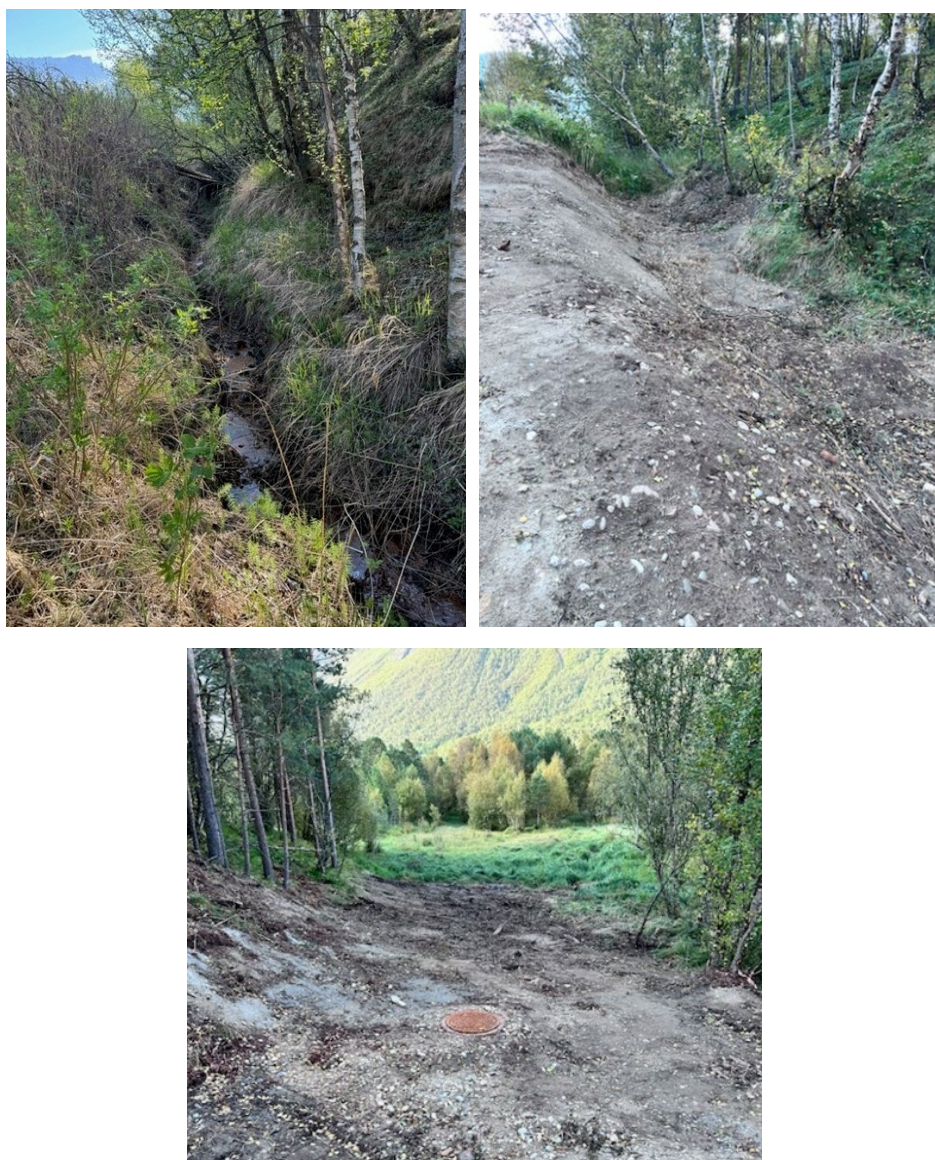
Figur 10. Tiltak 2024: Utsigsbekk til myr på motsatt side av miljøbrønn 3 er stoppet og lagt i rør til kum. Nye vannprøver kan analyseres her.
