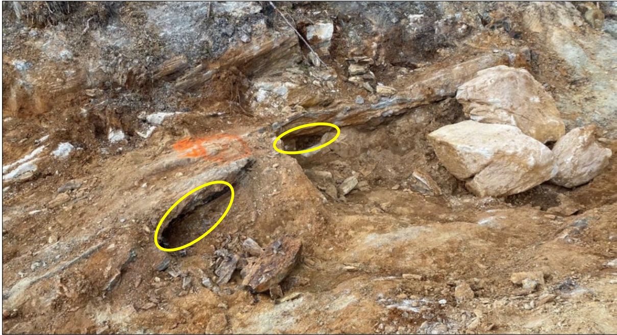
Figur 10: Inni svakhetssona med den sterkt forskifra karbonatbergarten, gule ellipser, ble det gjort funn av ertsmineraler. Foto mot nordvest fra ca. profil 8995.
