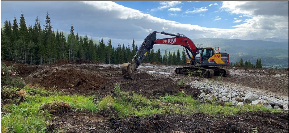
Figur 16b. Anlegging av planlagt deponi. Om lag 50 meter øst for ca. profil 8700 er man i gang med å etablere planlagt deponi. Sikt mot øst. Foto: Statens vegvesen.
