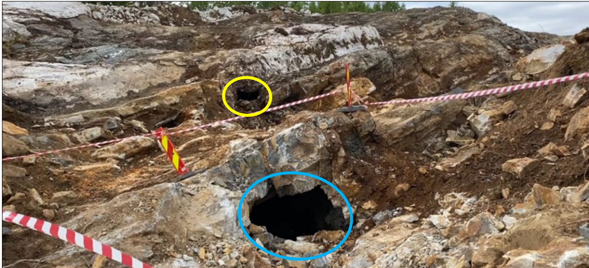
Figur 11: Foto av gruvesjakt mot nordvest. Sjakta går diagonalt langs S4-strukturene mellom profil 8980 i CL, blå ellipse, til ca. profil 8985, gul ellipse. Gruvesjakta har bredde 1,5 – 2,0 meter. Se også kart figur 5. Foto SVV.
