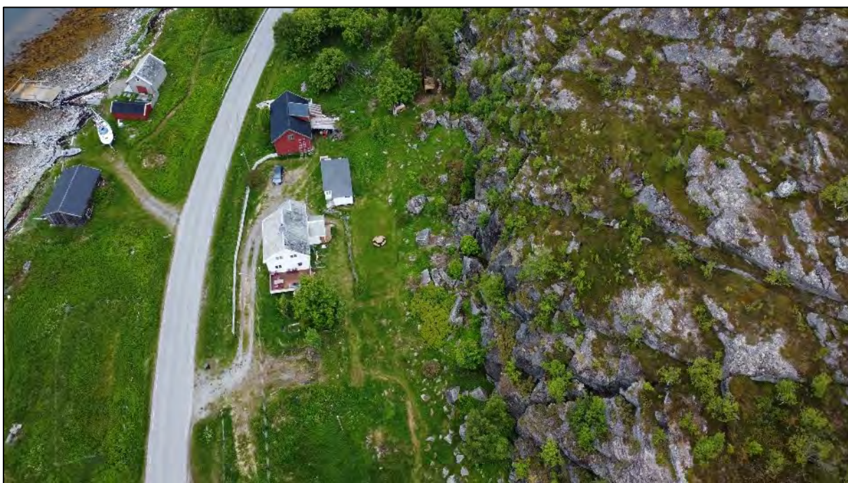
Figur 9: Skråning bak Kvibyveien 100 med blokker i nedkant
