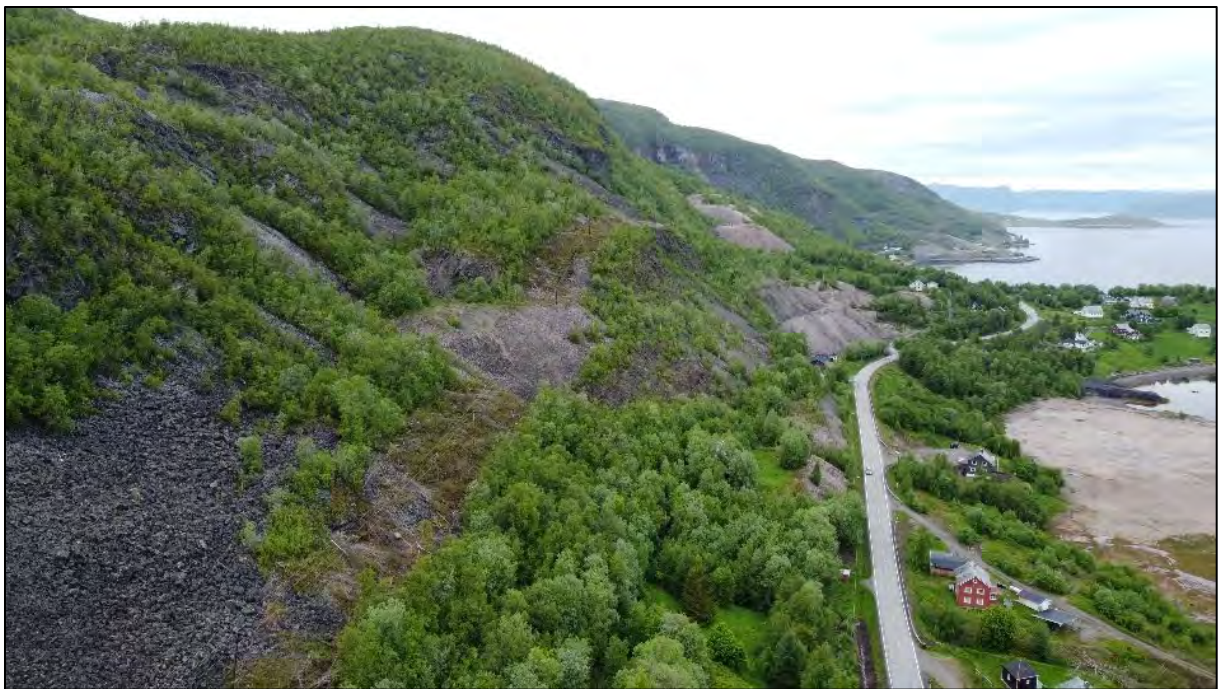
Figur 7: Steinsprangur og fyllmasser, sett mot nord.
