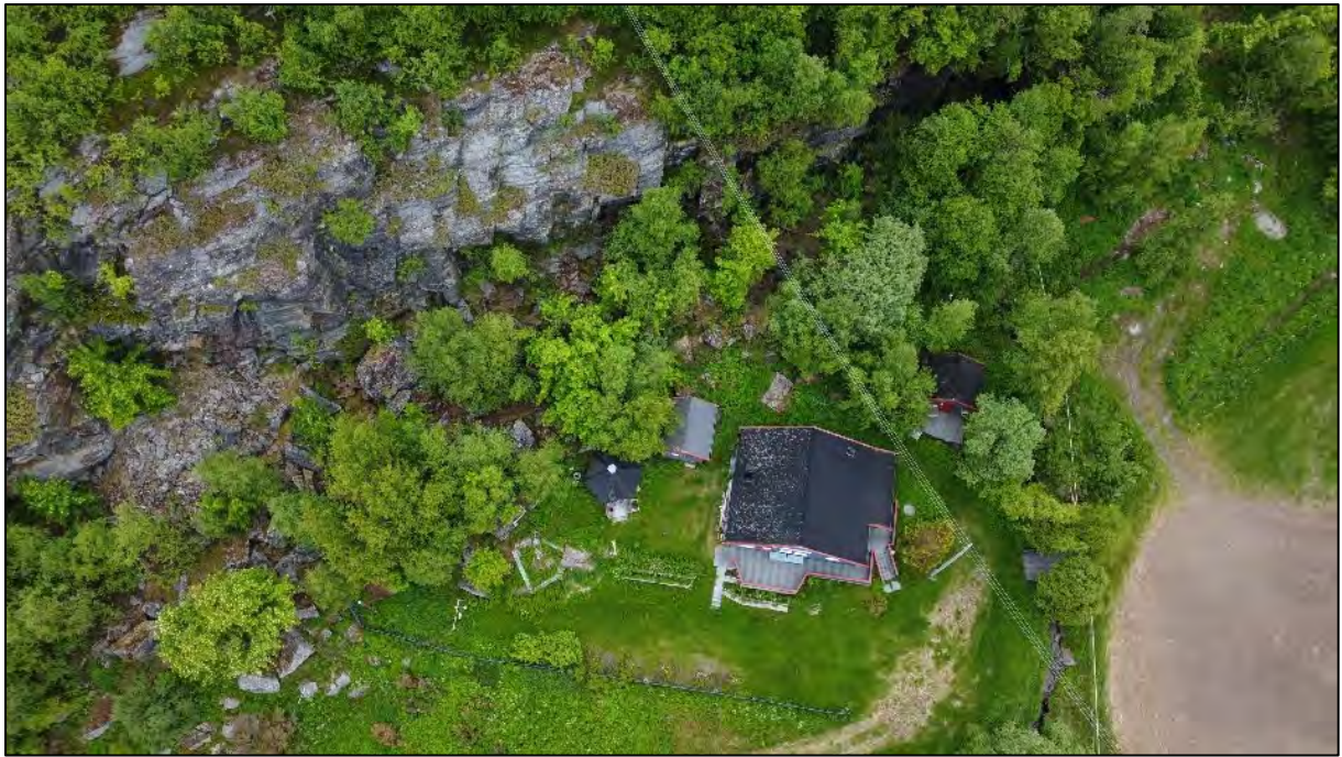
Figur 3: Skråning bak Kvibyveien 96 med blokker i nedkant
