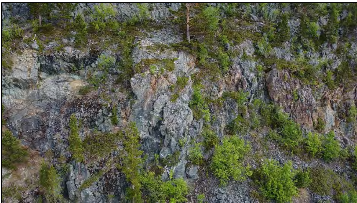
Figur 13: Bildet viser løsneområder for steinsprang i sentrale deler av påvirkningsområdet. Samme område som Figur 12, men sett fra en annen vinkel.
