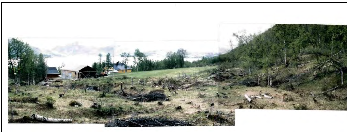
Figur 23: Bilde hentet fra NGI rapport (NGI, 2000) som viser til skredskadet skog som følge av snøskred i 1997 og 2000. Snøskred fra 1997 skal ha gått helt ned til bygningen i venstre i bildet og inn på innmarka ovenfor våningshuset. I 2000 skal snøskred ha nådd omtrent ned til gjerdet mot innmark.
