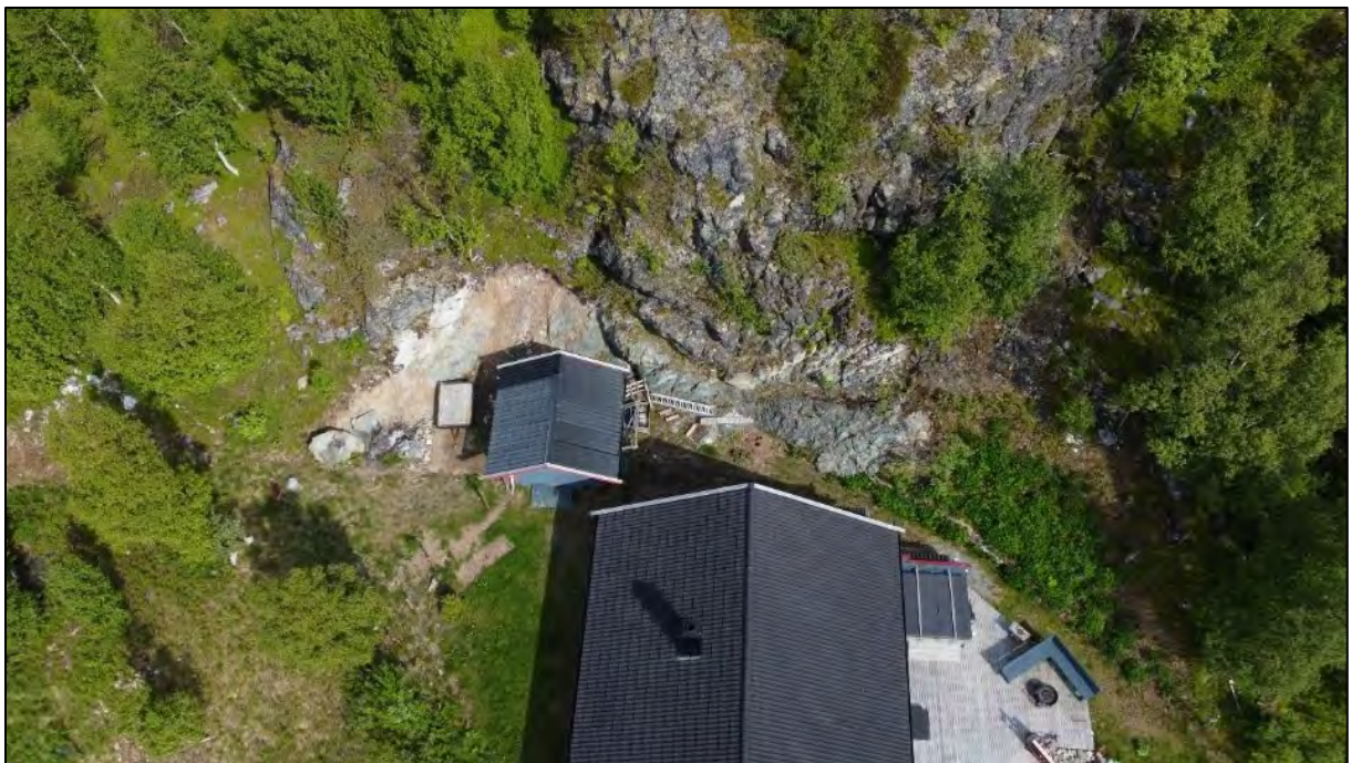
Figur 9: Basnjarga nr. 9, og skråning i bakkant
