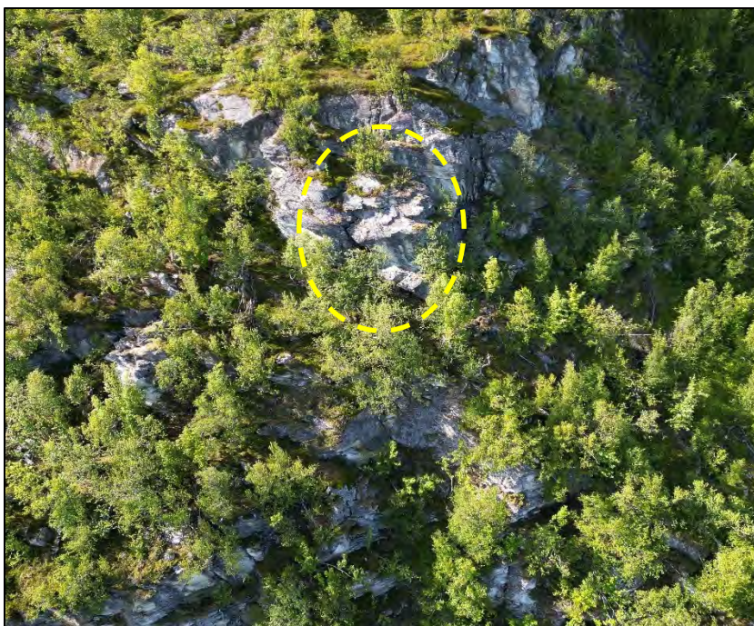
Figur 3: Delvis avløst parti i skrent nord i påvirkningsområdet (merket med gult omriss), ca. 100 m nord for nordlig grense til kartleggingsområdet. Delvis avløst parti er vurdert til å være ca. 50 m 3 . Dronebildet ser mot nordvest.
