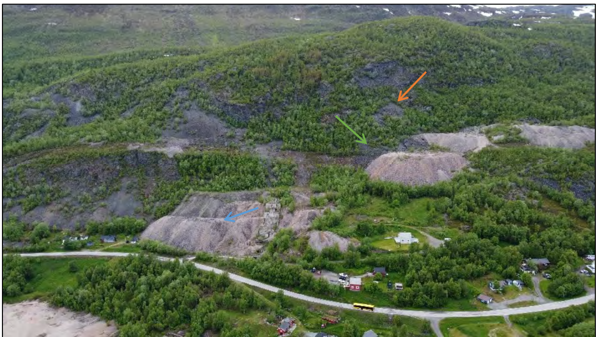
Figur 3: Bildet er tatt i nordlige del av området, nær Figur 2. Oransje pil viser steinsprangur, blå pil viser fyllmateriale, grønn pil viser forvittringsur.
