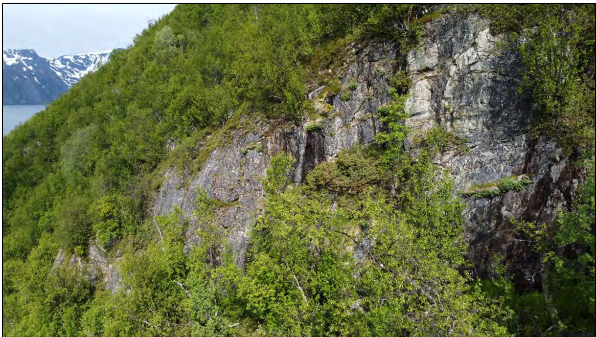
Figur 13: Skrenter i nordvestlige del med løsnesannsynlighet større enn 1/100
