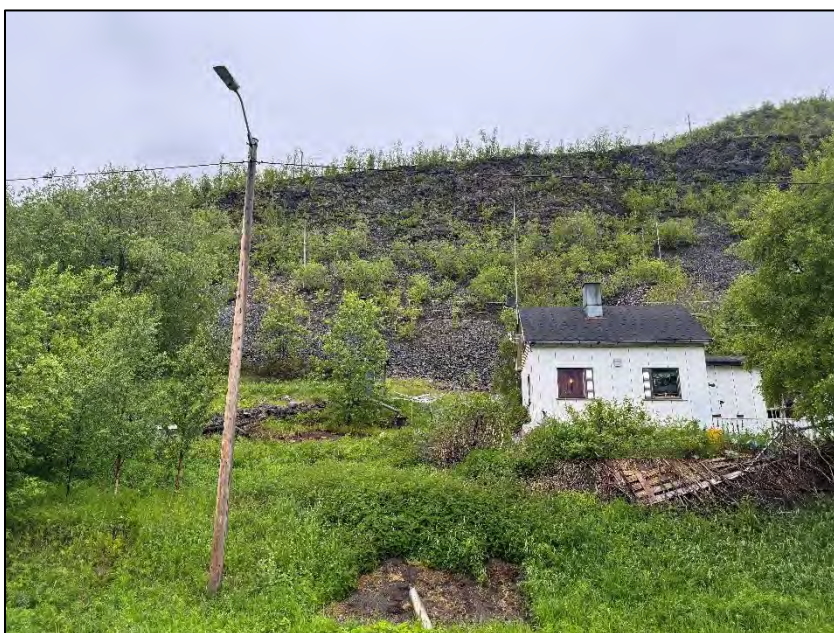
Figur 9: Bildet viser Kåfjordbotn 107 og skråningen bak. Vi tolker at skjæringa bak huset er delvis menneskeskapt og at ura består av både fyllmasser og steinsprangavsetninger.
