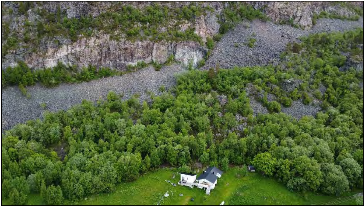
Figur 9: Russluftveien 380. Steinsprangavsetninger og løsneområder for steinsprang i fjellsiden. Noen observerte moreneblokker tett innpå bygningen.
