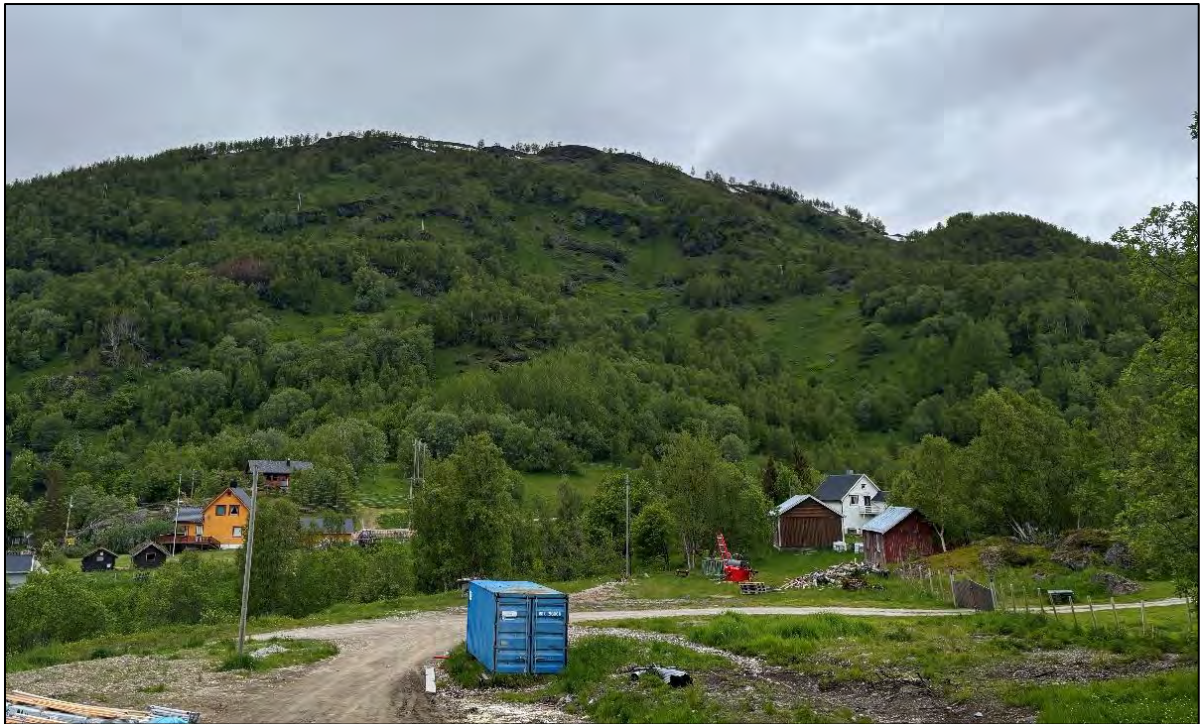
Figur 3: Vestlig del av påvirkningsområdet sett fra øst. De åpne områdene i øvre og venstre del av bildet representerer mulige løснеområder for snøskred og stedvis jordskred. Ingen skredskadet skog eller andre ferske avsetninger ble observert under befarig.
