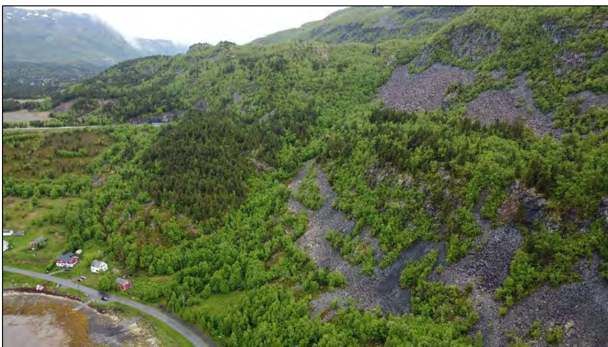
Figur 15: Bildet viser midtre og sørlige del av området, hvor det er løsneområder for steinsprang og steinsprangur. Bildet er tatt mot sør.
