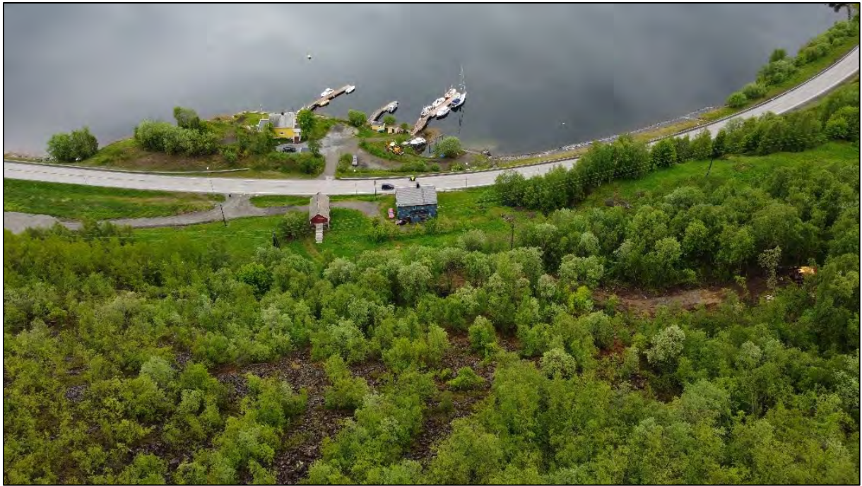
Figur 7: Bildet viser utstrekning av ur ned mot Kåfjordveien 577. Bildet er tatt mot sør.
