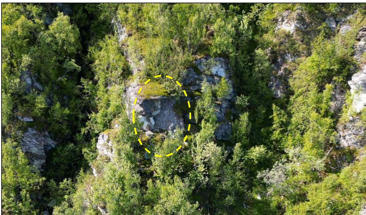
Figur 4: Dronebilde tatt mot vest av skrent i nordlig del av påvirkningsområdet, og ca. 100 m nord for nordlig grense av kartleggingsområdet. Arr etter trolig utfall av blokk er merket med gult omriss.
