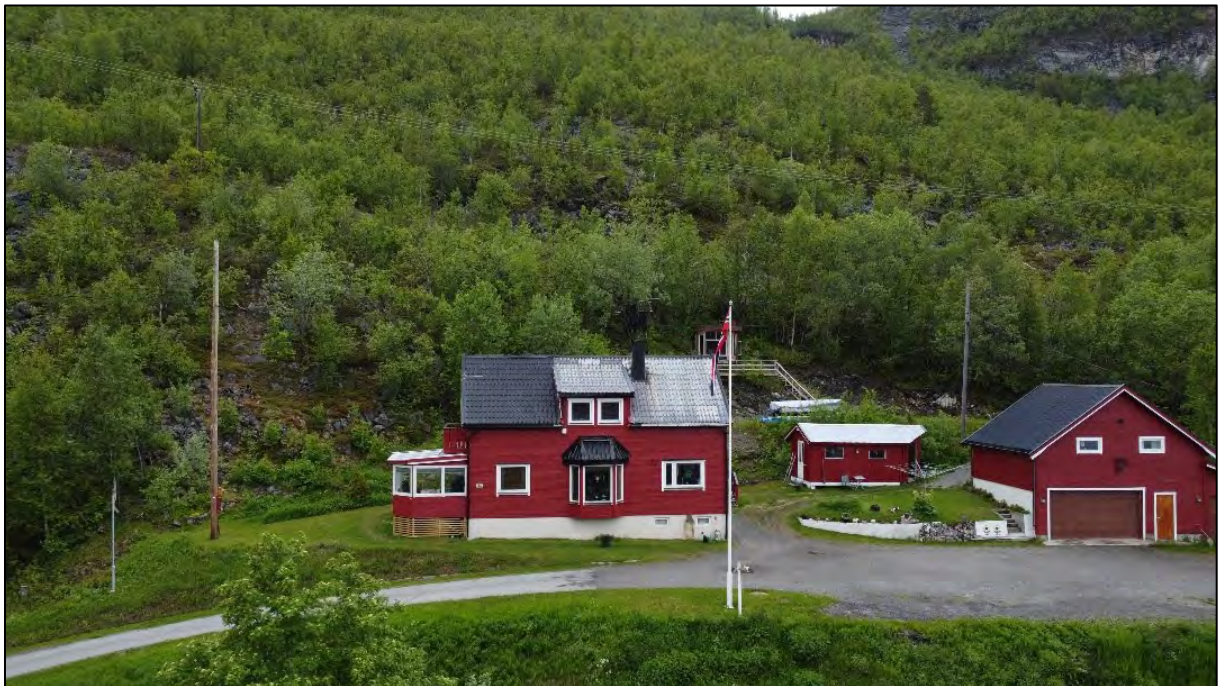
Figur 8: Bildet viser Kåfjordveien 567 og 569, og skråningen i bakkant. Bildet er tatt mot vest.
