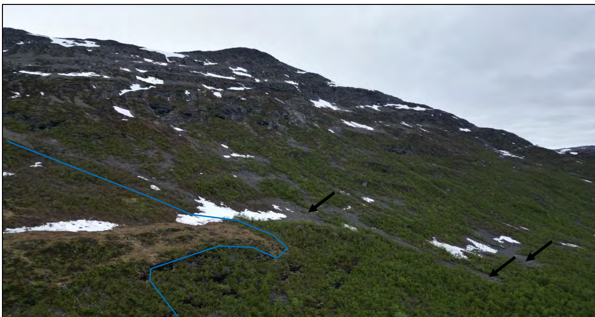
Figur 3: Nordøstlig og øvre del av påvirkningsområdet ses skrått fra SV. Omriss av observert skredskadet skog er merket med blå linje, og steinsprangavsetninger er vist til med svart pil. Øvre deler av snøskredskadet skog til venstre i figur 1 ses her til venstre i figuren.
