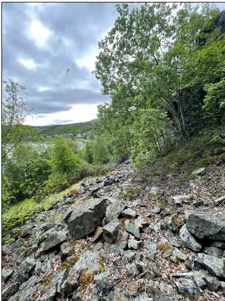
Figur 12: Bildet viser steinsprang- og forvittringsur nedenfor skrent i midtre/nordlige del av området 15-25 moh.
