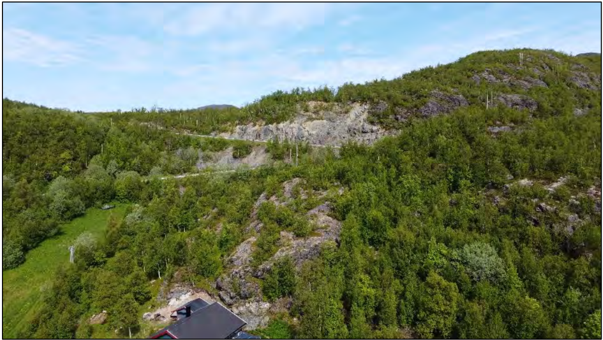
Figur 14: Vegen over til Komagffjord, med vegskjæring i øvre del
