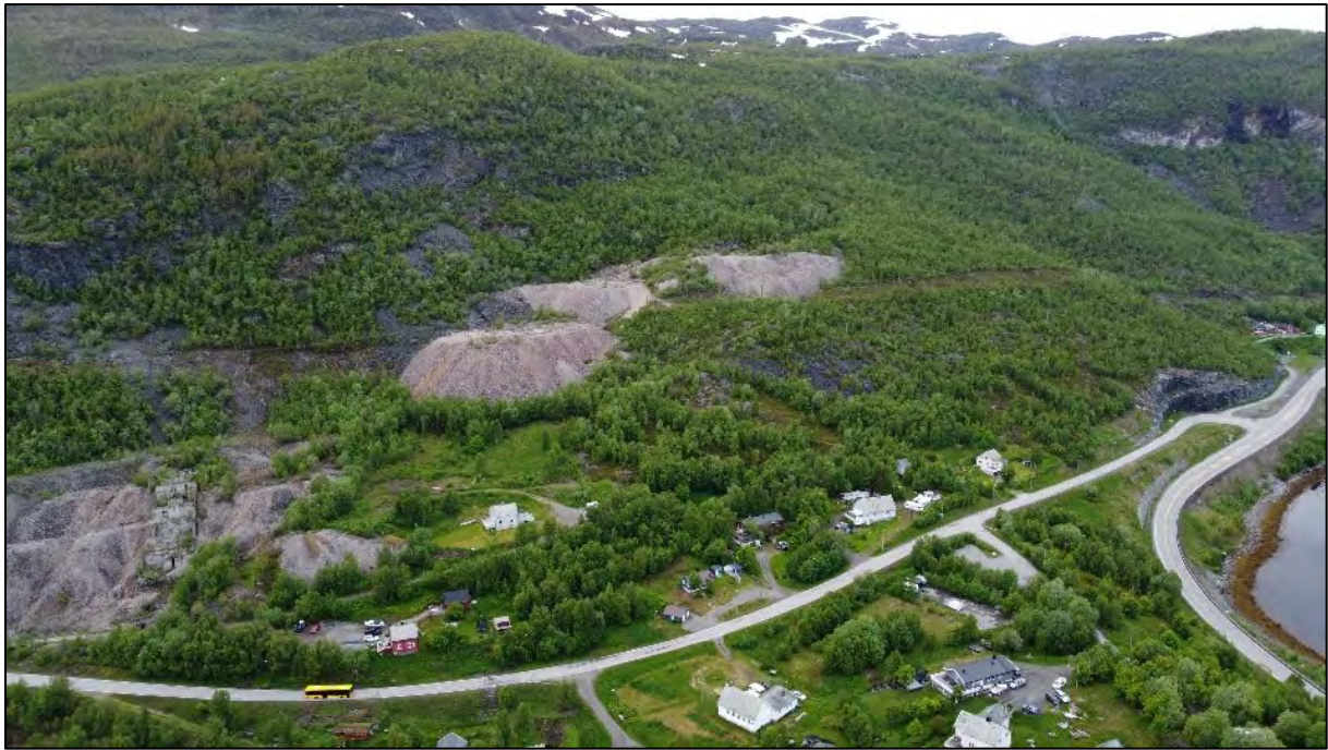
Figur 2: Bildet vider nordlige del av området, hvor det både er uravsetninger nedenfor naturlige bergskrenter og fyllmasser.
