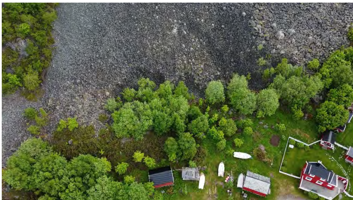
Figur 4: Steinsprangavsetninger i vest, div. naust og småbygg i tilknytning til Russluftveien 390 kan ses i bildet
