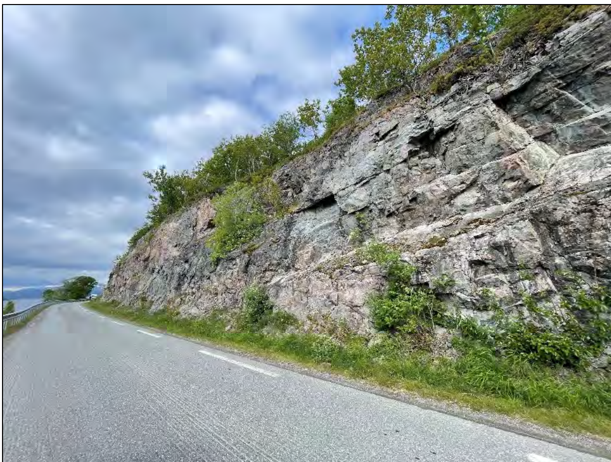
Figur 23: Vegskjæring, sett mot vest.
