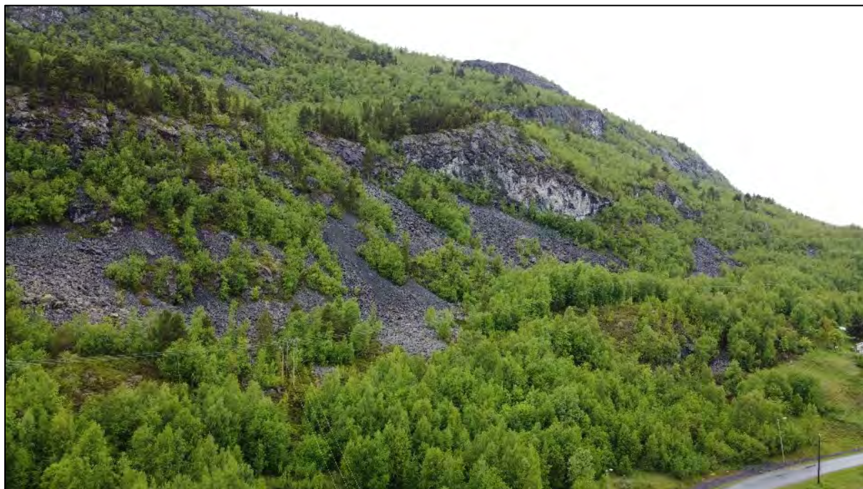
Figur 2: Bildet viser nordlige del av området, hvor det er løsneområder for steinsprang og steinsprangur. Bildet er tatt mot nordvest.
