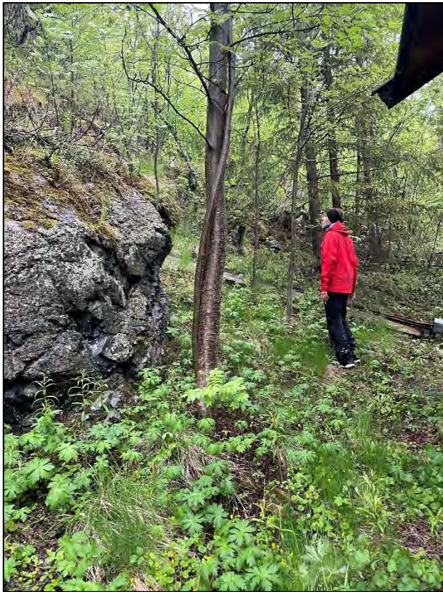
Figur 16: Bildet viser bergskrenten bak Kåfjordvegen 2. Berget fremstår massivt, og vi vurderer årlig løsesannsynlighet som mindre enn 1/1000, men større enn 1/5000.
