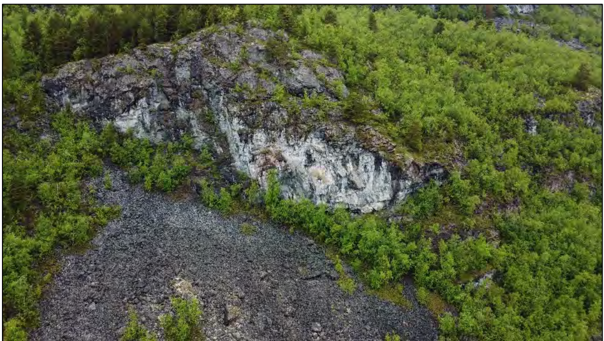
Figur 4: Bildet viser løsneområder for steinsprang i nordlige del av området.
