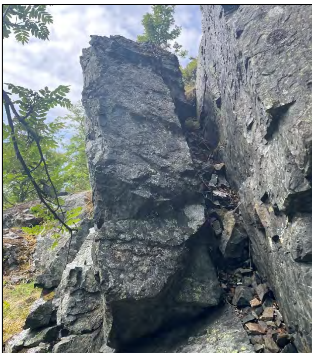
Figur 22: Avløst blokk i skråningen bak Basnjarga nr. 25. Baksprekk tilhører sprekkesett som heller bratt mot NV
