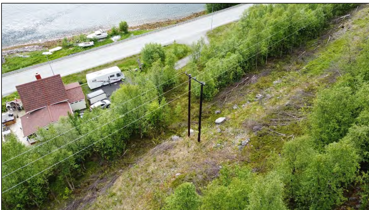
Figur 6: Kantrunda blokker mellom ur og kraftlinja.
