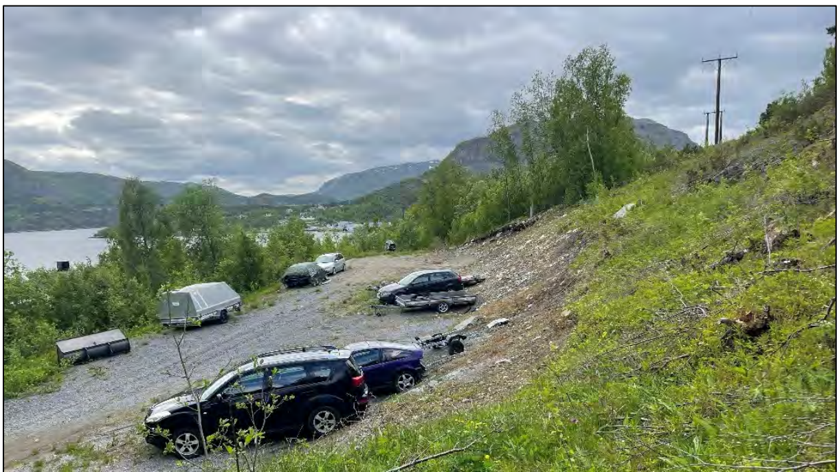
Figur 10: Bildet viser en løsmasseskjæring sentralt i kartleggingsområdet, hvor løsmassene består av morenemateriale. Bildet er tatt mot sør.
