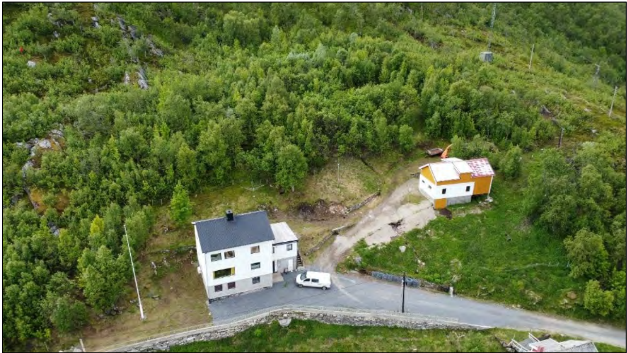
Figur 3: Nordlige del. Rakaluftvegen 41 og 43.
