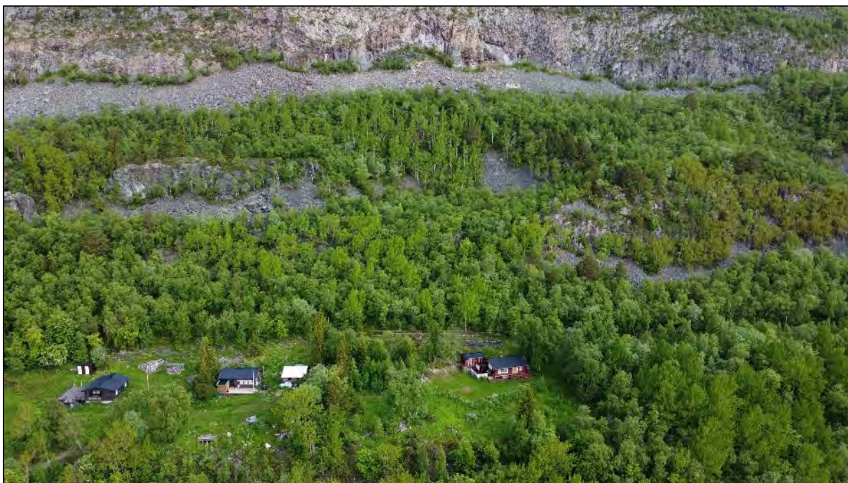
Figur 18: Russluftveien 306, 308 og 310. Steinsprangavsetninger i fjellsiden og noe blokk med usikkert opphav rundt hyttene.
