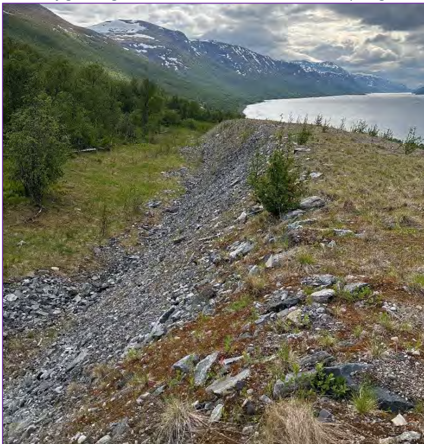
Figur 4: Voll ved tunnelåpning til E6. Bildet ser mot sørvest. Vollens høyde er 6 m ifølge Vegkart (Statens vegvesen, 2024), og den strekker seg 320 m fra nordøst til sørvest. Det ble ikke observert skredavsetninger på støtsiden av vollen på befaringstidspunktet.
