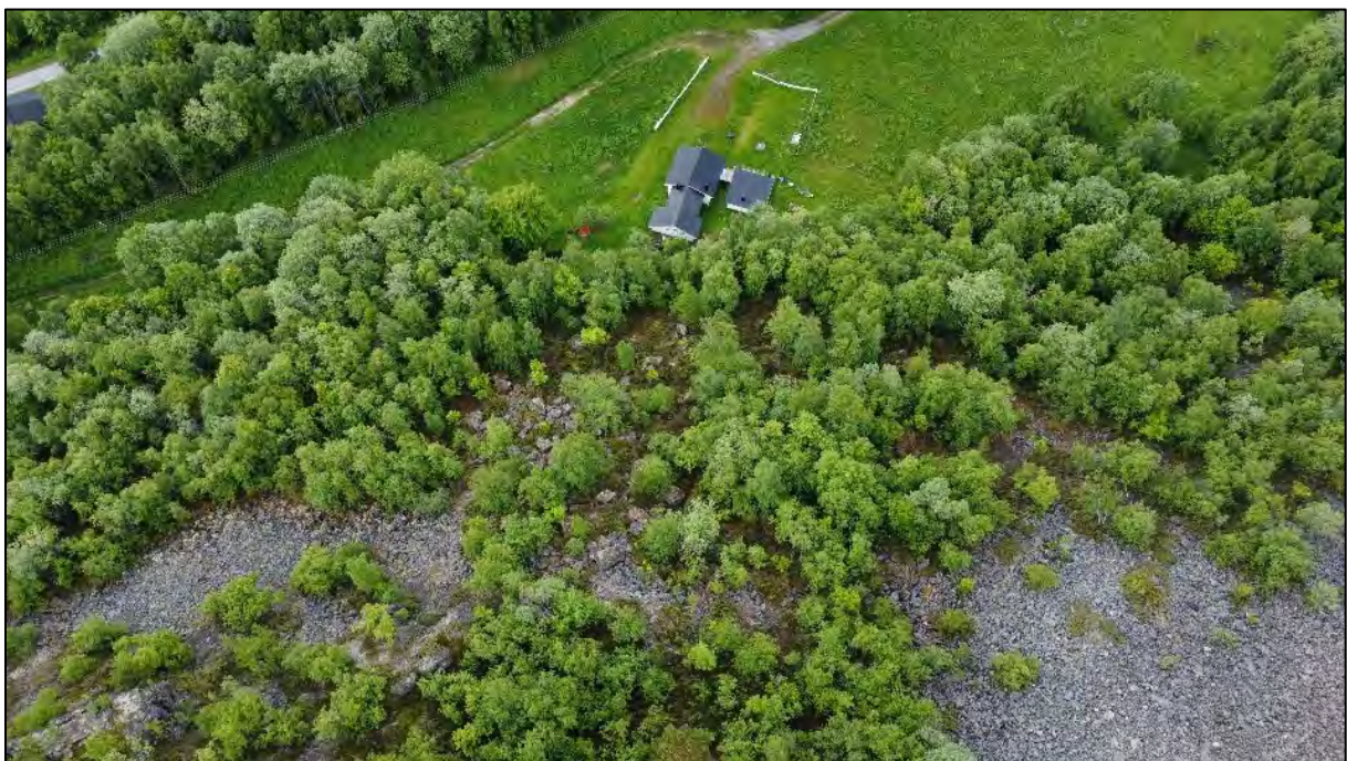
Figur 10: Bildet viser steinsprangavsetninger mot Russluftveien 380
