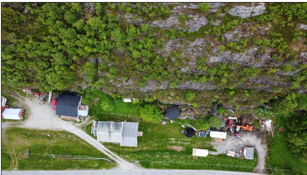
Figur 8: Skråning bak Kvibyveien 96 med blokker i nedkant
