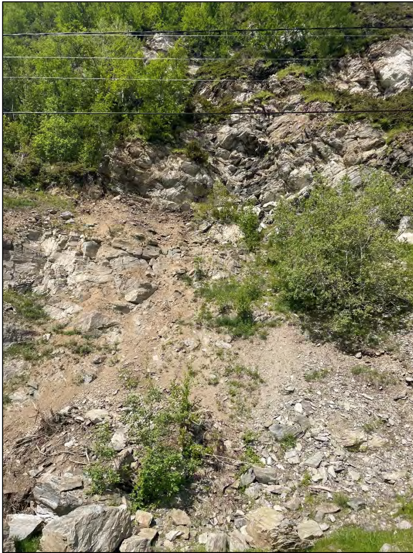
Figur 7: Bergskjæringen over Lerresfjordveien, i vestlige del av området.
