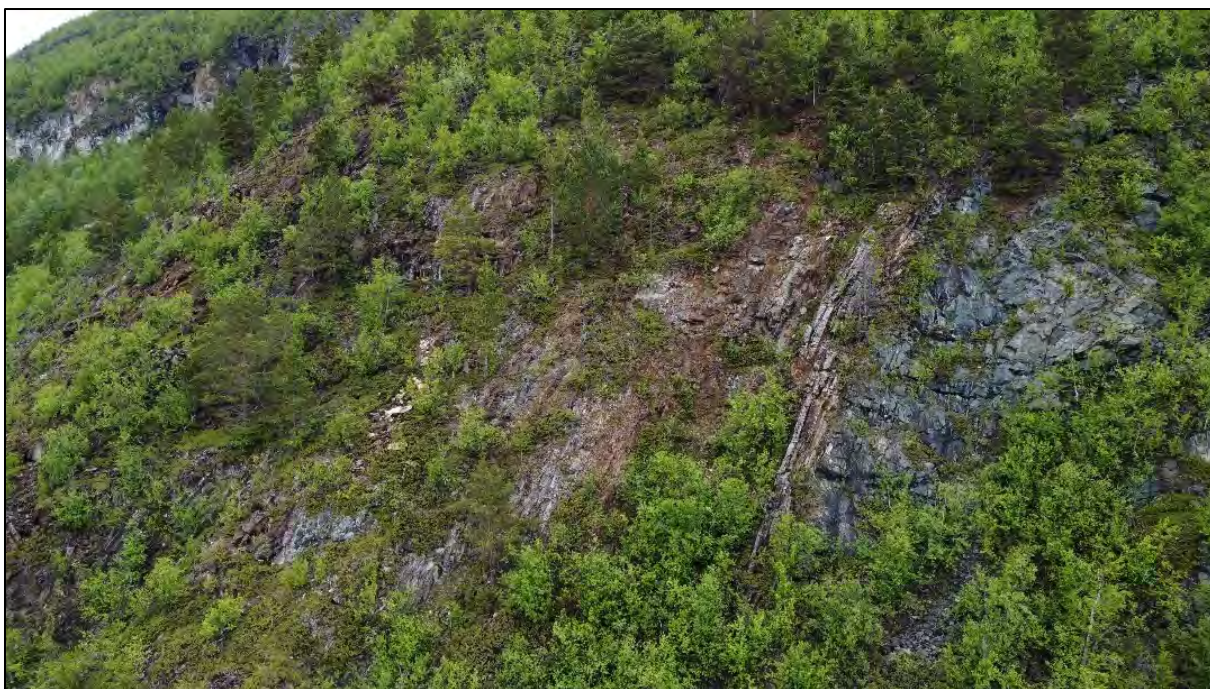
Figur 3: Bildet viser løsneområder for steinsprang i ryggformasjonen nord i påvirkningsområdet.
