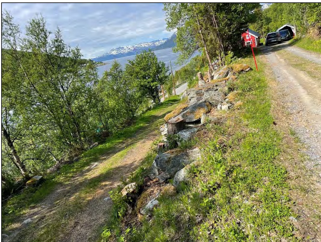
Figur 18: Lerrefjordvegen til høyre i bildet. Ura ligger til høyre for bildet, og vegen er trolig bygget inn i ura/delvis med ur som fyllmasser.
