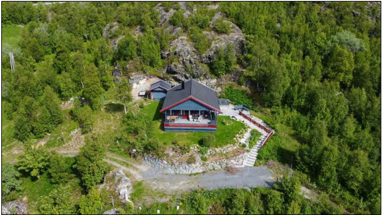
Figur 8: Basnjarga nr. 9, og skråning i bakkant
