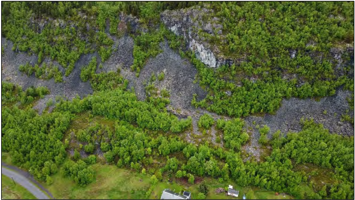
Figur 3: Bildet viser nordlige del av området, hvor det er løsneområder for steinsprang og steinsprangur. Ura har utbredelse omtrent til kraftlinja. Bildet er tatt mot sørvest.
