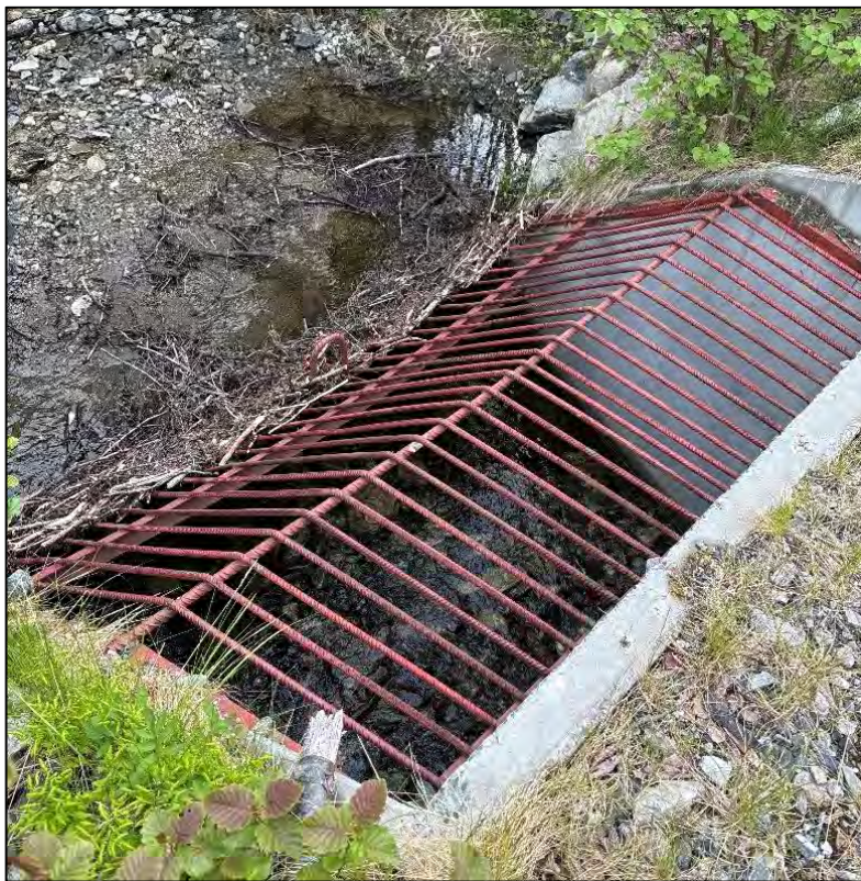
Figur 8: Bildet viser kulvert på oppside av E6. For bekk nordøst for Storelva.
