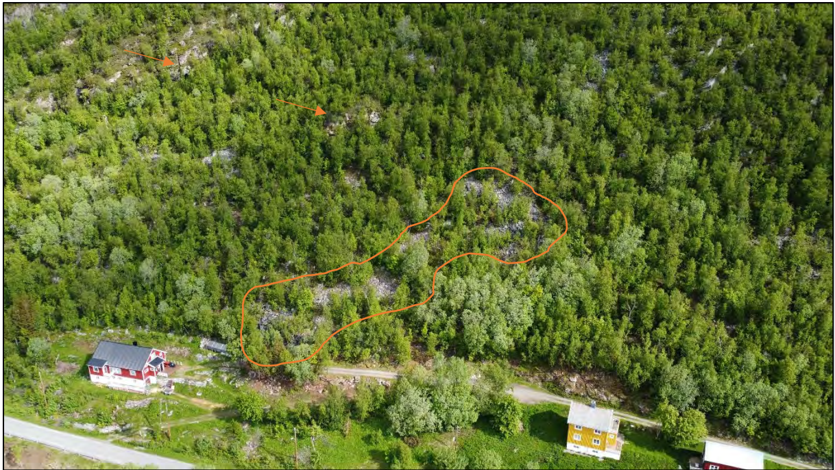
Figur 14: Lerrefjordveien 182 (gult til høyre) og 186 (rødt til venstre) og overliggende fjellside, med ur mellom de to husene. Pilene peker på skrenter med høy løsningsannsynlighet (vurdert som større enn 1/100 ut fra tilstanden til skrentene, Figur 13 og Figur 15). Oransje omriss viser ur, som vi er usikre på om er steinsprangur eller forvittringsur. Hele eller deler av denne ura er fredet ifølge lokale. På bildet er det også synlig flere enkeltblokker i terrenget, og mellom husene.
