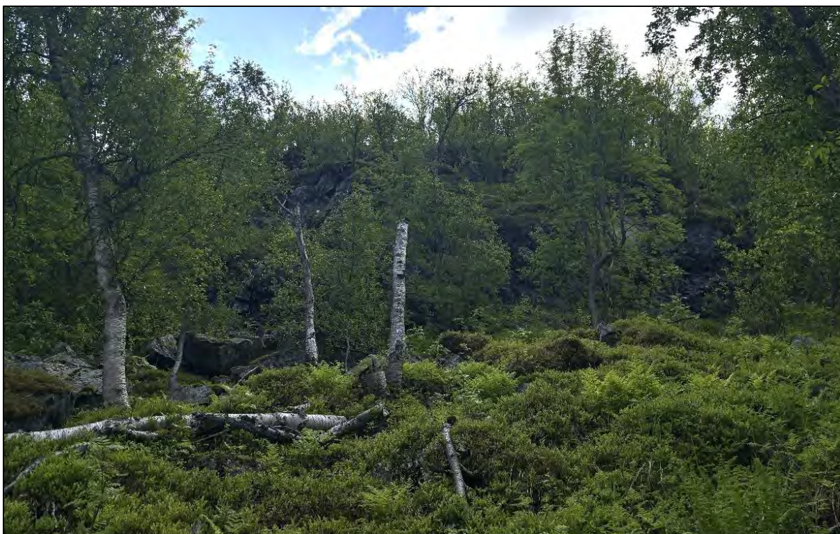
Figur 19: Bak avkjørsel fra Langfjordveien (E6) til Storsandnes og bak Storsandnes 96 observeres det skrenter med opptil 20 m egenhøyde. Under skrentene ligger det stedvis blokkavsetninger, både forvittringsmateriale og steinsprang. Skrentene ligger ca. 100 moh. Blokkavsetning er i god avstand til kartleggingsområdet, ca. 180 lengdemeter.
