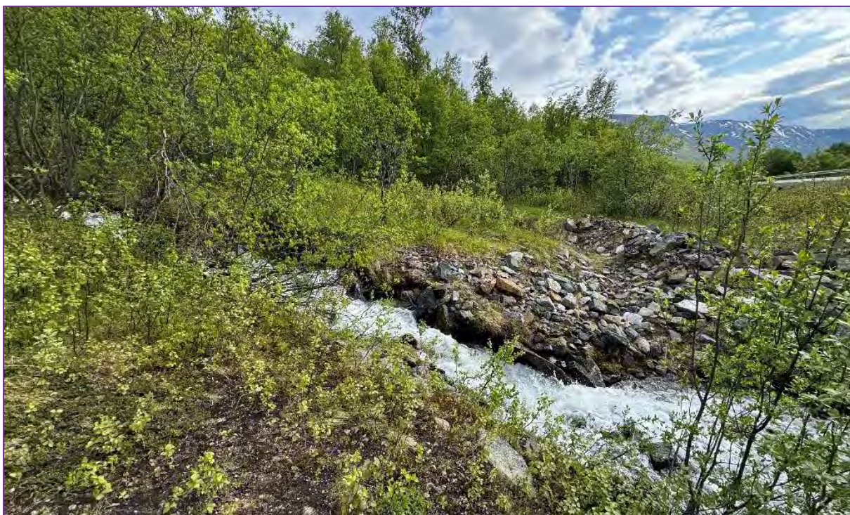
Figur 13: Bildet tatt ved utløpet av Storelva, rett på oppsiden av E6. E6 ses til høyre i bildet. Det ligger større mengder med avsatte løsmasser i dette området.
