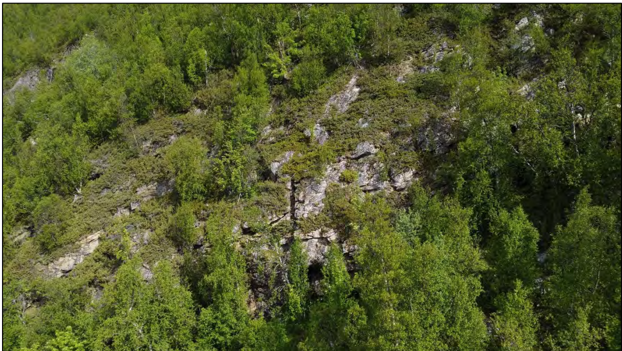
Figur 15: Skrenter i nordvestlige del med løsningsannsynlighet større enn 1/100
