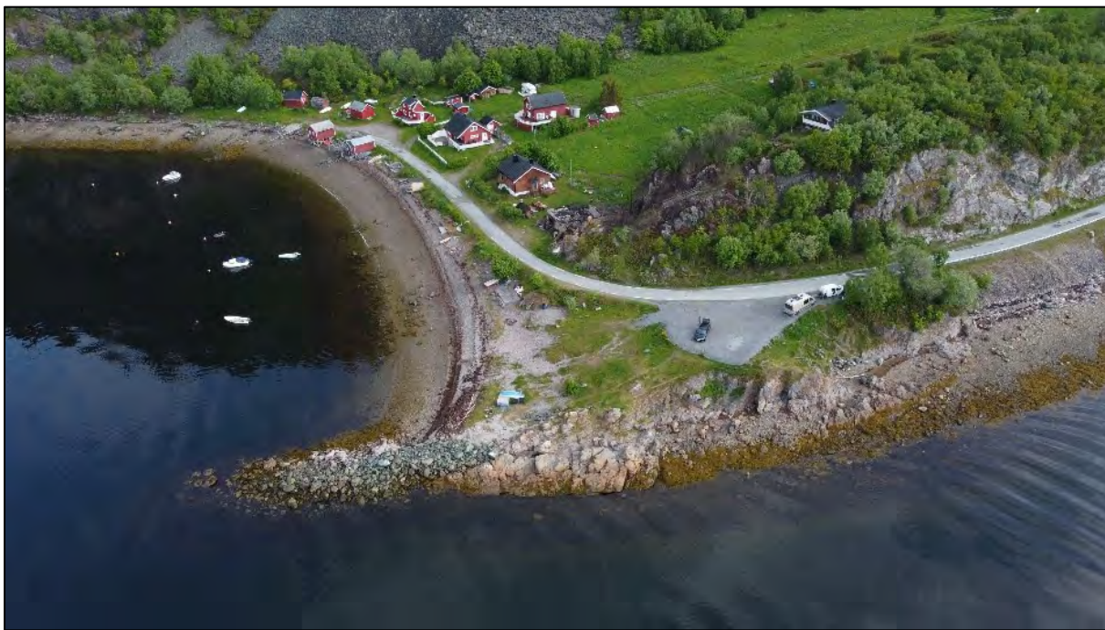
Figur 2: Russeluftneset. Veiskjæring til høyre (øst) i bildet.
