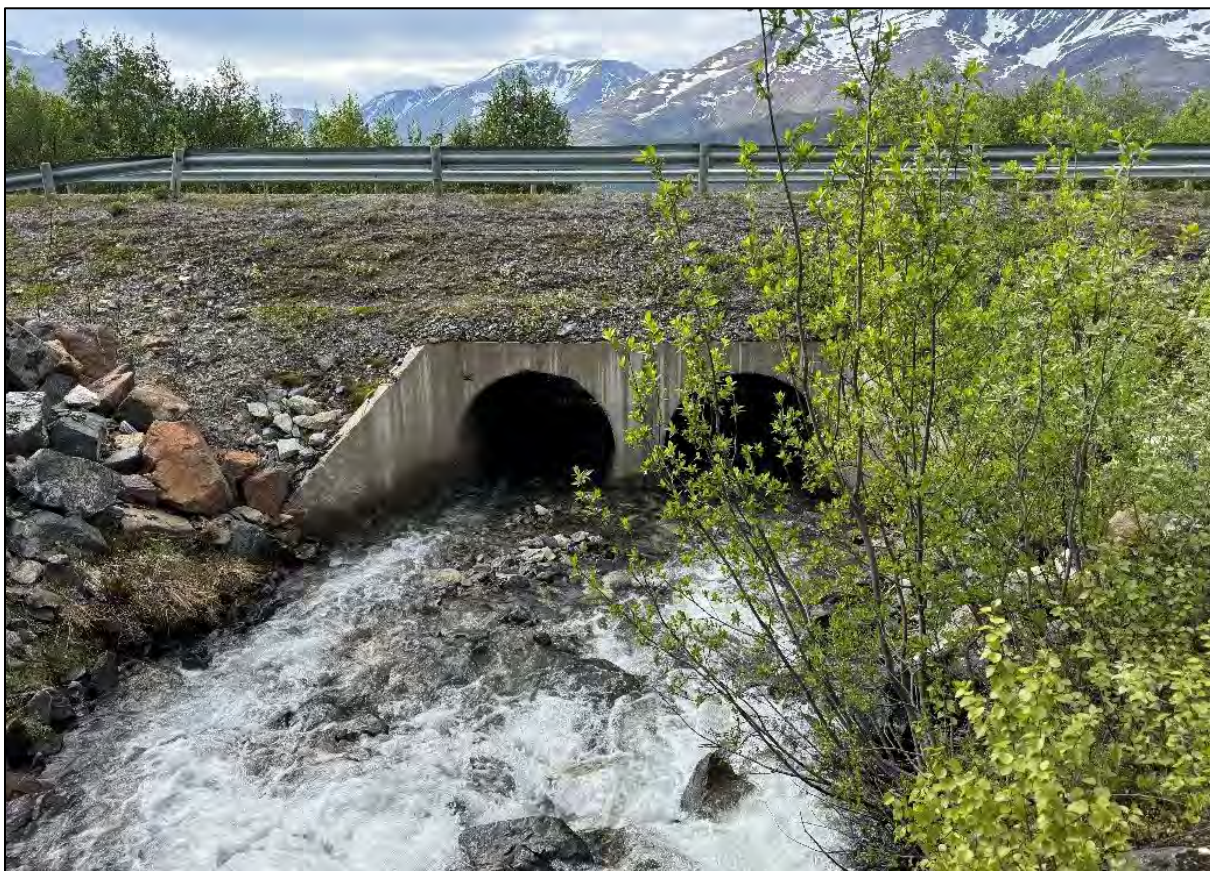
Figur 14: Kulvert ved E6 for Storelva sett mot vest. De to lysåpningene er ca. 1,5 m i diameter.
