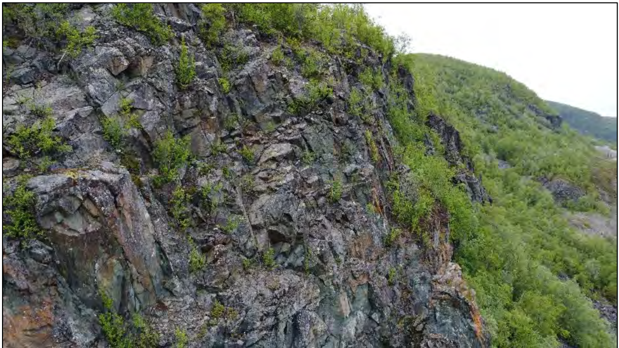
Figur 5: Løsneområder i for steinsprang i nordlige del, sett mot nord
