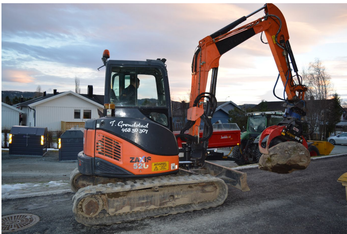
Figur 5. Steinen flyttes varsomt med gravemaskin. Da63641_013. Foto: Lene Vestrum Kirkhus, NTNU Vitenskapsmuseet
