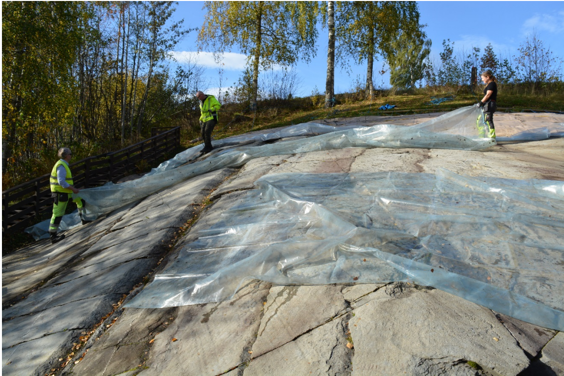
Figur 40 Dampsperre legges før etanolbehandling. Sett mot NV. Da63631_033. Foto: Lene Vestrum Kirkhus, NTNU Vitenskapsmuseet
