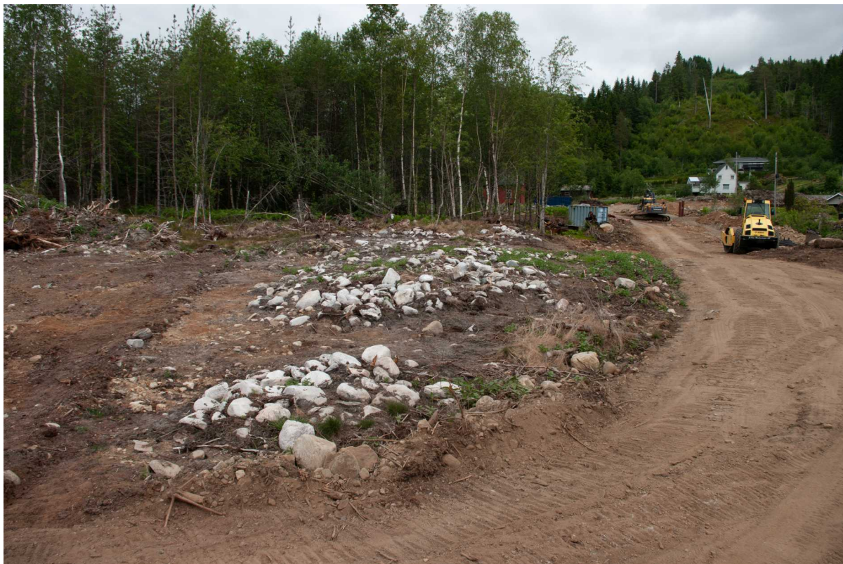
Figur 10. Oversiktsbilde tatt ved oppstart. Id. 205 i forgrunnen. Tatt mot NØ. Da62780_005. Foto: Eivind M. F. Krag, NTNU Vitenskapsmuseet
