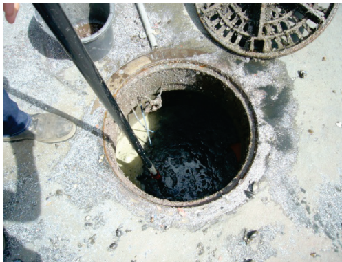
Figur 4.6 Prøvetaking av sandfangskum på spyleplass
