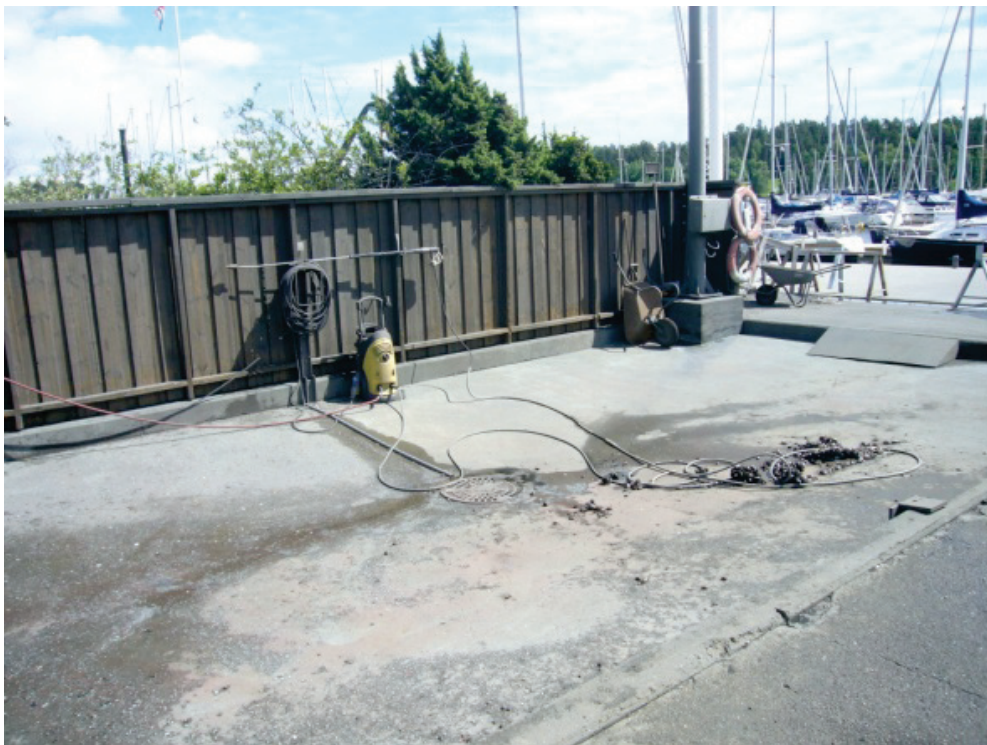
Figur 1 Spyleplass med tett dekke med sandfangskum som samler opp faststoff fra høytrykksspyling av båtskrog. Foto fra Blommenholm båtforening.
