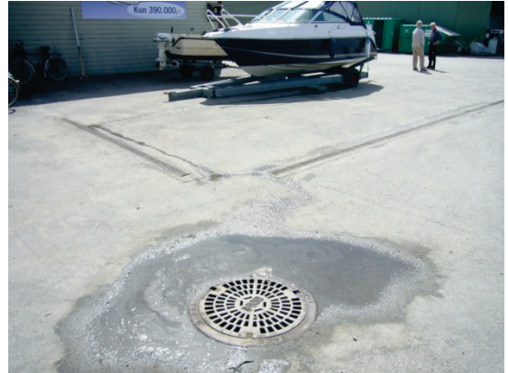
Figur 13.2 Spyleplass med sandfangskum
