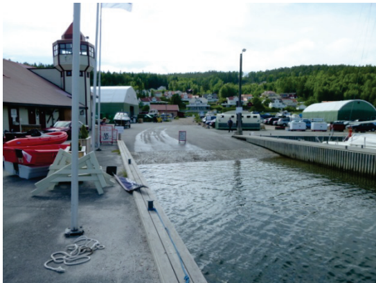
Figur 13.3 Slipp for utsetting av båter
