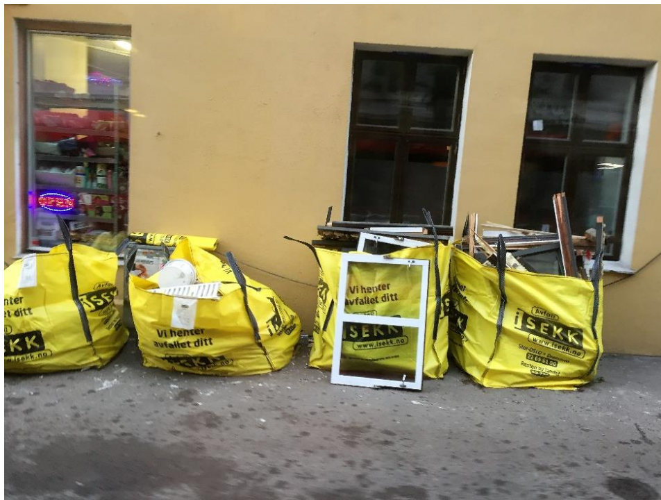
Bilde 9 viser sekkeløsning med usortert byggavfall. Foto Nomiko AS
