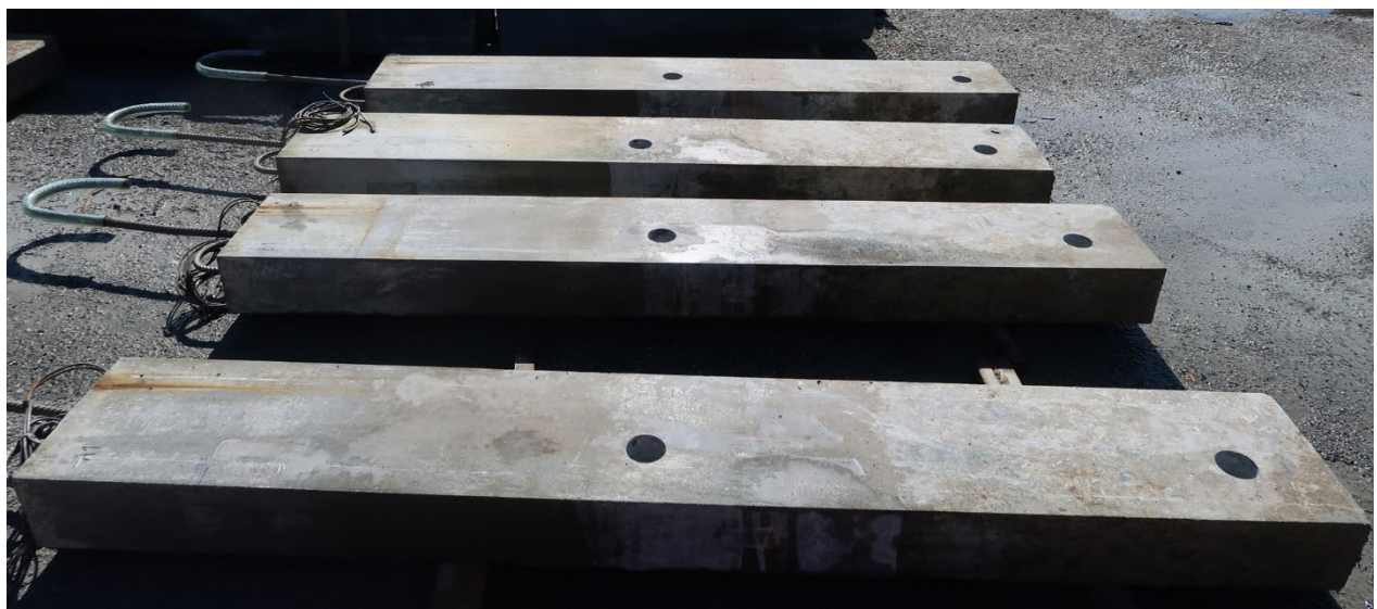
FIGUR 13 ELEMENT A1(NÆRMEST), B1, C1 OG D1 ETTER UTBORING AV KJERNER. FOTO: EVA RODUM, STATENS VEGVESEN
