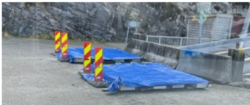
FIGUR 18 ELEMENTENE TILDEKKET MED PRESENNINGER ETTER UTFØRT REPARASJON AV BORHULL. FOTO: BMO.
