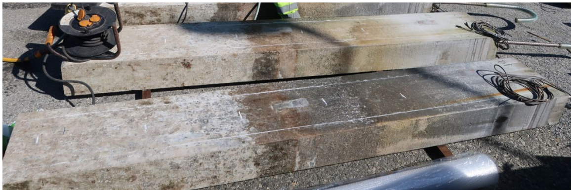
FIGUR 7 LOKALITET AV LENGDE- OG BØYLEARMERING BLE TEGNET PÅ OVERFLATENE MED KRITT. FOTO: EVA RODUM, STATENS VEGVESEN
