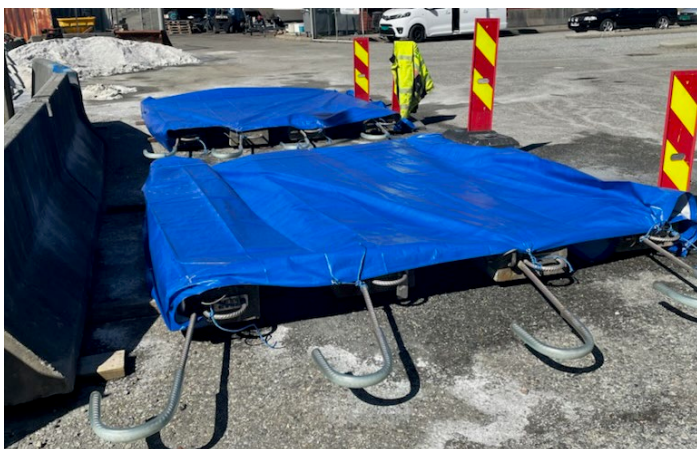
FIGUR 16 ETTER UTBORING AV KJERNER OG RENGJØRING AV OVERFLATER BLE ELEMENTENE TILDEKKET MED PRESENNINGER FRAM TIL REPARASJON AV BORHULL. FOTO: BMO.
