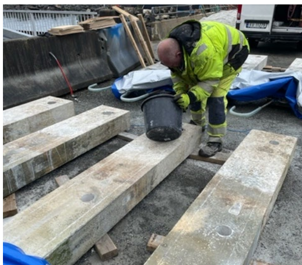
FIGUR 17 REPARASJON AV BORHULL. FOTO: BMO.
