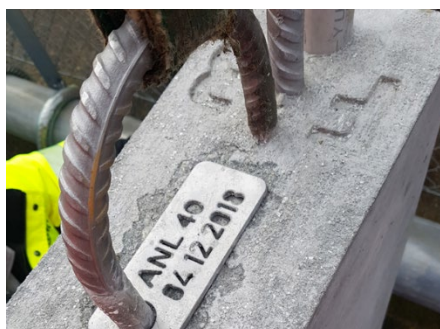
Figur 2 Eksempel på merking. Inntrykk F3 og bindemiddeltype ANL40, støpt 04.12.2018
