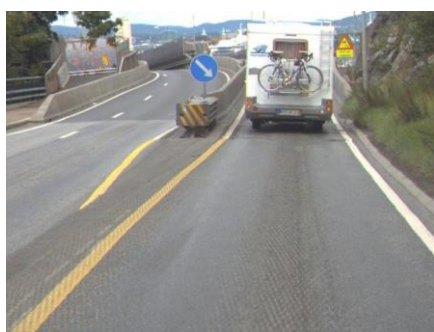
Fig. 24 Oppstart midtrekkverk
