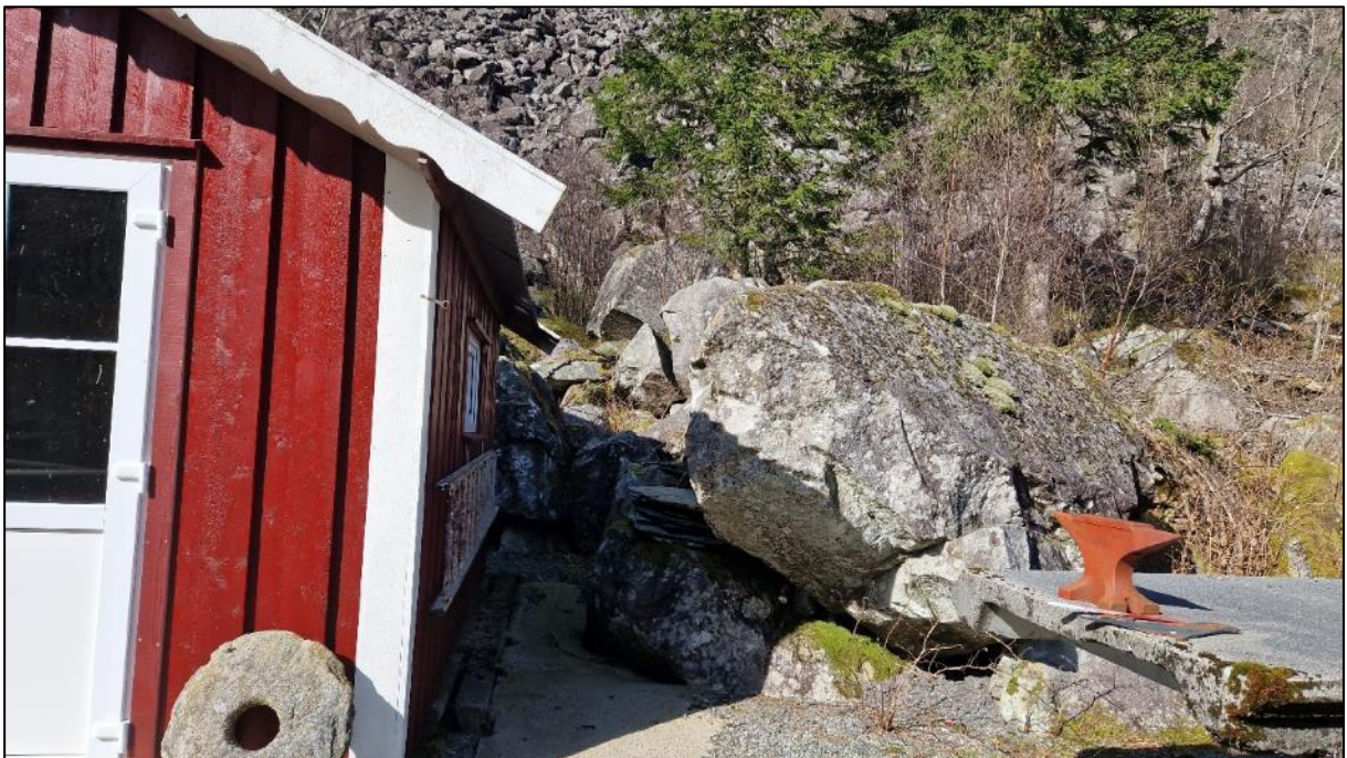
Bilde 12. Steinsprangblokk ved østlig siden av lite hus nord for kartleggingsområdet.
