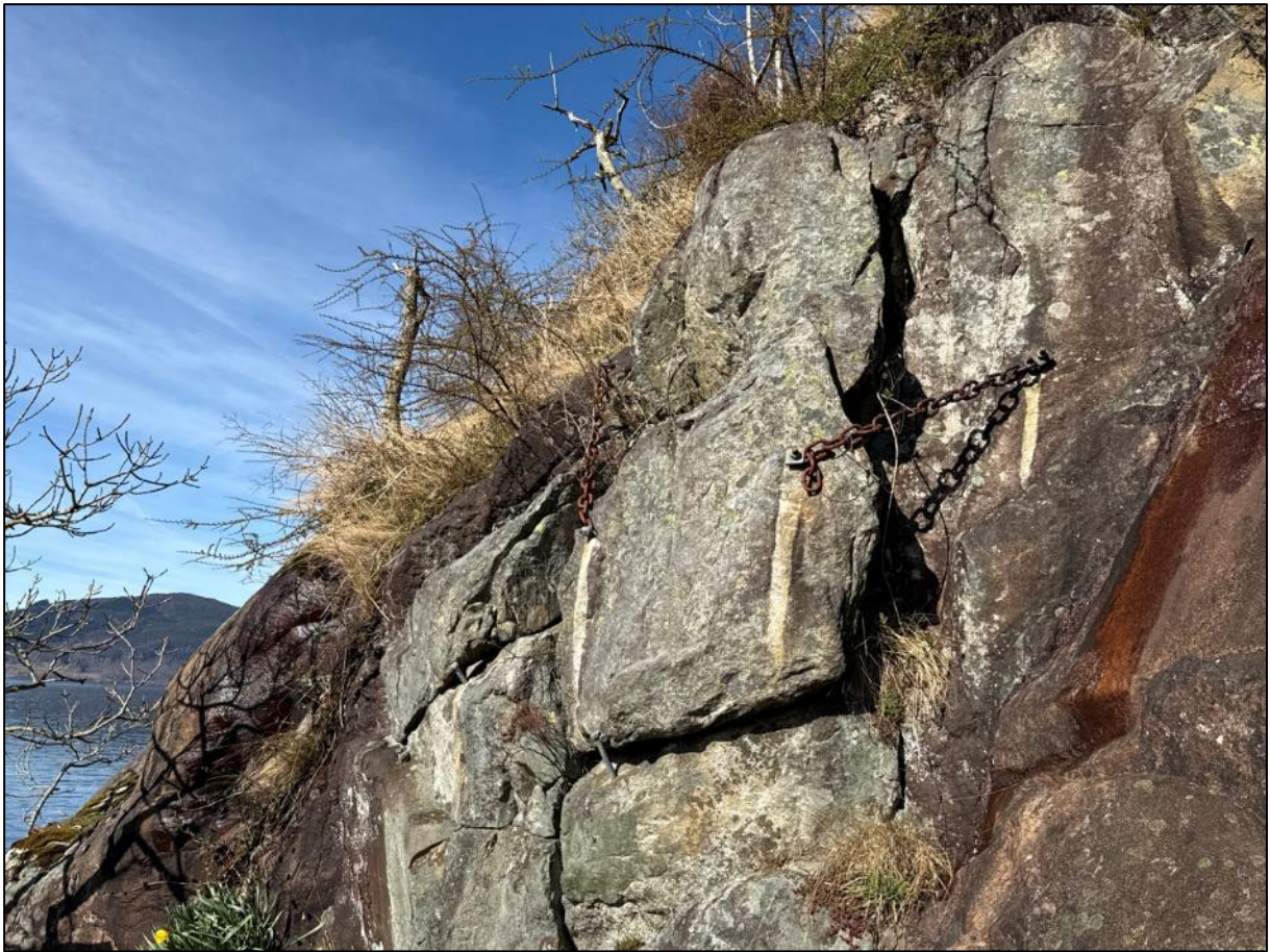
Bilde 32. Hjemmesnekret skringstiltak av blokk ovenfor naust til Nordbygda 77. Plassering angitt av infopunkt 21.
