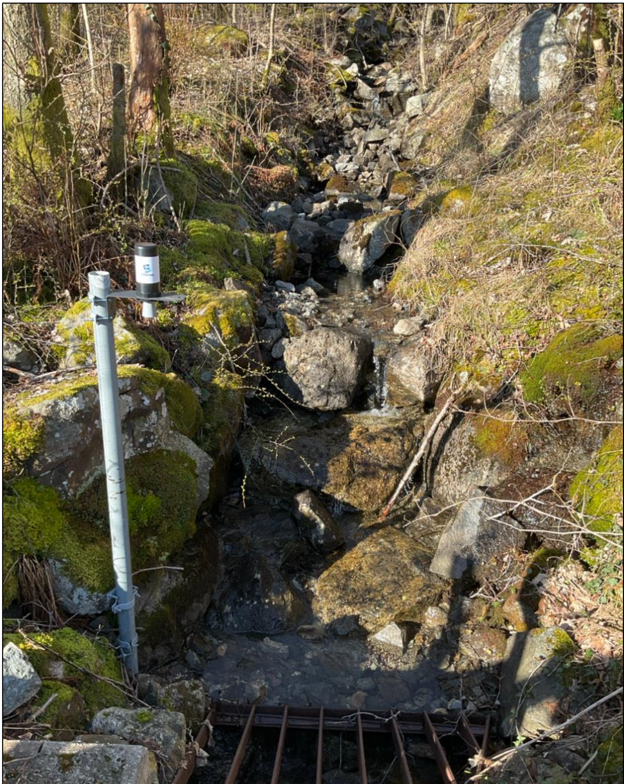
Bilde 8. Bekkeinntak vest for Melslia 84 (infopunkt ). Bekkeløpet er styrt mot øst av mindre kunstig voll og inn i rør gjennom boligområdet. Inntaket er overvåket.
