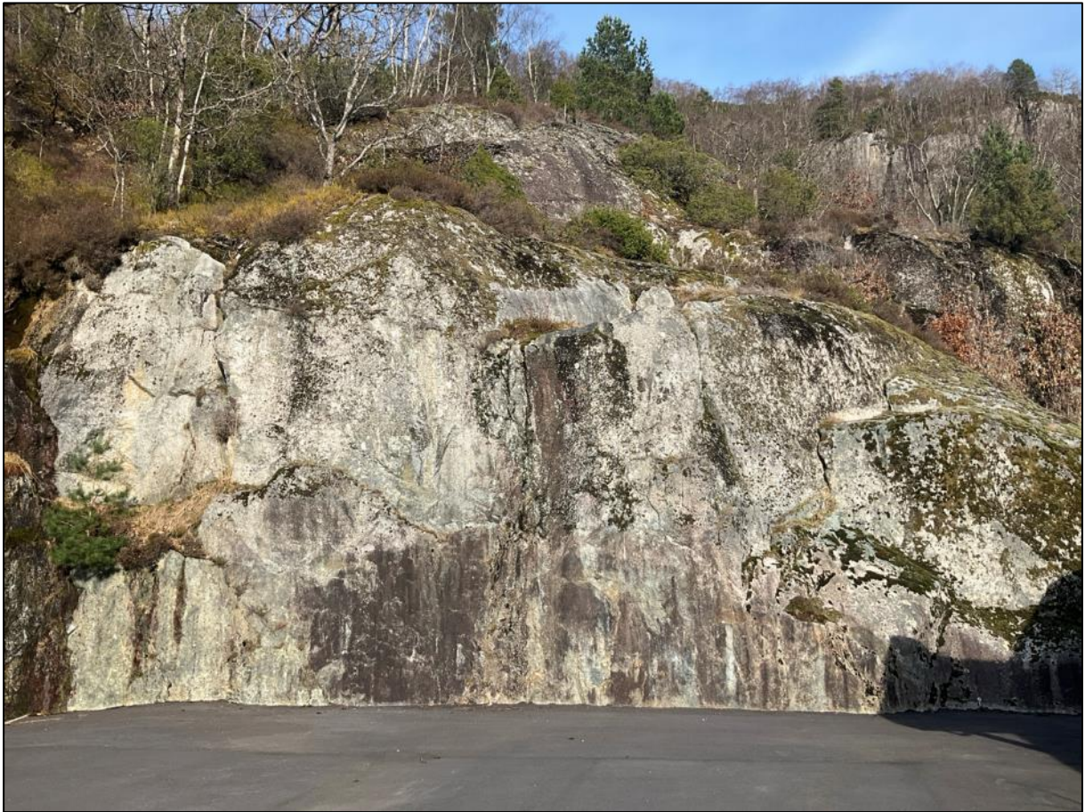
Bilde 41. Slett berg uten løsnepotensiale ved Sæbøvegen 15.
