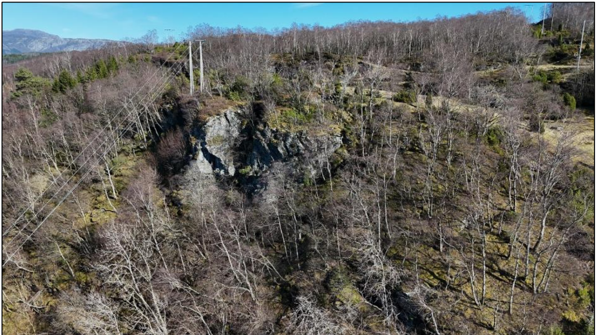
Bilde 12. Bergskrent sør for Ryfylkevegen. Bildet er tatt mot sør.
