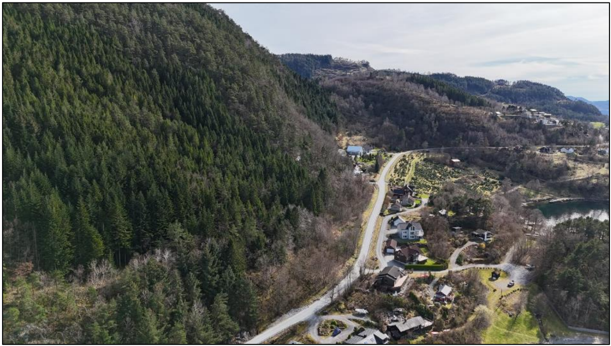
Bilde 3. Dronebilde over vestlig del av påvirkningsområdet. Bildet er tatt mot sør.
