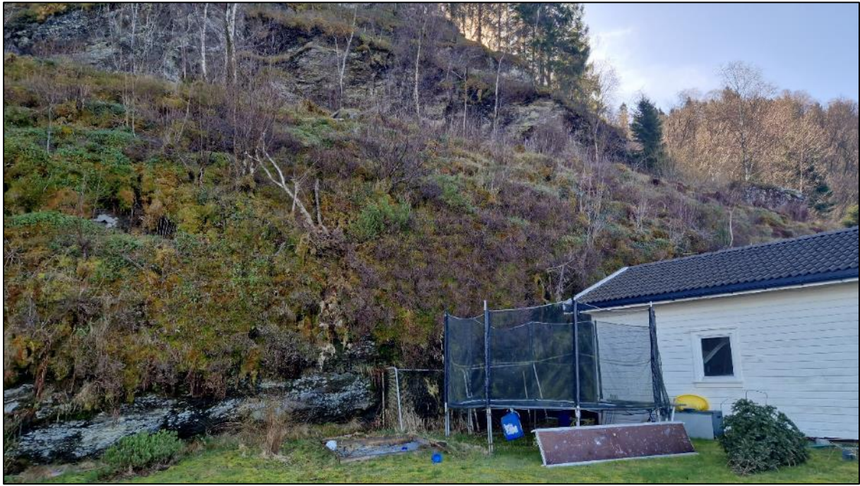
Bilde 22. Bergskrent bak huset på Hundsnesvegen 112. Bildet er tatt mot sør.
