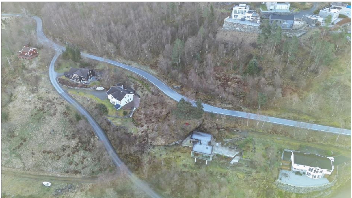
Bilde 10. Oversiktsbilde på Båthamnvegen 2 og 4. Bildet er tatt mot sør.
