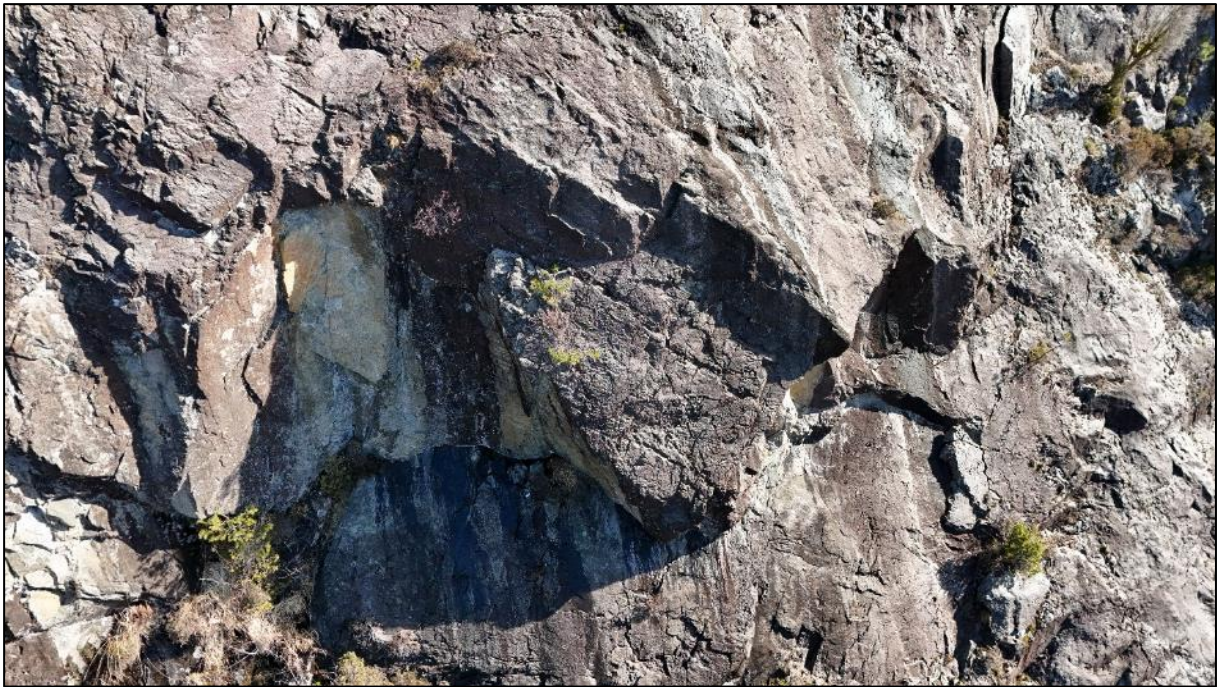
Bilde 17. Område hvor lokal informant sa det tidligere hadde løsnet steinsprangblokker.
