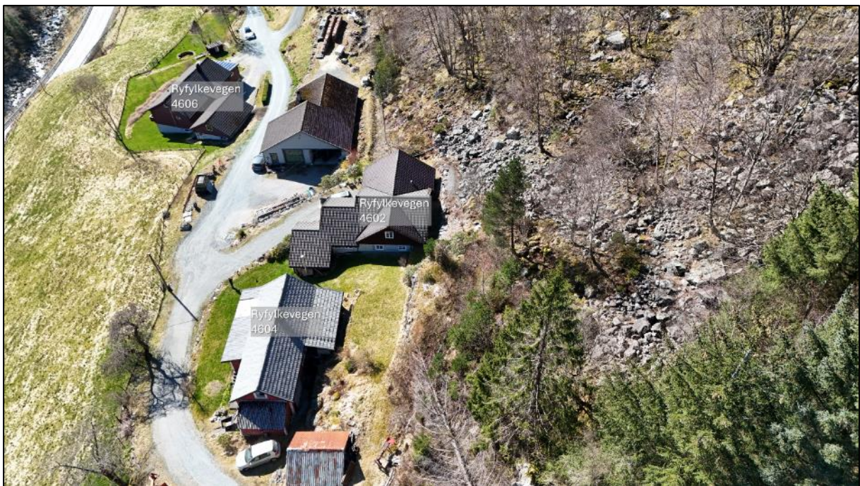
Bilde 4. Dronebildet over Ryfylkevegen 4602, 4604 og 4606 og nedre del av påvirkningsområdet med mye moreneblokker / ur.
