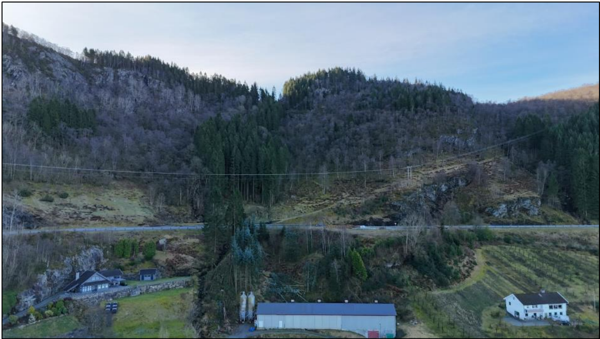
Bilde 17. Oversikt av bekken og jordskred avsetning fra hendelse i 1871 (midtre del av bilde). Ryfylkevegen krysser over skredmasser. Bildet er tatt mot sørøst.
