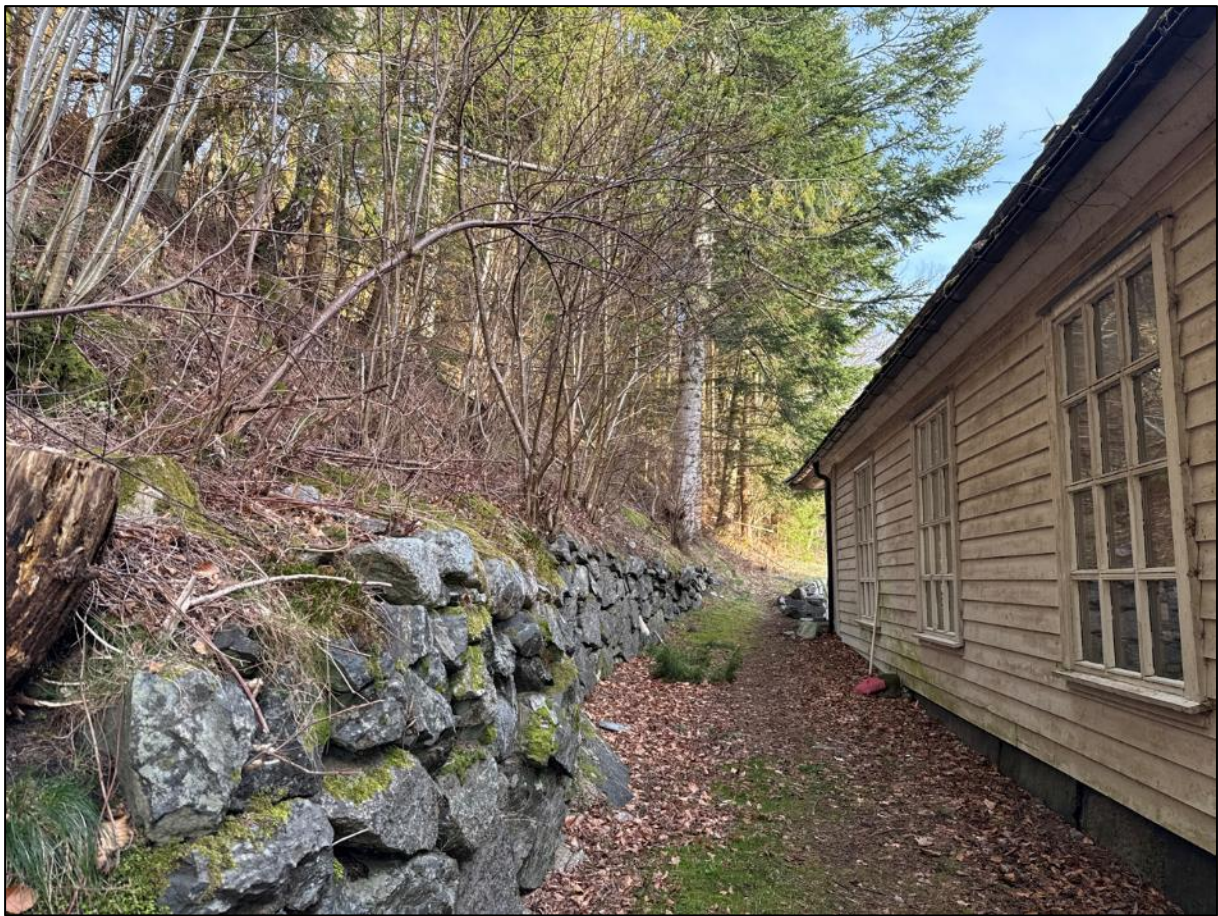
Bilde 55. Tørrsteinsmur i nedre del av skråning bak Spinneriet/forsamlingshus (Burmavegen 11).
