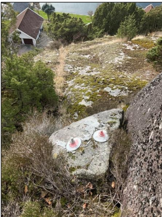
Bilde 29. Boltesikring i terrenget ovenfor Nordbygda 74 og 77. Markert av infopunkt 20.
