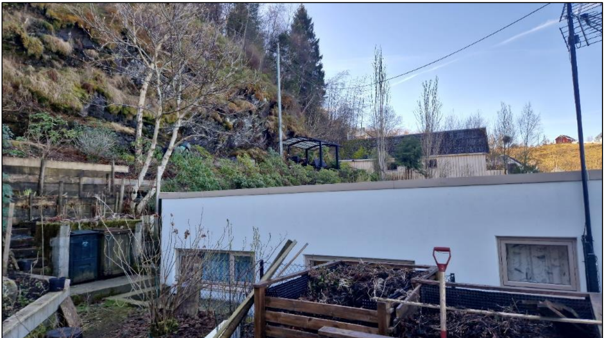
Bilde 21. Bergskrent bak huset på Hundsnesvegen 102. Bildet er tatt mot sør.
