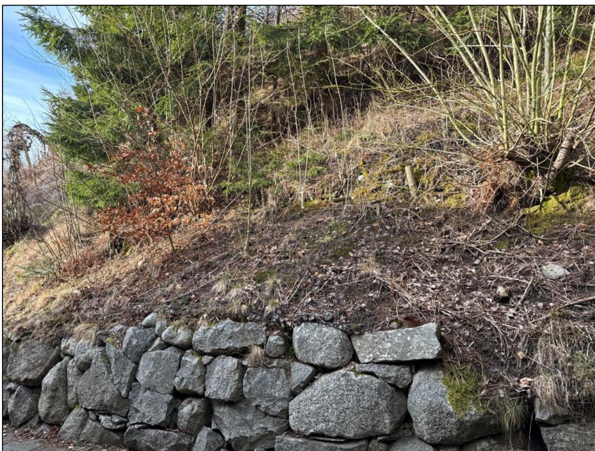
Bilde 54. Geonot bak Burmavegen 11, fra tørrmuren og opp til grantræene. Ca. 4 m bred. Plassering er vist av infopunkt 34.
