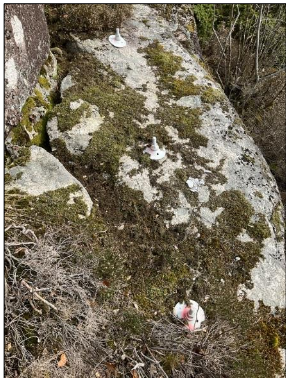
Bilde 29. Boltesikring i terrenget ovenfor Nordbygda 74 og 77. Markert av infopunkt 20.
