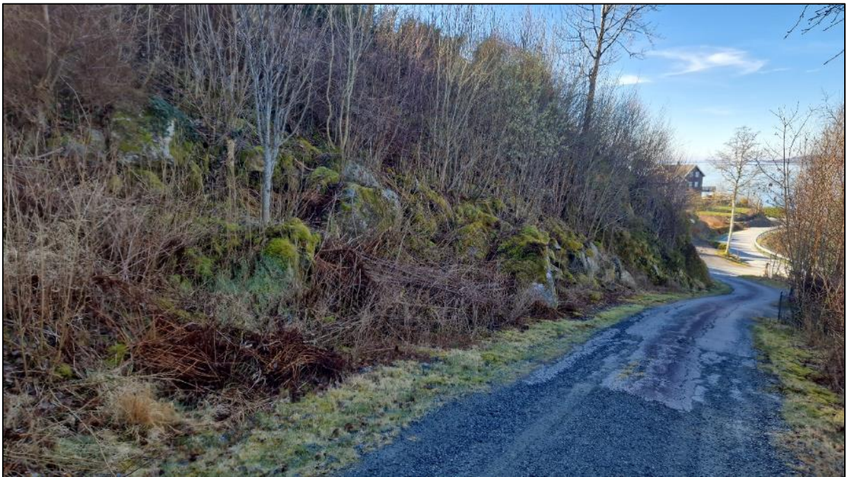
Bilde 22. Flere skarpe blokker på skråning ved østlig siden av adkomst vei til Nesvegen 96.
