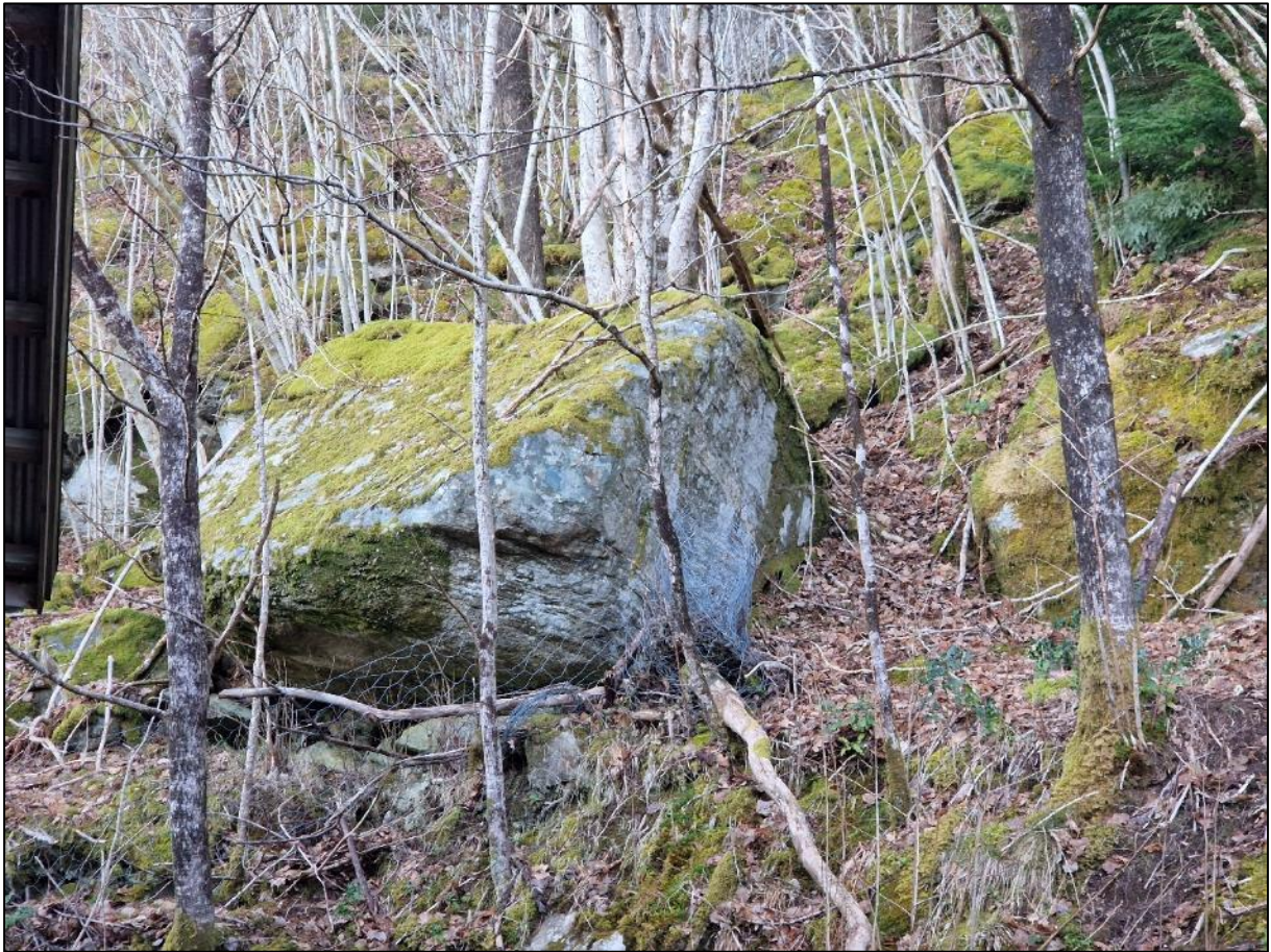
Bilde 15. Gammel steinsprangblokk bak garasje ved Nesvegen 184. Bildet er tatt mot øst.
