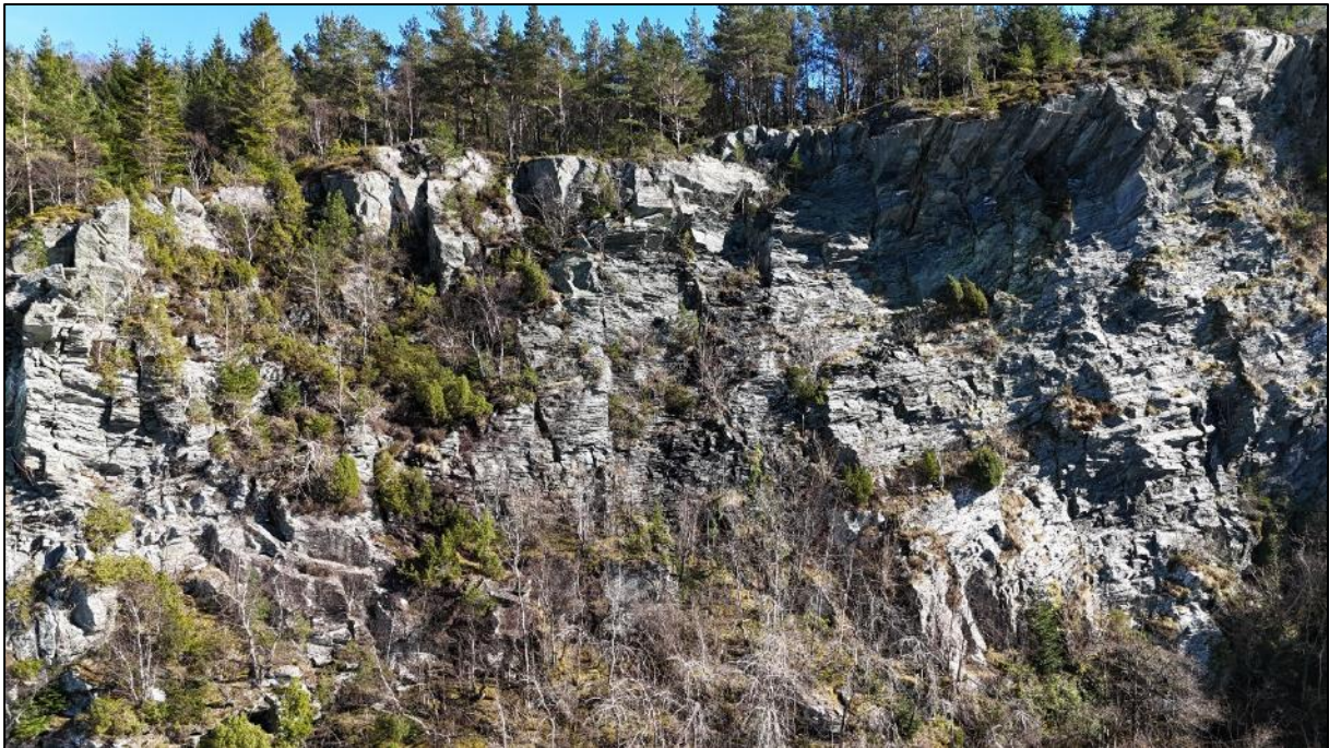
Bilde 8. Oppsprukken bergskrent over urmasser vist i forrige bilde. Bildet er tatt mot øst.
