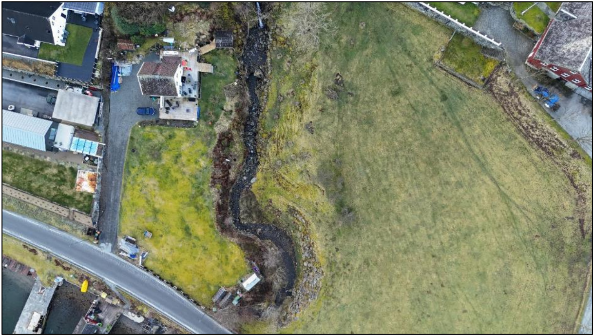
Bilde 15. Dronebilde av erosjonssikrning på bekken sør for Hundsnesvegen 122. Bildet er tatt mot sør.
