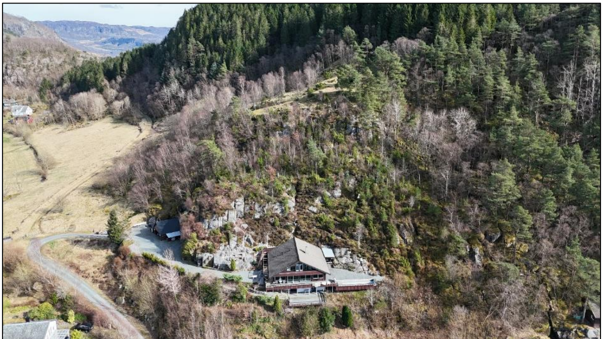
Bilde 4. Fjellsiden over Nesvegen 94. Deler av skråning ble sprengt og boltet iht. etablering av huset og tilhørende adkomst vei. Bildet er tatt mot sørøst.
