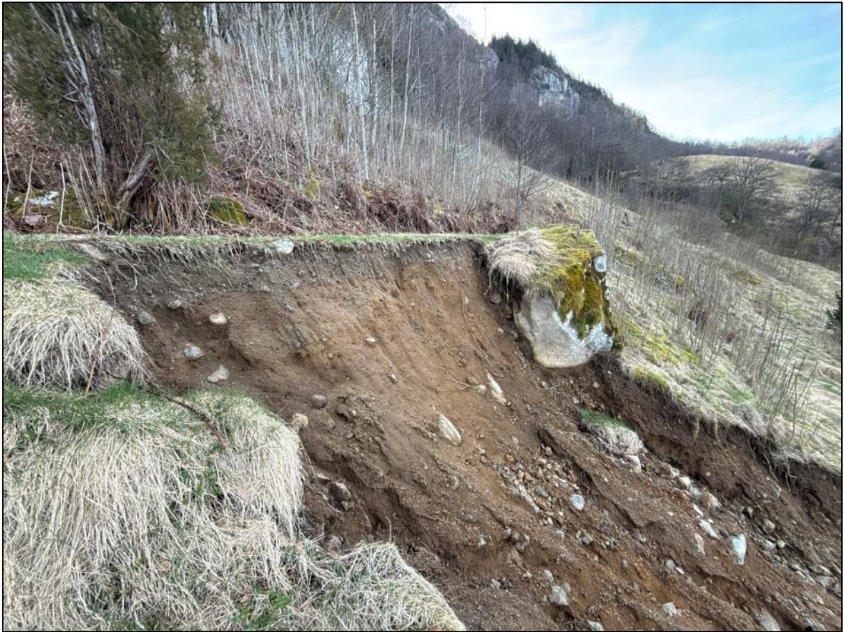
Bilde 15. Utglidning fra vei. Plassering angitt av infopunkt 12.
