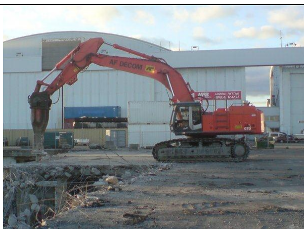
Figur 26. Gravemaskin med hammer
