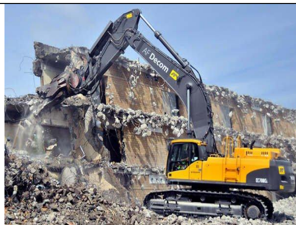
Figur 27. Gravemaskin med betongknuser
