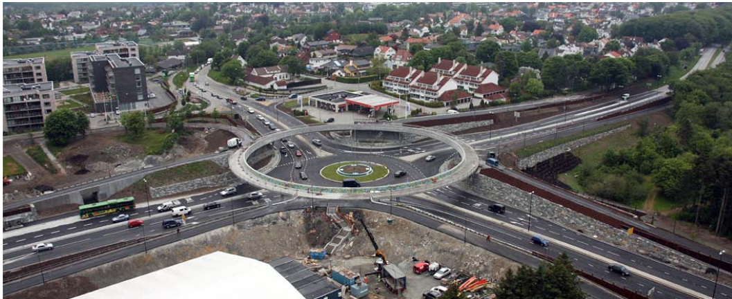
Figur 61. Sykkelrundkjøring i Tjensvollkrysset (Statens vegvesen, 2012a).
