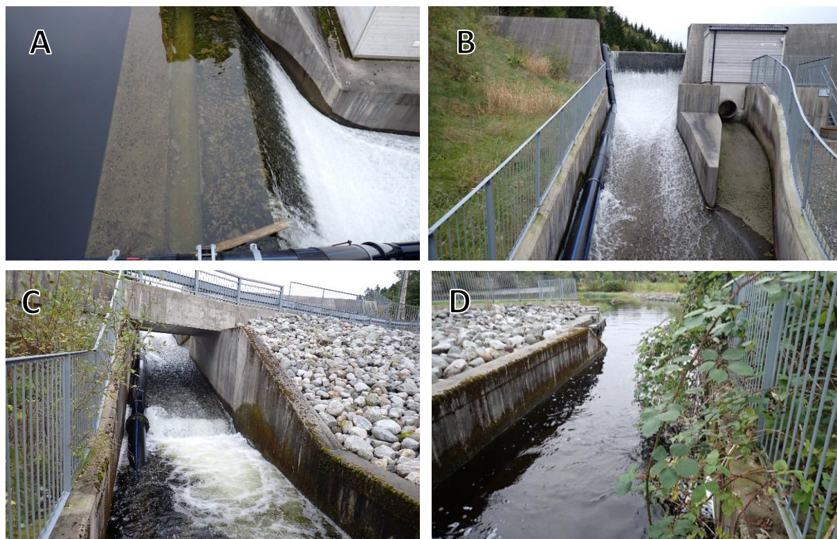
Figur 149. Mølledammen. A) Overløp over dammen. B) Overløpet går videre nedover i en betongrenne, her vises også sideløpet der vannet renner gjennom når vannstanden er under HRV. C) Nedre del av rennen der den går ned i Træsvatnet. D) Ut i Træsvatnet ledes vannet i en kanal med betongvegger.
