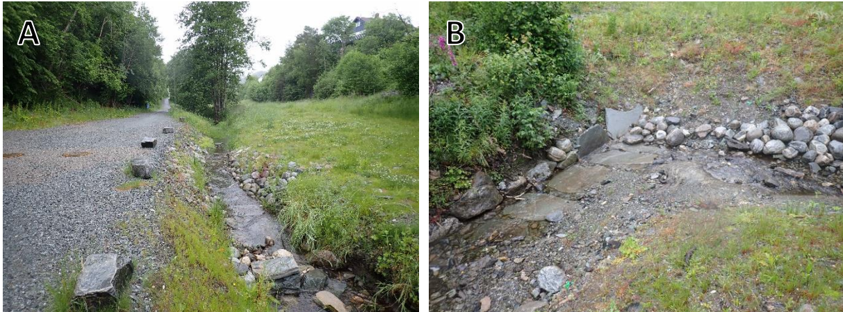
Figur 17. Morfologiske inngrep i Aurebekken: A) Kantvegetasjon mangler langs det meste av elven i nedre halvdel av elven. B) Forbygning og plastring i bunnen i segment 10.
