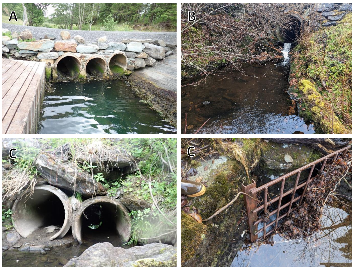
Figur 21. Vandringshindre og bekkelukkinger: A) Rør ved utløp til sjø, kan bare passeres må midtveis tidevann eller høyere. B) Området nedenfor røret under Bjånesvegen. C) Røret under Hatvikvegen mellom segment 14 og 15 er greit å passere på alle vannføringer. D) Oppstrøms innløpet til det lange røret nedenfor Hatvikvegen er det en rist, lysåpningen er stor nok for at sjørret kan passere, men det samler seg mye greiner og løv som gjør oppvandring vanskelig.
