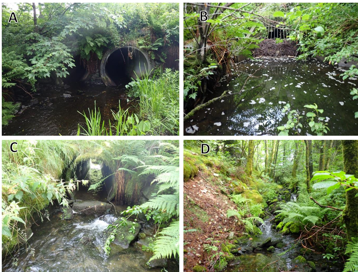
Figur 94. Vandringshindre og bekkelukkinger: A) Rør under Steinsvikvegen er greit å passere for fisk. B) Det er fare for tilstopping i røret som går under Flyplassvegen nedstrøms Skeievatnet. C) Rør mellom segment 42 og 43. D) Temporært vandringshinder i segment 60.
