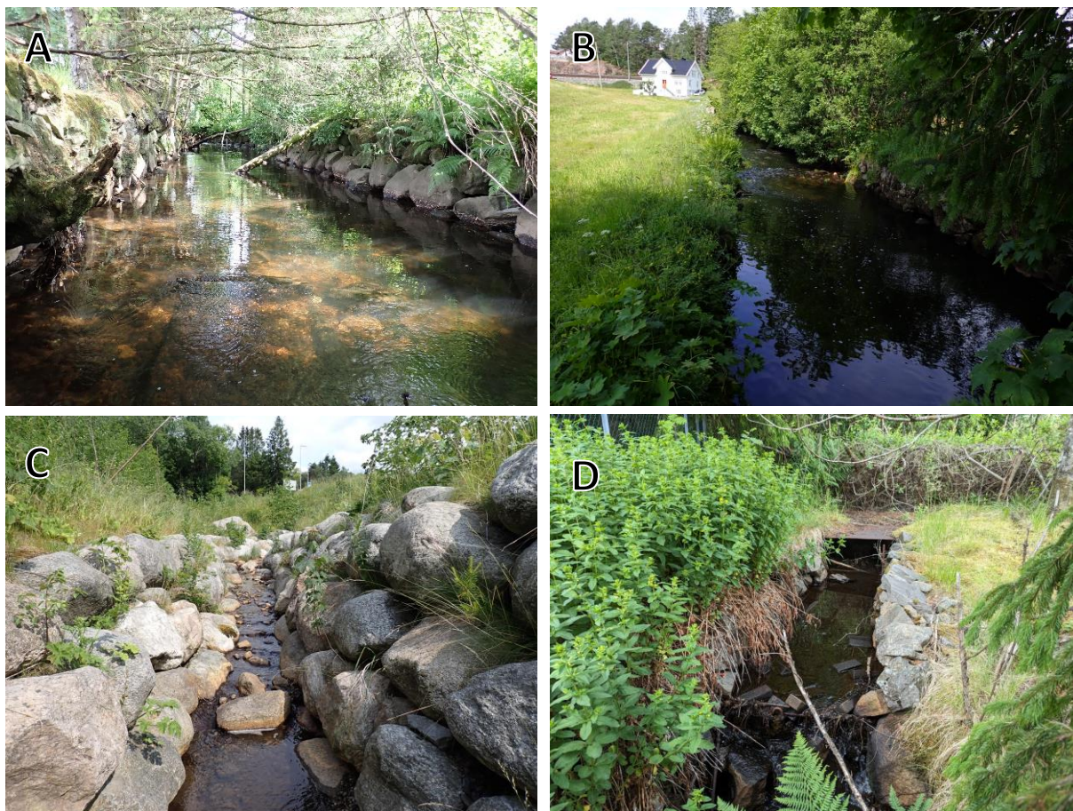
Figur 109. Morfologiske inngrep i Sælenvassdraget: A) Kanalisert og forbygd elveløp i segment 3. B) Forbygd elveløp med manglende kantvegetasjon på den ene siden i segment 10. C) Nylig gjenåpnet strekning i segment 25, strekningen er forbygd, men det er brukt grove stein med mye hulrom som er positivt. Elveløpet er imidlertid svært smalt og gir lite vanddekt areal ved lave vannføringer, foreløpig mangler også kantvegetasjon. D) Forbygning og lite utviklet kantvegetasjon i segment 26, her er det også en terskel som er vanskelig å passere ved lav vannføring.
