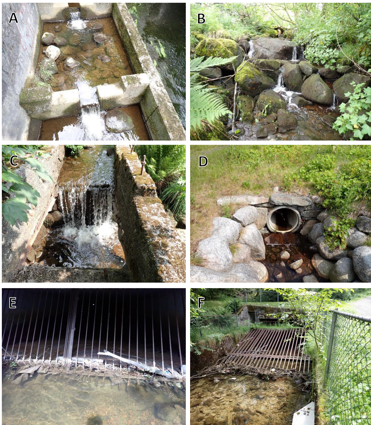
Figur 108. Vandringshindre og bekkelukkinger: A) Fisketrapp, kulpene er noe grunn, men trappen fungerer trolig bra på middels vannføring B) Naturlig temporært vandringshinder i segment 19, C) Kunstig temporært vandringshinder i segment 19 D) Rør under på nedsiden av Kroatjønnveien. E og F) Den lange bekkelukkingen nederst i Orrtuellen har rist både nederst (E) og øverst (F). Lysåpningen er stor nok til at fisk kan passere, men oppsamling av kvister ol. kan gjøre det vanskelig for fisk å passere.
