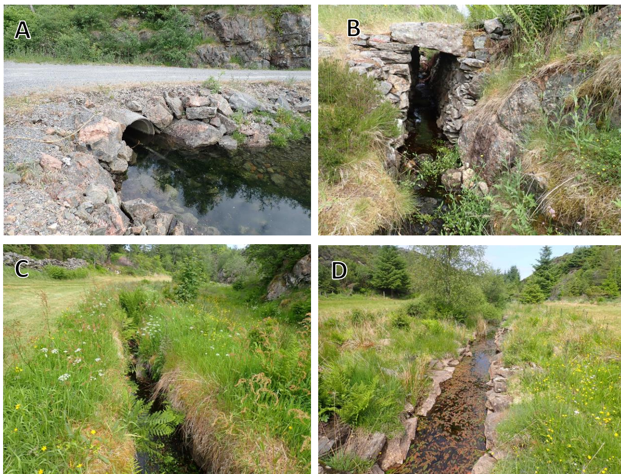
Figur 156. Bekkelukkinger og morfologiske inngrep: A) Røret nederst med utløp til sjø ligger flatt og er lett å passere for fisk. B) Eksempel på ett av de mange korte bekkelukkingene oppover elven, alle er greie å passere for oppvandrende fisk. C) Utrettet strekning, med forbygninger og manglende kantvegetasjon i segment 4. D) Utrettet strekning, med forbygninger og manglende kantvegetasjon i segment 6.
