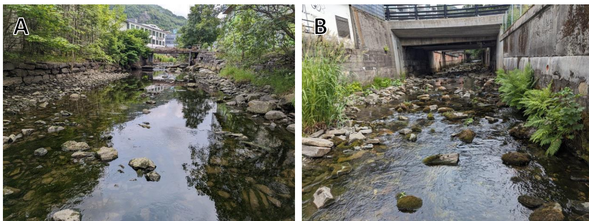
Figur 130. Morfologiske inngrep i Møllendalselven: A) I nedre del er det forbygd med steinmurer, og kantvegetasjonen er noenlunde intakt. B) Videre oppover er det betongmurer på begge sider og kantvegetasjonen mangler.
