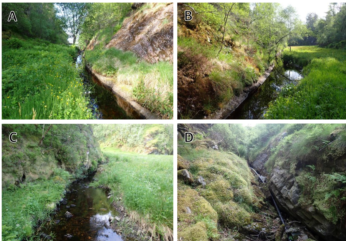
Figur 143. Davangervågvasdraget: A) Elven fra segment 3 og nedover mot sjøen. B) Oppover i segment 3, renneparti med manglende kantvegetasjon. C) Gyteareal i segment 5, kantvegetasjon mangler. D) Tørrlagt løp med absolutt vandringshinder i segment 7.
