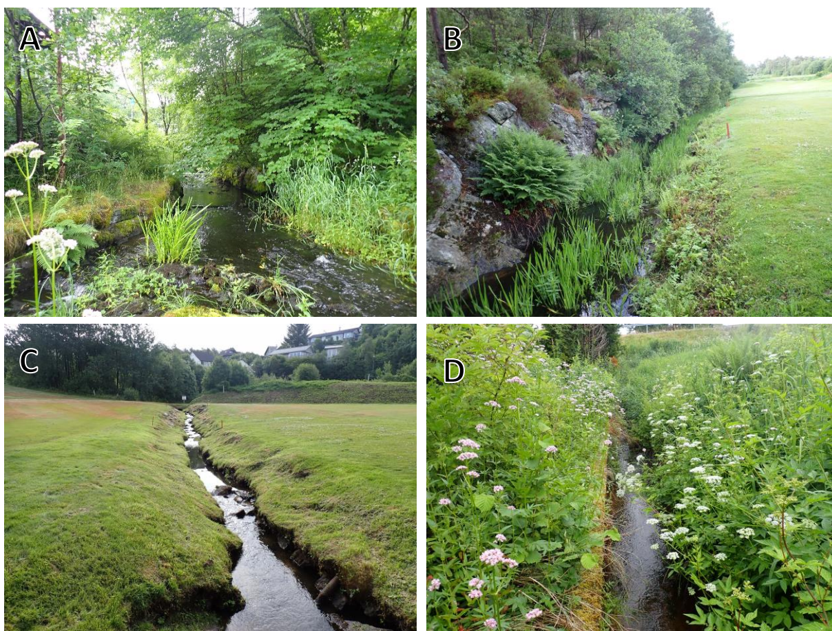
Figur 95. Morfologiske inngrep i Steinsvikbekken: A) Kanalisert og forbygd elveløp langs Steinsvikvegen. B) Kanalisert elveløp uten naturlig kantvegetasjon på den ene siden. C) Forbygning og manglende kantvegetasjon i segment 40. D) Forbygning og lite utviklet kantvegetasjon i segment 55 og 56.
