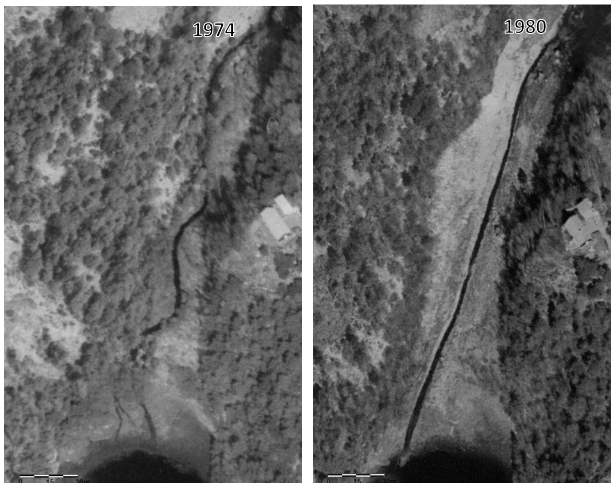
Figur 77. Utretting og kanalisering av elveløpet like ovenfor Grimseidvatnet. Her skjedde utrettingen en gang i perioden 1974 til 1980, elveløpet på strekningen er redusert fra 255 til 240 m (6 %).
