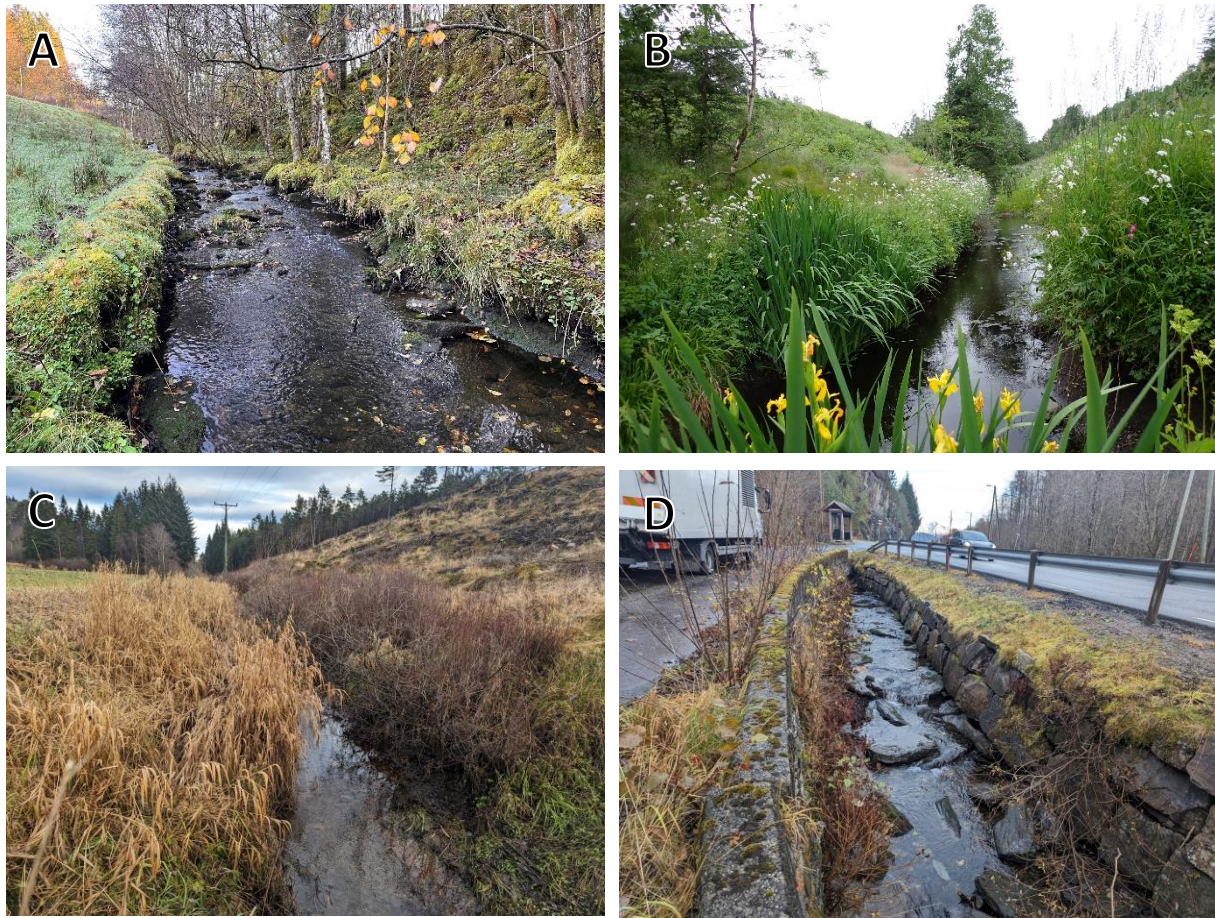
Figur 22. Morfologiske inngrep i Lonaelva: A) Forbygning og manglende kantvegetasjon nordsiden av elven i segment 3 B) og C) Kanalisert og utrettet elveløp uten naturlig kantvegetasjon i tresjiktet i segment 12 og 16. D) Forbygd og plastret strekning uten kantvegetasjon i segment 18.
