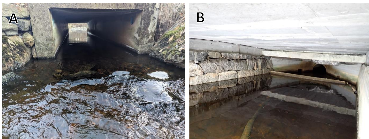
Figur 123. Vandringshindre og bekkelukkinger: A) Kulvert mellom segment 4 og 5 med naturlig elvebunn og god vanndekning. B) Terskel øverst mot Gjeddevatnet.
