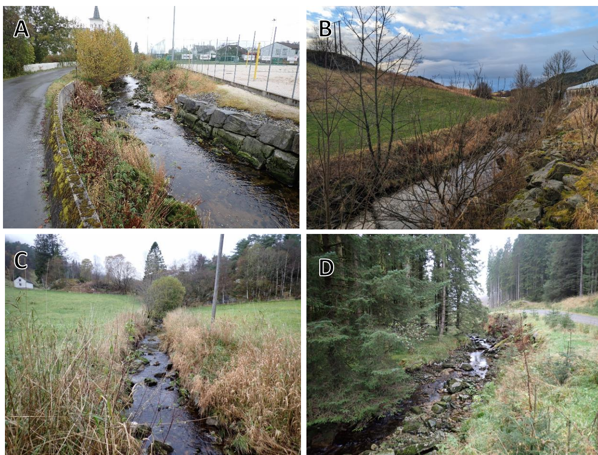
Figur 6. Morfologiske inngrep i Vikaelva: A) Kanalisert elveløp, med forbygning og manglende kantvegetasjon langs fotballbanen i segment 5. B) Elvestrekning med forbygning og lite utviklet kantvegetasjon i segment 9. C) Manglende kantvegetasjon i segment 27 i det vestre løpet. D) Manglende kantvegetasjon i segment 58 i det nordre løpet.
