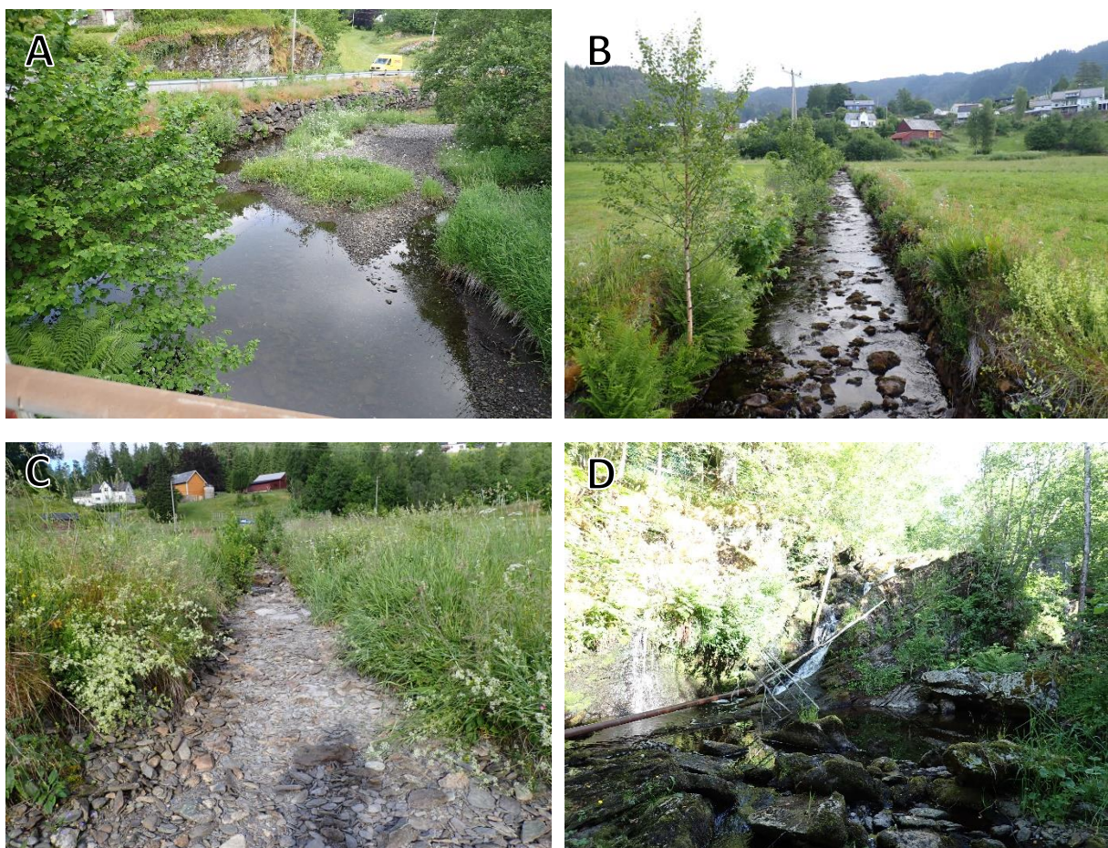
Figur 35. Nordvikelva: A) Forbygning og manglende kantvegetasjon langs gyteområde i nedre del av elven. B) Utrettet strekning med forbygninger og manglende kantvegetasjon i segment 6 og 7. C) Sideløp fra vest som kommer inn øverst i segment 7 går tidvis tørt. D) Foss som er absolutt vandringshinder øverst på kartlagt strekning.
