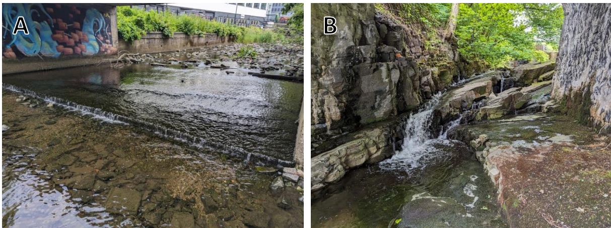
Figur 129. Vandringshindre og bekkelukkinger: A) Betongterskel under den nederste broen er vanskelig å passere på lav vannføring. B) Naturlig temporært vandringshinder i øvre del av elven.
