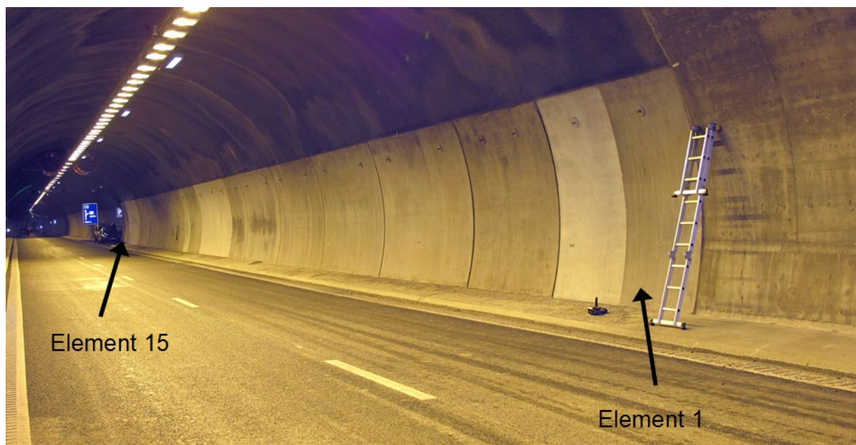
Figur 2 Forsøksfeltet i Askimporten tunnel fotografert like etter påføring av overflateproduktene i 2010. Elementene er nummerert fra portal mot Oslo (til høyre i figuren). Foto: Eva Rodum, Statens vegvesen.
