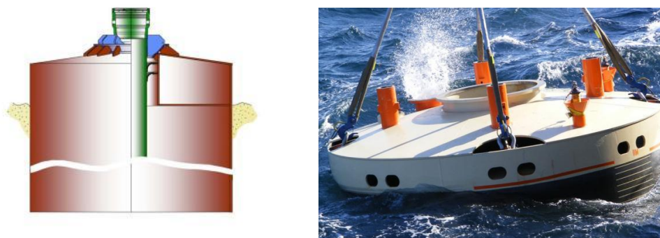
Figur 3.1. CAN (Casing Anchor Node) skjematisk og under installering. Kilde: Neodrill
