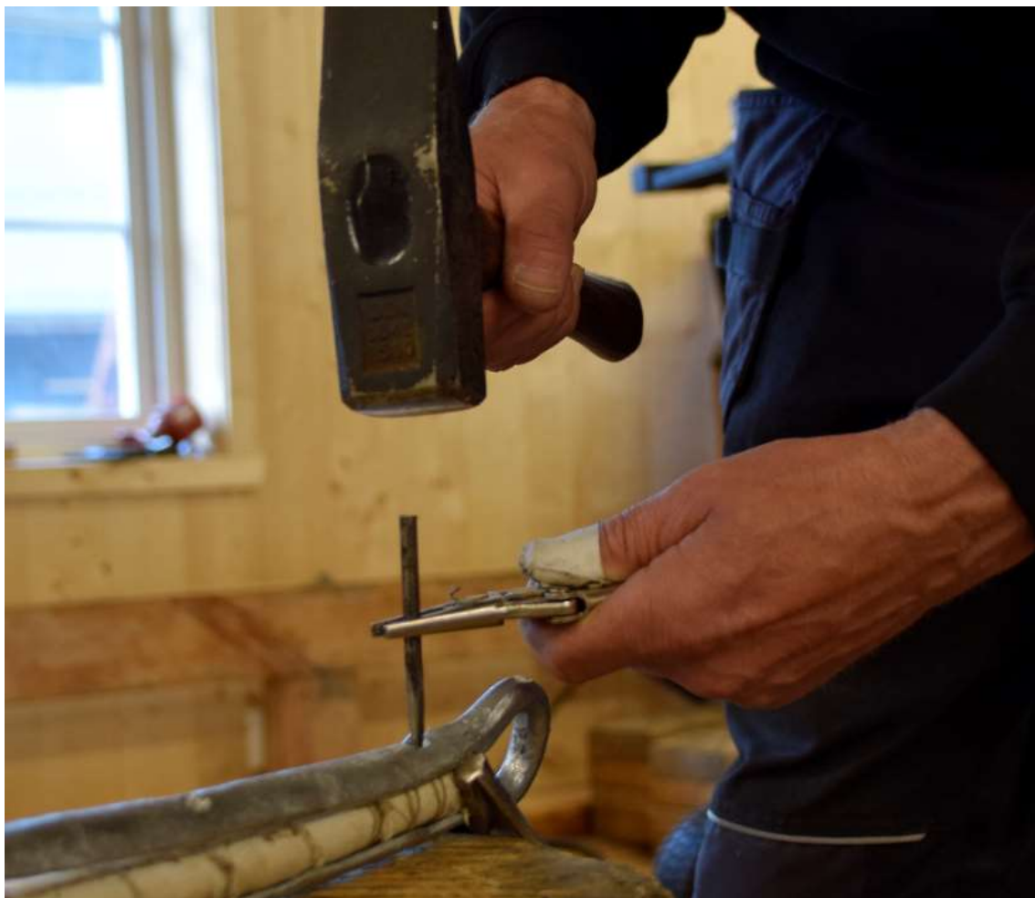
Figur 88 Ledebolten skal drives gjennom doppsko og wiren. Den må være av hardt materiale som er tilspisset, gjerne som en flatt skuejern. (foto: HFS)
