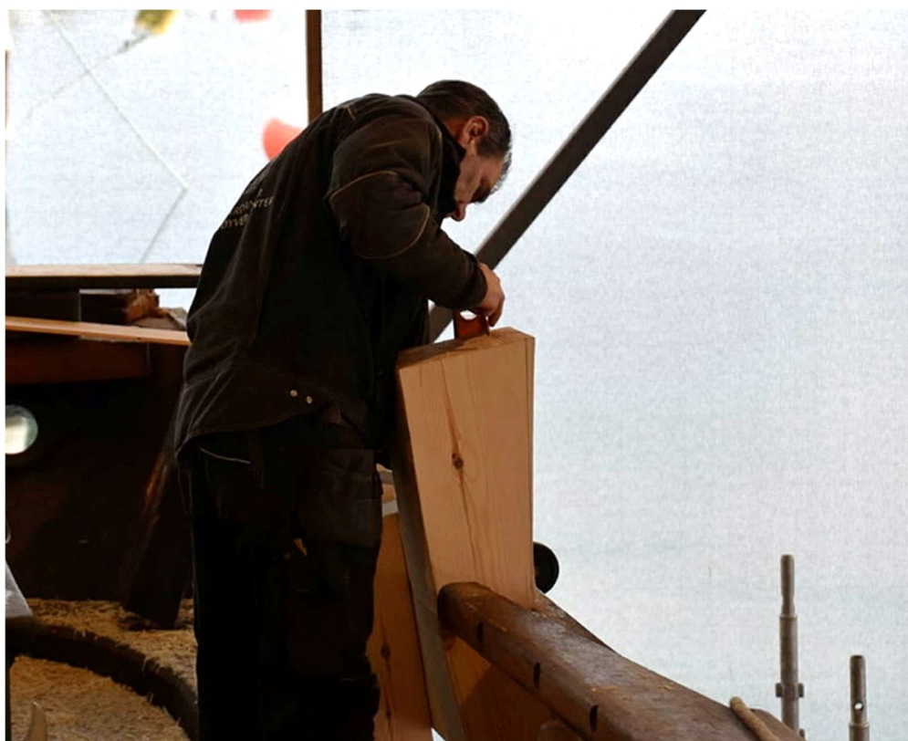
Figur 16: Ivar Hoflandsdal har laget nye og høyere rekkestøtter hvor toppen stikker opp over rekka. Her lodder han opp den delen av støtte/pullert som stikker opp over rekka.
