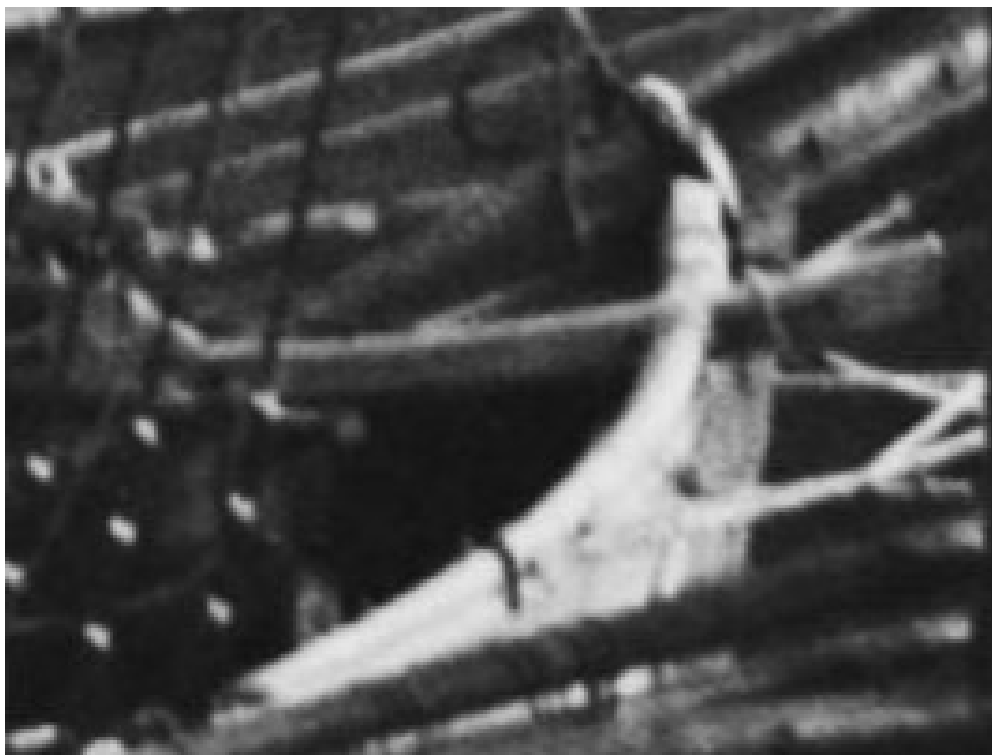
Figur 45 Utsnitt av foto fra jakt "Mathilde" i Kristiansund 1932. Her ser vi at kranbjelken tynner av innover og at den har en svak bananform. Dette er noe som går igjen på mange av de fotografiene av jakter vi har sett. Derfor bestemte vi oss for å bruke dokumentasjonen vi hadde tilgjengelig og laget nye kranbjelker i furu.
