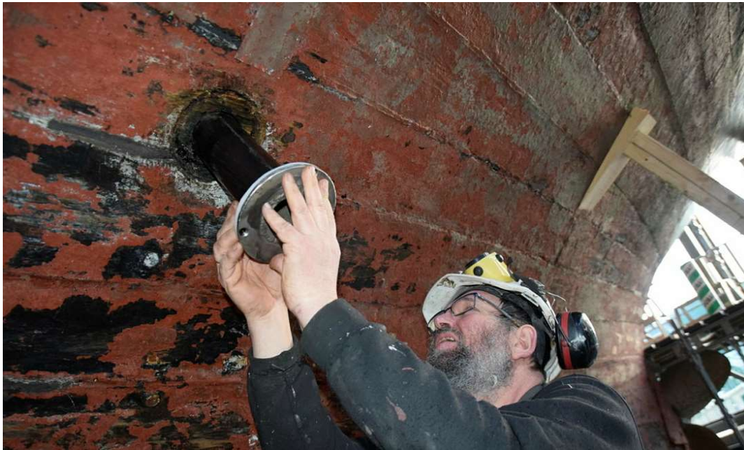
Figur 13 Peder Furuberg monterer tilbake sjøvannsinntaket og isolerer metallet fra treverket.
