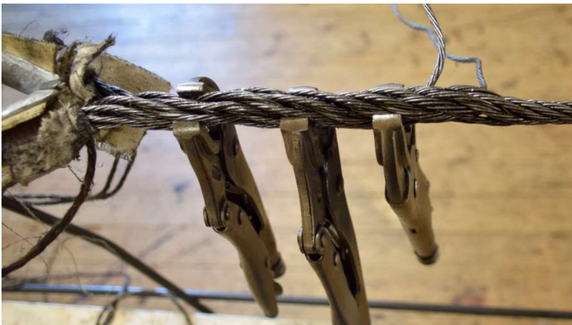
Figur 77 For å få en mere jevn og tet spleis ble bukter av kordeler presset på plass med sveiseklemmer innen de ble kappet med vinkelsliper. (foto: HFS)
