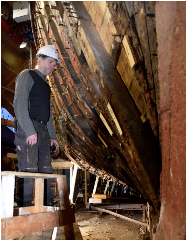
Figur 9: Basen for istandsettingen, Kasper Krogh Hansen, inspiserer treverket og danner seg et bilde av hva som må skiftes ut. Her har vi fjernet hudplanker fra oppunder dekk til kjølen.
