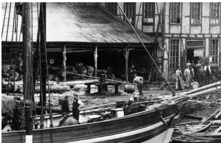
Figur 62 Foto via Peter Brennvik. Foto fra Mellemverftet etter 1910 viser tydelig at denne jakta har vant og stag av hamp. Det er altså ikke selvsagt at man rigget med wire i 1884 da Mathilde ble bygd.
