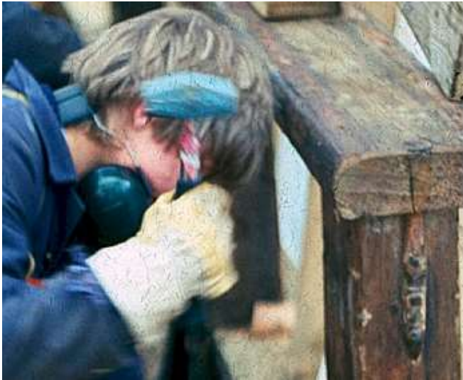
Figur 35 (foto: HFS), 1984 - 89. Her ser vi at den gamle rekka er skåret over og vi ser hvordan den er fint kurvet på innsiden. Utsiden er nok tilsvarende.
