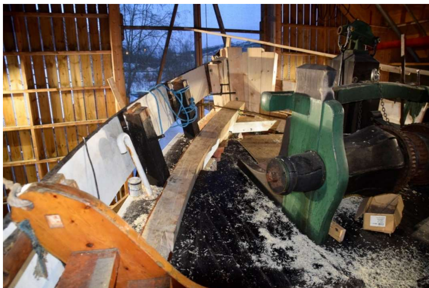
Figur 32 Nytt tømmer er lagt inn som innerstevn, og judasørene i akterkant av stevnen er fornyet. Deretter gikk vi i gang med å lage nye vaterbord og deretter dekk.
