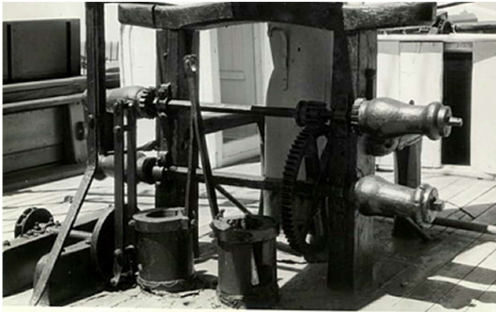
Figur 114 Foto av en ribbet jakt Gjøa i San Fransisco før istandsetting i 1947. Her ser vi at pumpestokkene og krøppelspillet fortsatt står igjen fra jaktetida, og slik det etter all sannsynlighet har vært på Mathilde også. På dette fotografiet ser vi ikke lyrer til ankerkjettingen.
