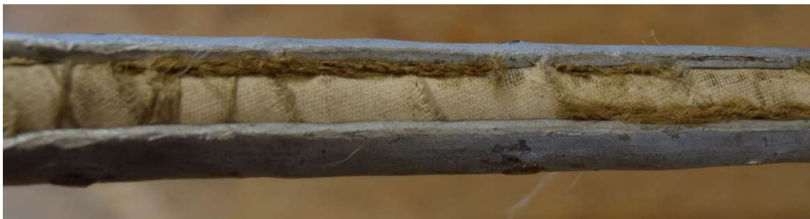
Figur 93 Eventuelle åpninger under doppskoen fylles med tjæret hampefiber (drev). (foto: HFS)
