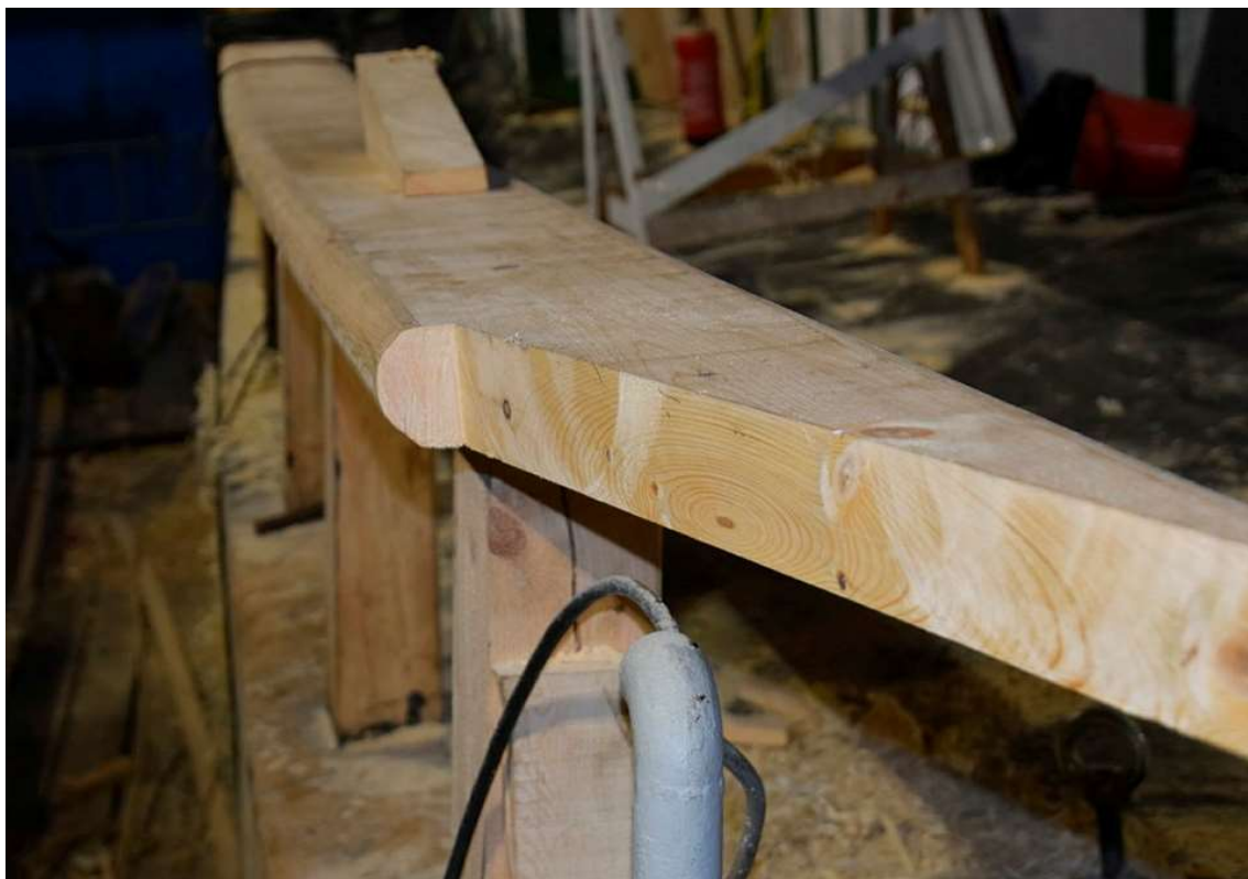
Figur 37 Tilbake til furu, og nå avrunder vi kanten både ute og inne.
