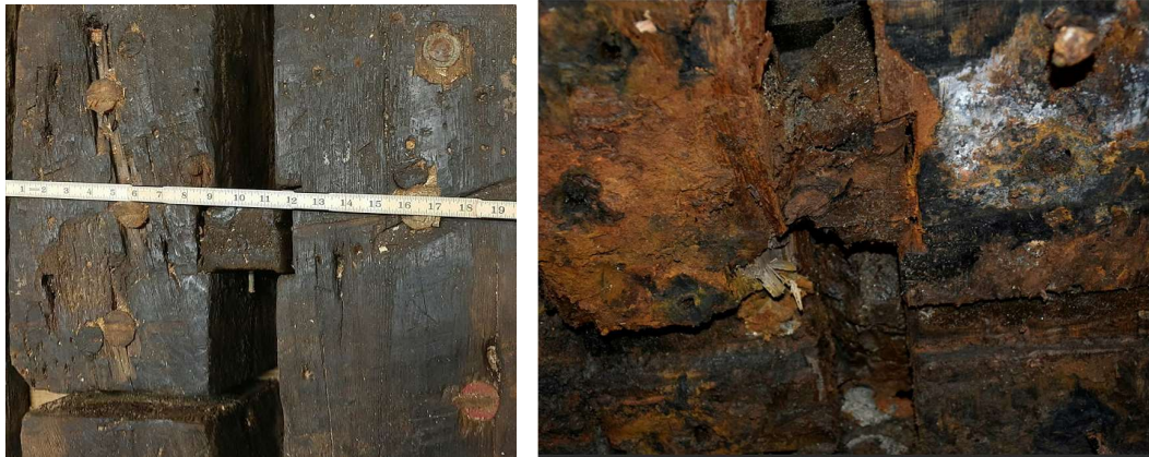
Figur 6 (foto: HFS). Avstandsklossene på "Søblomsten" er felt inn, men uten svalehale. Til høyre kan man med et trenet øye se at avstandsklossen er svalet inn i det ene tømmeret, og tilpasset mot neste tømmer. Noen ganger ligger det bare jevnt med tømmeret, mens andre ganger er det hugd inn.
