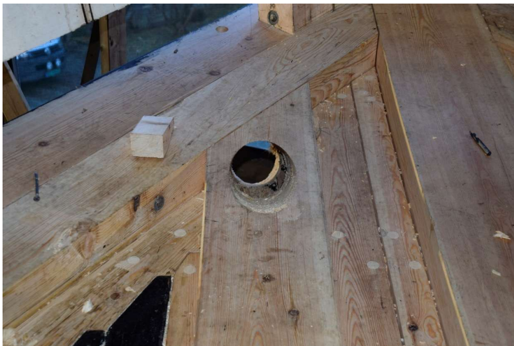
Figur 33 Nytt vaterbord, skandekk, fisker i dekk og dekk har kommet på plass igjen. Her ser vi at det er boret hull for ankerklyss.
