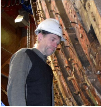
Kasper Krogh Hansen, båtbygger, rigger og bas under arbeidet.
