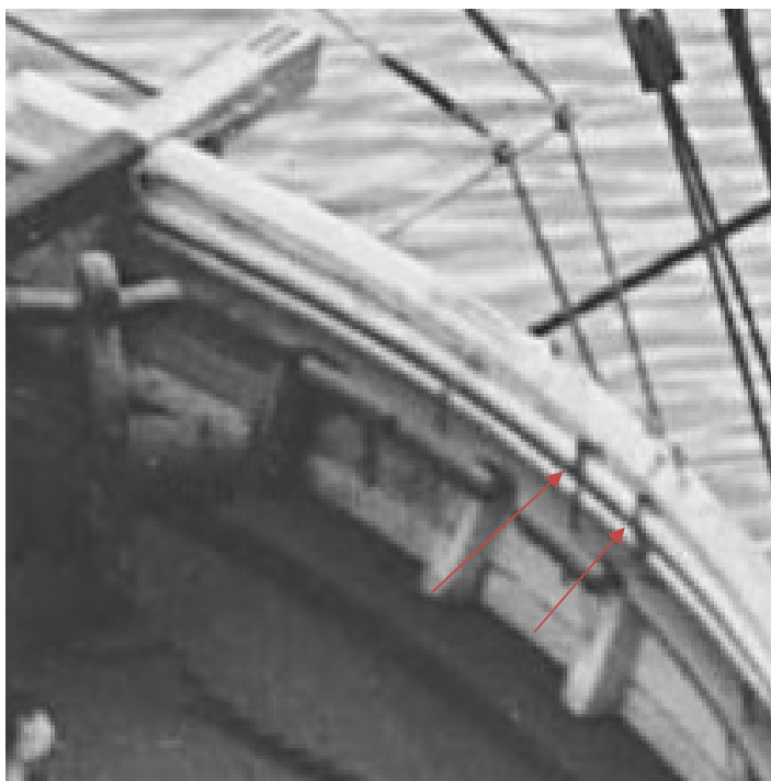
Figur 57 Utsnitt av et foto tatt av Anders Beer Wilse, Kristiansund 1897. Her ser vi en slik butelur som det etter all sannsynlighet har vært på Mathilde, og vi ser også kjettingene som kommer gjennom svineryggen på denna jakta. På Mathilde tolker vi det dithen at kjettingene fra bardunene kommer gjennom topprekka, slik som i Figur 12.
