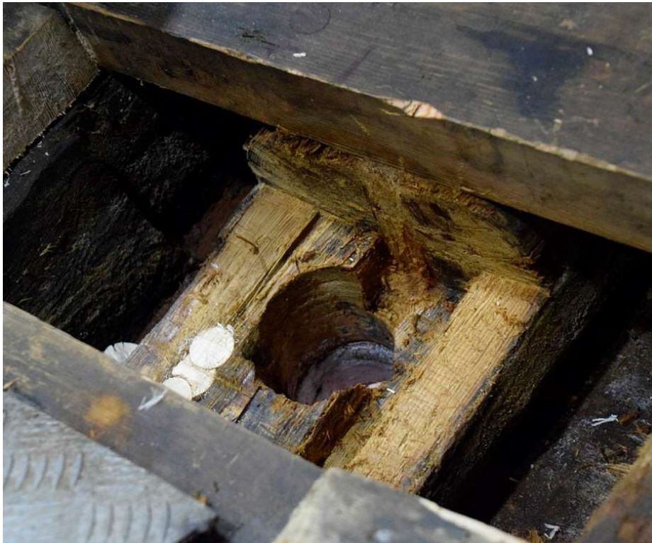
Figur 11 Det oppløste treverket er hugd bort, og det er klart for at nytt treverk skal spunes inn. Da ventiltrøret ble montert tilbake ble dette trukket med en krympestrømpe for å forsøke å isolere mellom treverk og rør. Under flensene ble det også isolert.
