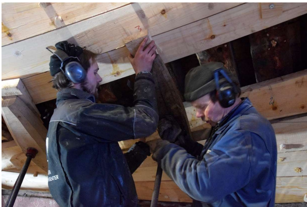
Figur 24 Godt samarbeid er nøkkelen til suksess, og Erik og Terje arbeidet tett sammen under hudingen. Her får de en hudskrue på plass.
