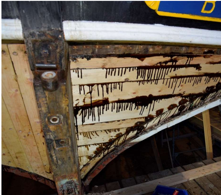
Figur 29 Mads har fått både hukmann, altså akterste spantet og innerkledningen på plass. Mellom plankene er det smurt med tretjære for å unngå råde de første årene.
