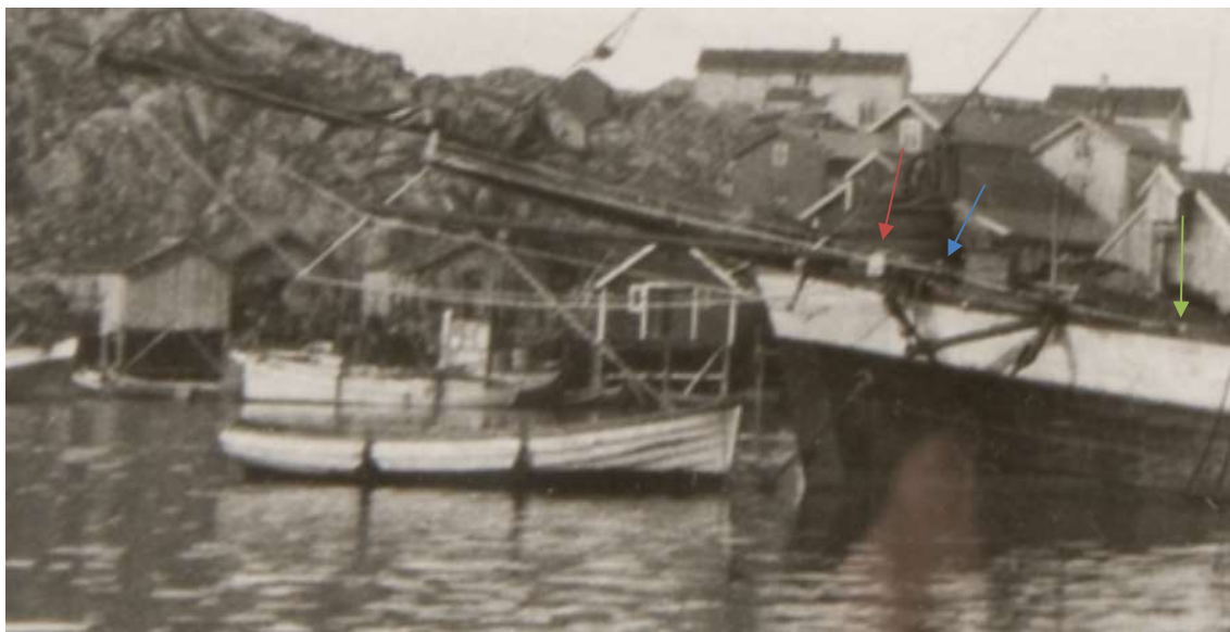
Figur 56 Utsnitt av foto av Mathilde i Skrova 1918. Den blå pila peker mot buteluren og den rød pila mot kranbjelken. Vi ser at det er god avstand mellom dem, og vi ser også at den hvite streken som kommer forfra får et heng på hver side av buteluren før den går inn i rekka lengre akter (grønn pil).
