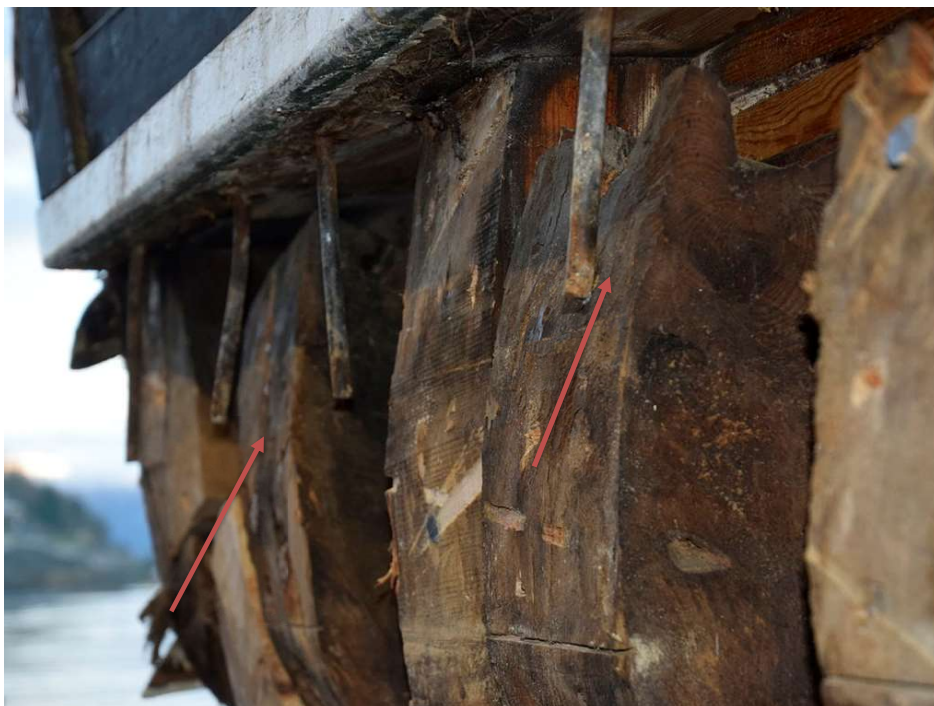
Figur 7 I akterskipet er Mathilde lagt noe ut i forhold til opphavet. Vi kan se på de to spantetoppene, merket med rød pil, at toppen legger seg innover, mens rekkestøtta og tømmeret i hekken er mer oppreist. Den øverste bordgangen har altså ligget en del mer innover oppunder skandekket enn det vi ser i dag. Vi var klar over dette før vi hudet opp på nytt, men siden vi kun skulle jobbe på styrbord side fulgte vi dagens fasong slik at det fortsatt et likt fra side til side.
