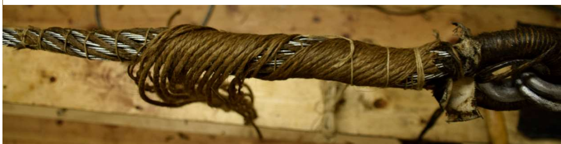
Figur 79 Andre del av vormingen hvor den spiralformete gruve fylles ut, her med rester av sjømannsgarn. (foto: HFS)
