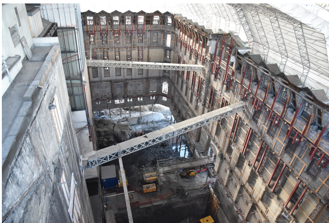
Fasaden og fasadeavstivningen i byggeperioden. Foto: Stortinget
