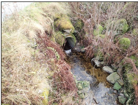
C) Rør i segment 29
