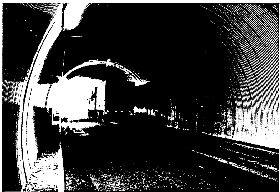
Foto 1-3. Platetak i Åtland tunnel på E 18 i Vest-Agder.
