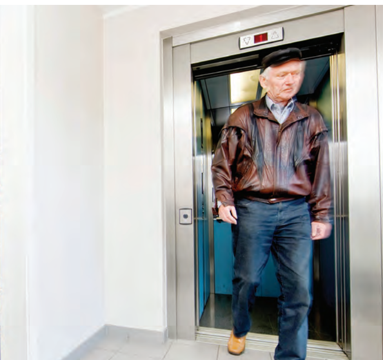
Borettslaget Østre Børstad II, Hamar: Borettslaget etterinstallerte ordinær heis i 2004. Inngangspartiet ble utvidet og den ordinære trappa beholdt.
