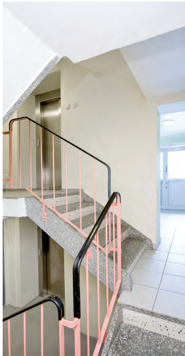
Borettslaget Østre Børstad II, Hamar: Borettslaget etterinstallerte ordinær heis i 2004. Inngangspartiet ble utvidet og den ordinære trappa beholdt.
