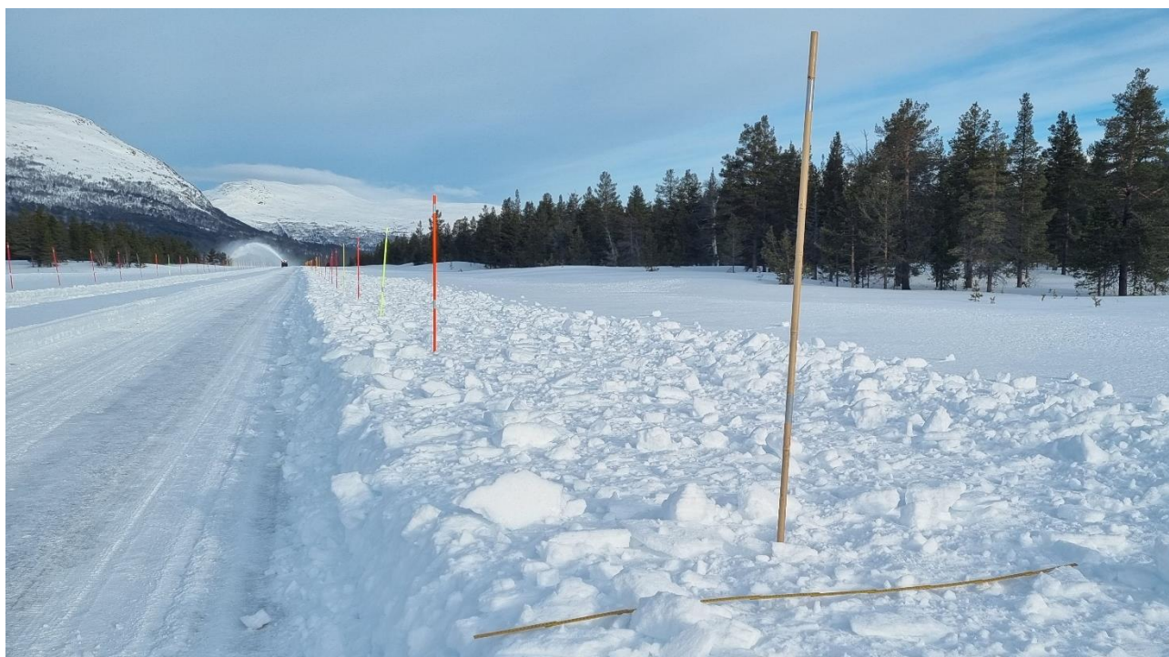
Figur 37: Forholdene på flystripa etter 1. brøyting ifbm belastningstest i kuldegrader/kaldt vær.
