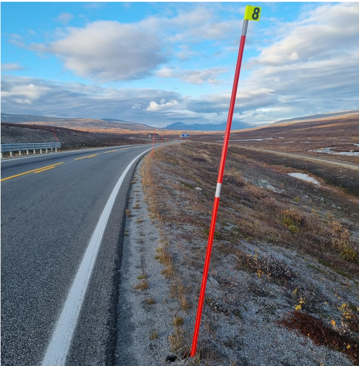
Figur 15: E6 Saltfjellet ved Stødibrua, retning nordover.
