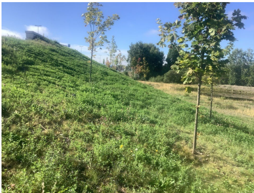
Figur 4.9: Beplantning ved Rampedammen (bildet er tatt mot sør, 2022). Høy, plasskrevende vegfylling minsker areal med potensiale for våtmark. Foto: Heidi Solstad.
