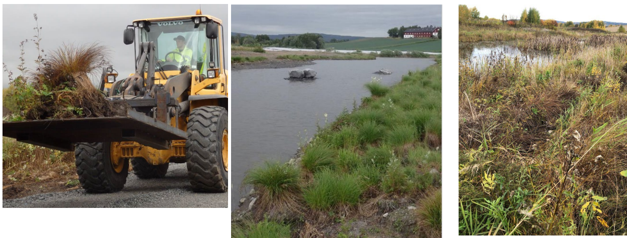
Figur 4.4: Flytting av tuestarr (venstre bilde, fra Nye Veier AS), tuestarrbeplantning i 2018 (midtre bilde, fra Nye Veier AS), og under befaring i oktober 2022 (høyre bilde, foto: Heidi Solstad).
