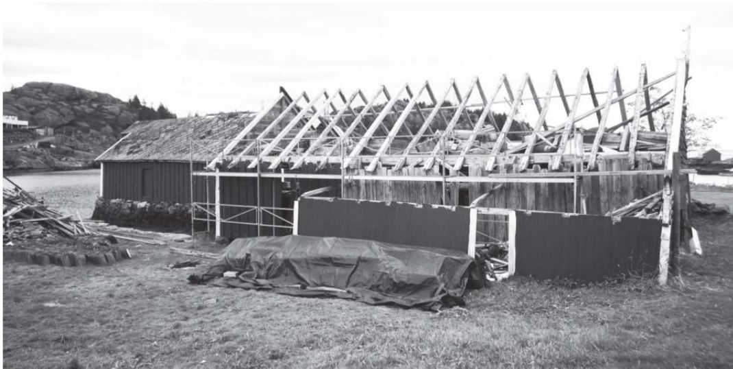
Vølingsarbeide på Solund høsten 2014
