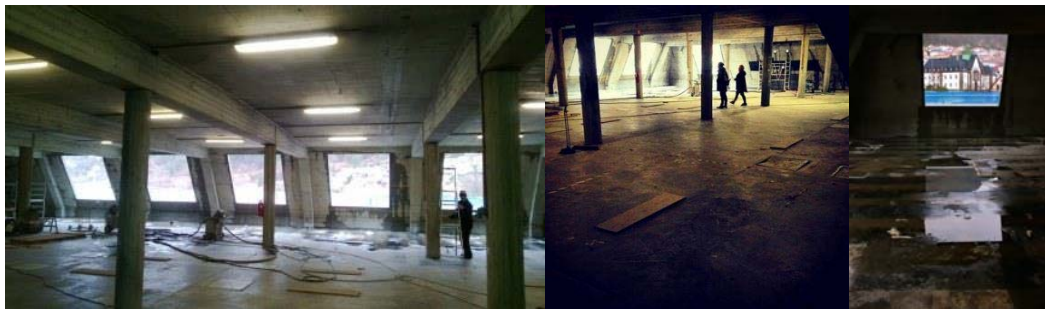
Oppgradering på toppen av BAS-bygget med betongsaging for vinduer
