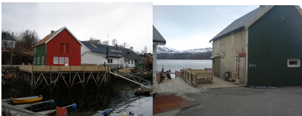
Figur 3.4.7: Oppussing av gammel sjøbod i regi av båtforeningen
