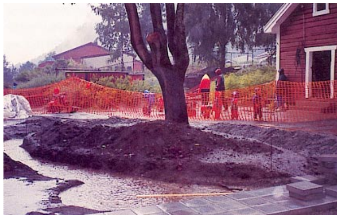
Grunn / terrengarbeider og etablering av faste dekker bør overlates til profesjonelle yrkesutøvere.
