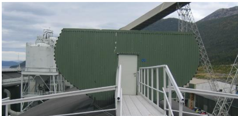
Figur 11.13 Elektrolysehall med tulipan taklyre. Foto: Håkon Skistad
