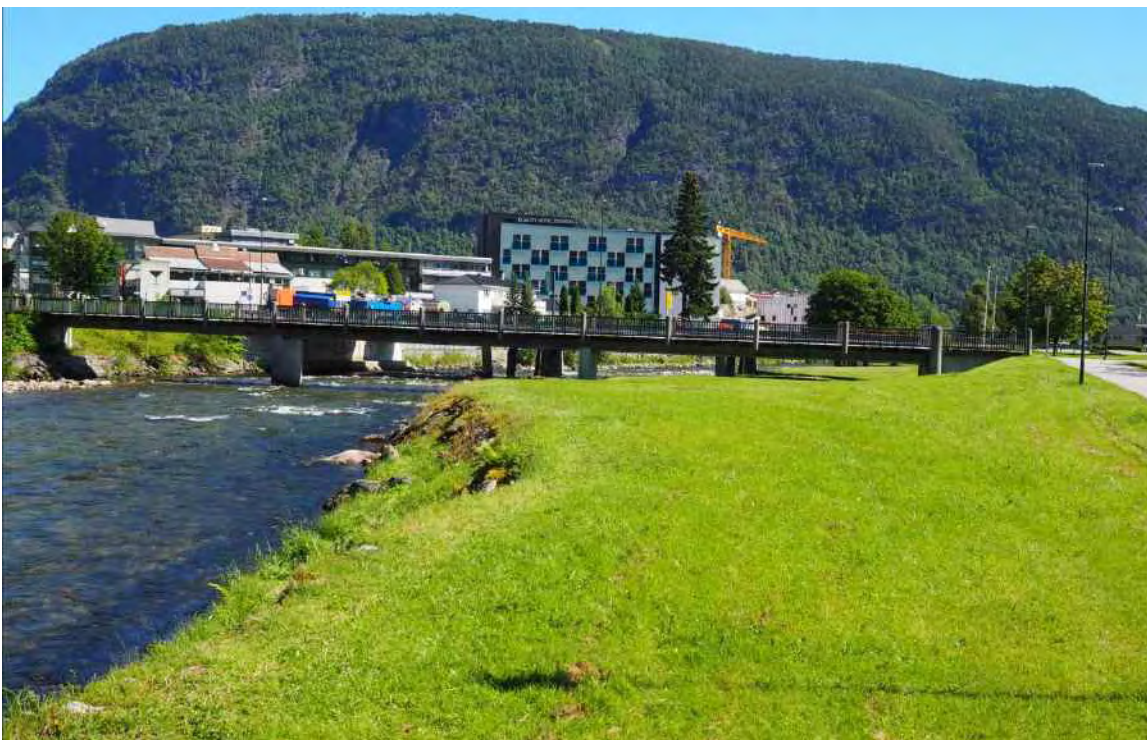
Figur 53 Høgtliggende terreng oppstraums gangbru oppstraums Stedje bru, sett i medstraums retning. Senking av terrenget her vil auke vassmengda som renn på den sørlege flaumsletta under gangbrua og Stedje bru.
