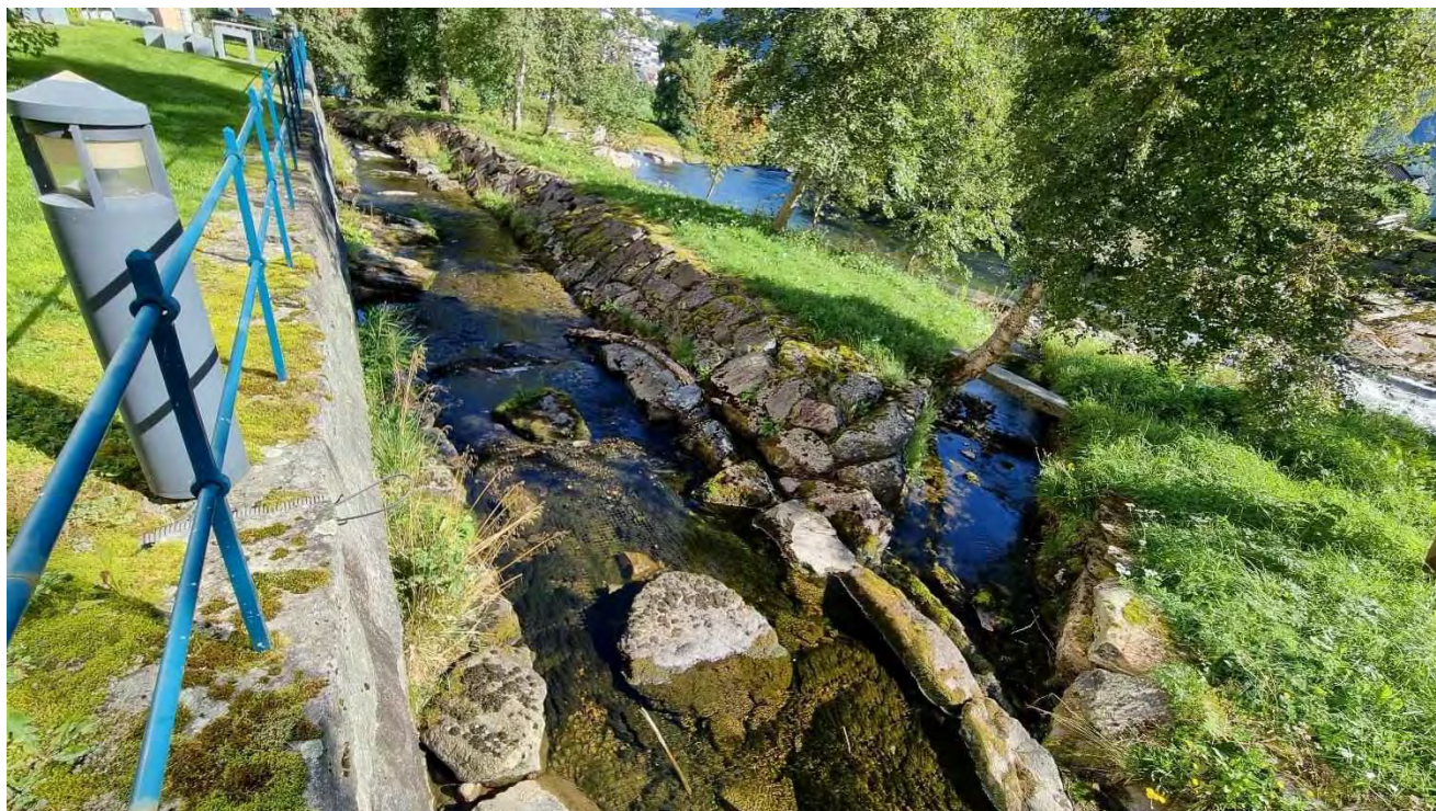
Figur 5. Kanalen langs mur mot Lærarhøgskulen.
