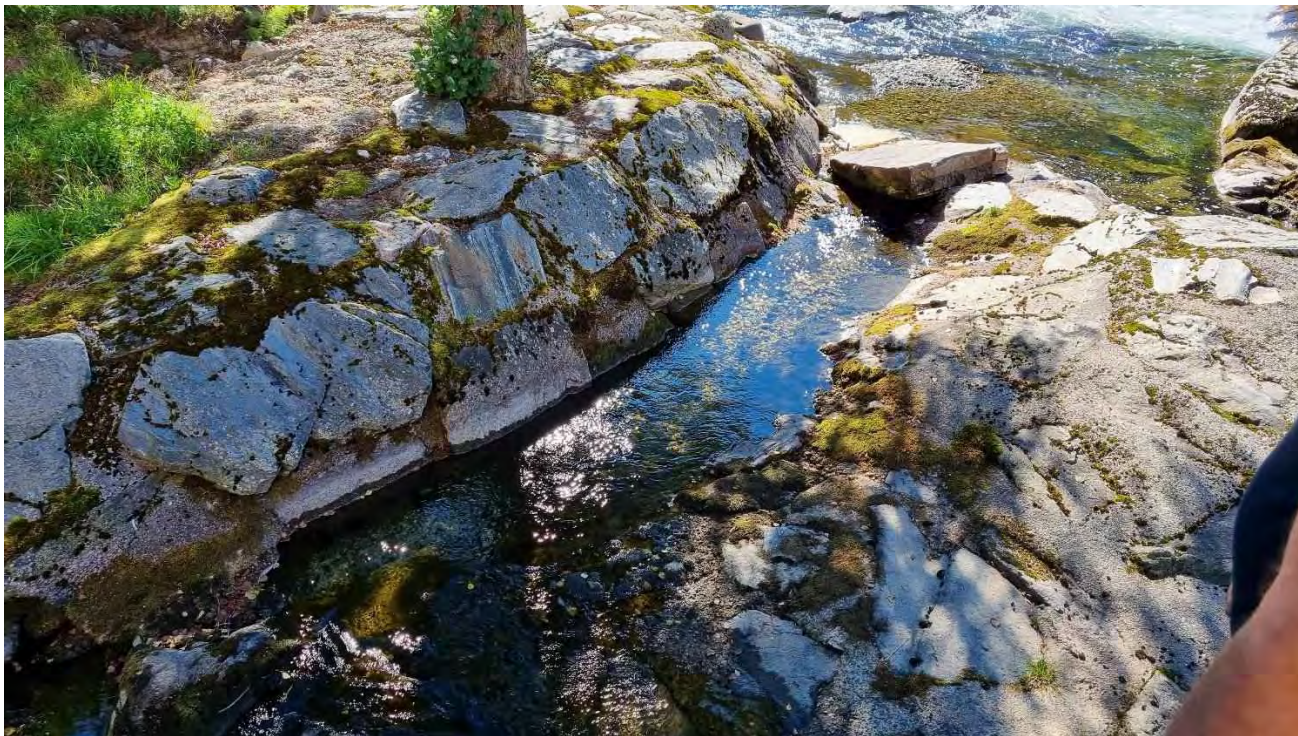
Figur 4. Innløpet til kanalen ved Lærarhøgskulen. Innløpet er delvis blokkert av en stor stein. I tillegg er det støpt på en slik måte at vannføringen blir liten og innstrømretningen er endret i forhold til før støping.
