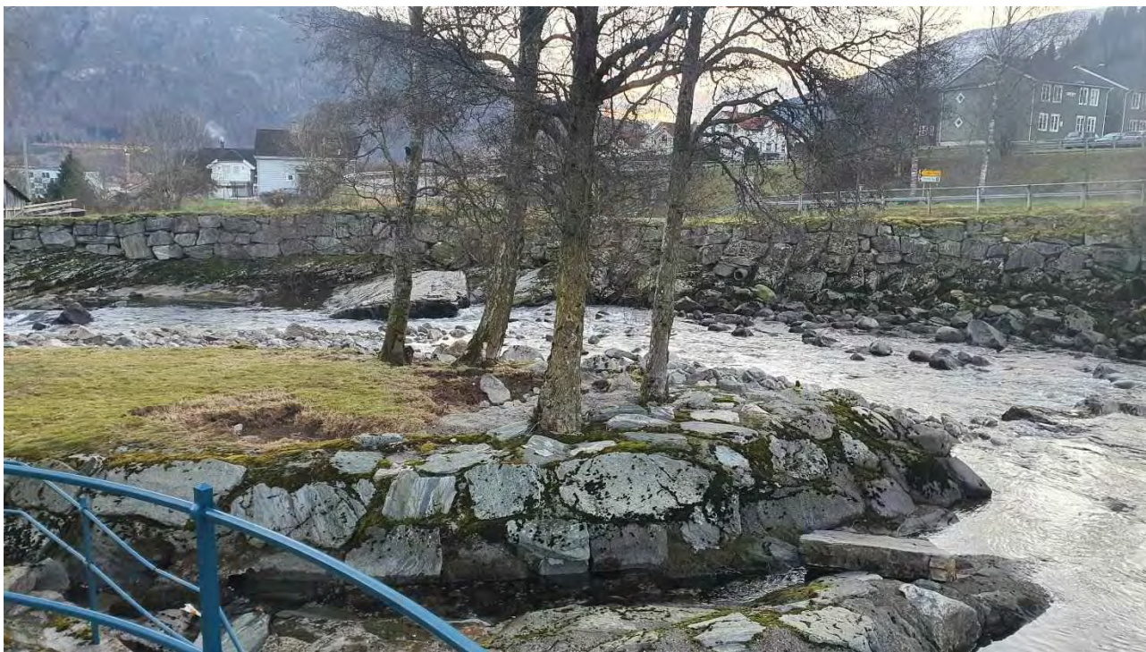
Figur 60 Eksisterande mur i svingen ved RV5 og Møllevegen.
