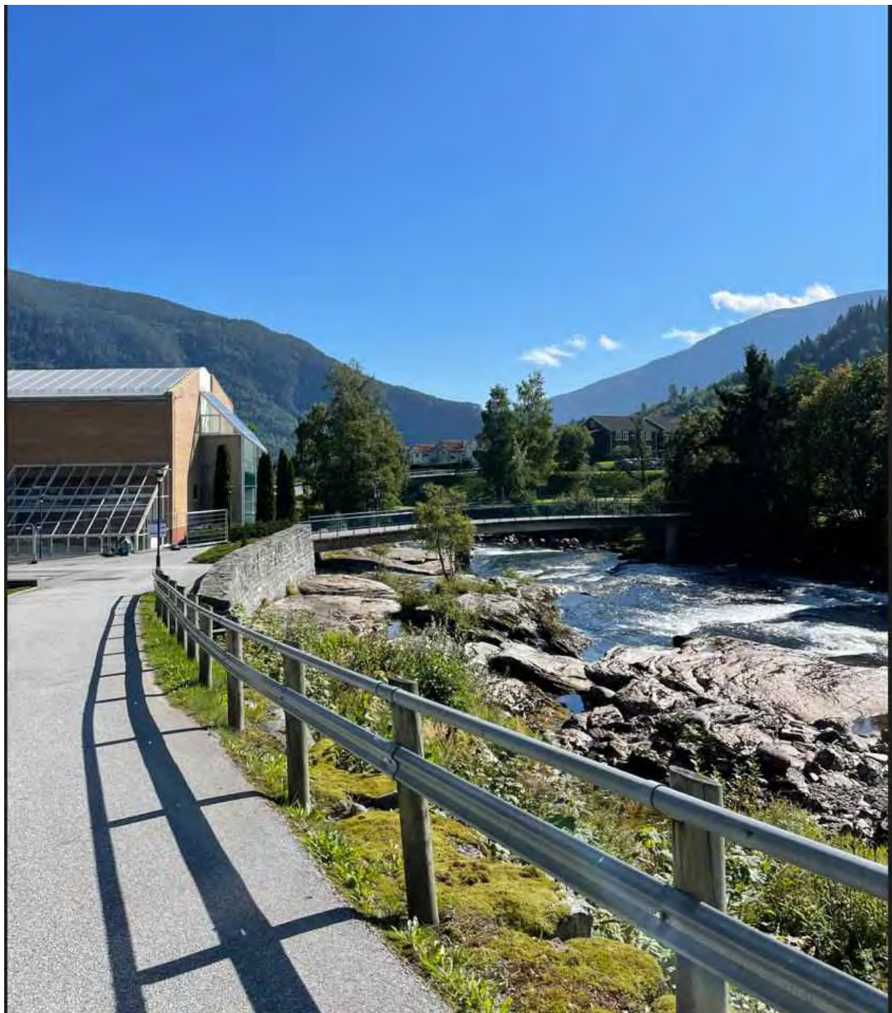
Figur 65 Eksisterende mur oppstrøms Fossbrui forlengast med 10 m i motstrøms retning.
