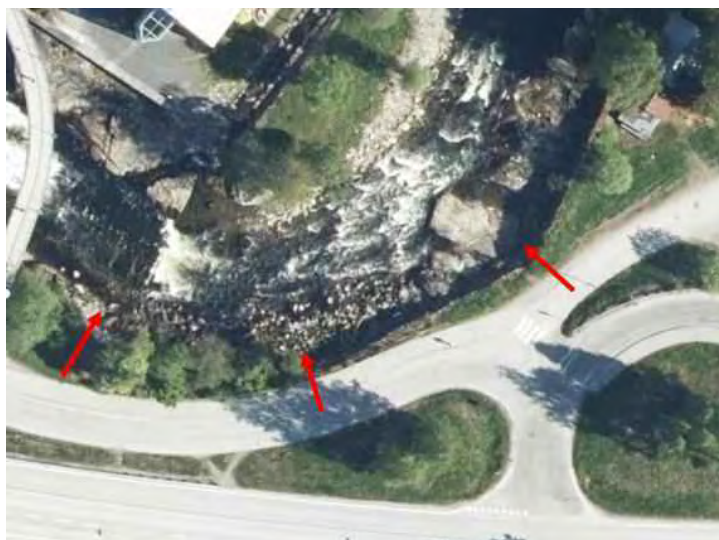
Figur 12 Flyfoto ved Fossbygget. Raude piler markerer utløpsrør overvatn
