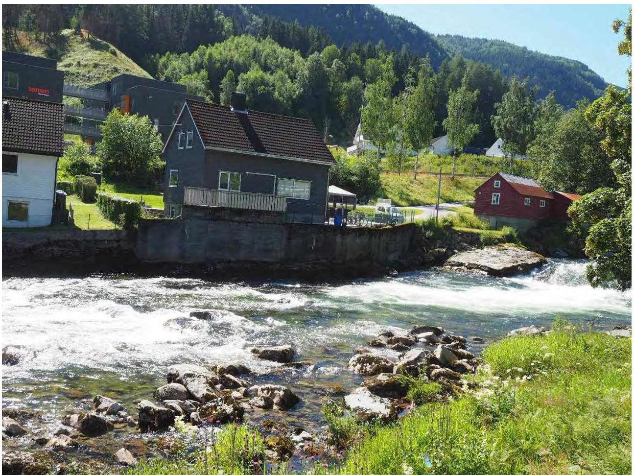
Figur 57 Bustadhuset Møllevegen 36 (grått hus midt i biletet) og 38 (kvitt hus halvveges ute av biletet)– eksisterande situasjon
