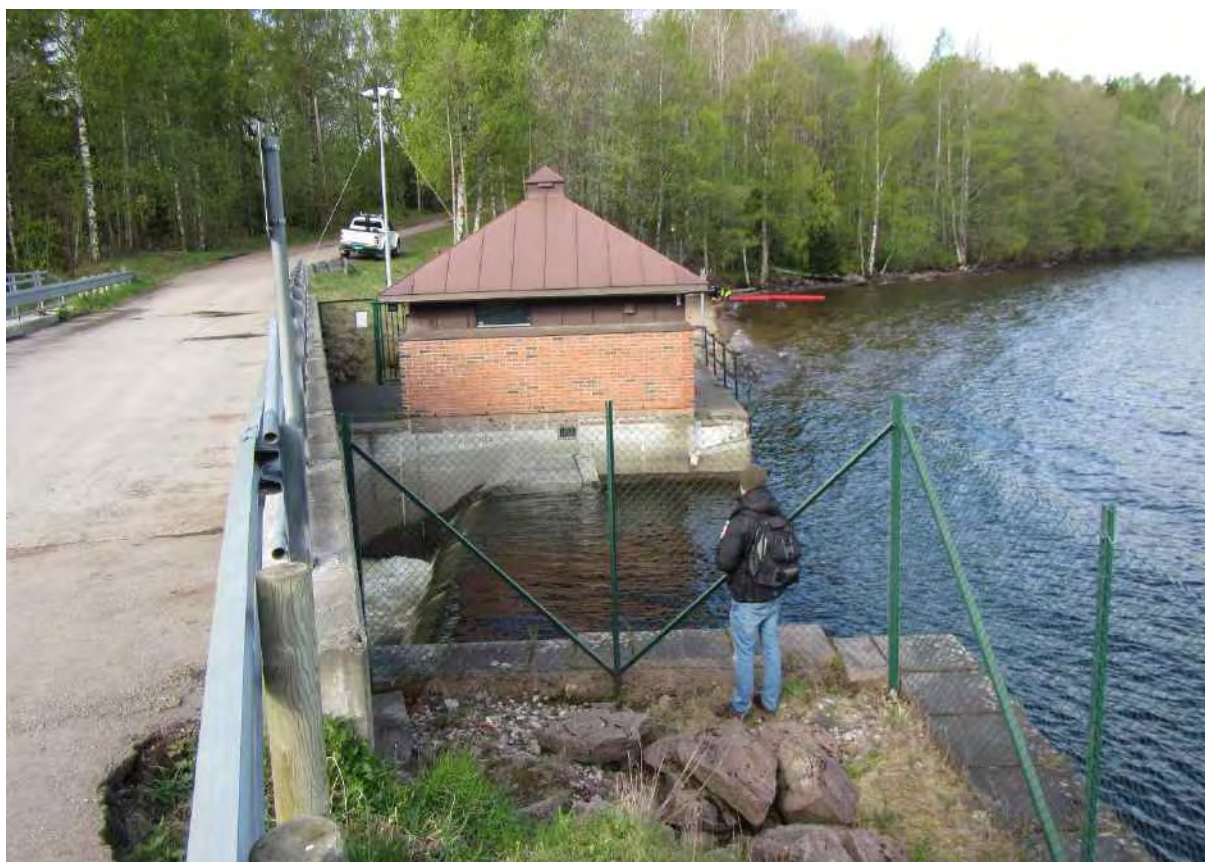
Figur 40 Døme på ein lukedam med klappeluke ved Maridalsdammen. Luka har ei breidde på 10 m og ei høgde på 2,5 m.
