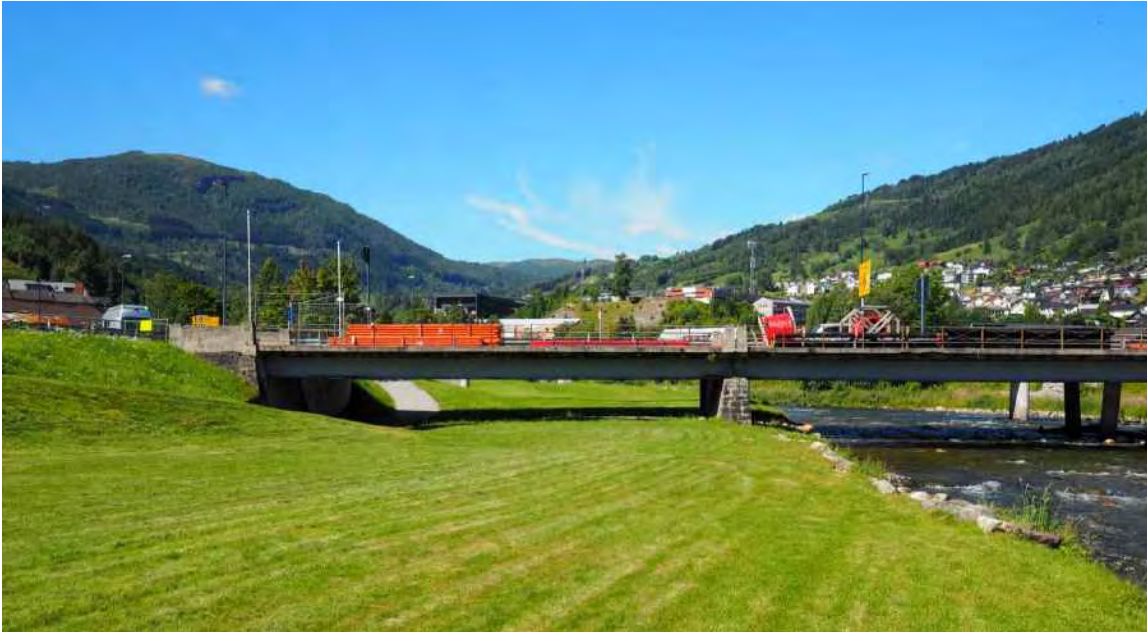
Figur 52 Stedje bru, sett i motstraums retning. Gangvegen stig i begge retningar frå rett under bruene. Kapasiteten her kan eventuelt utbetrast ved omlegging av gangvegen og/eller bruk av støttemur for å trekke skråningsfoten lenger sør.
