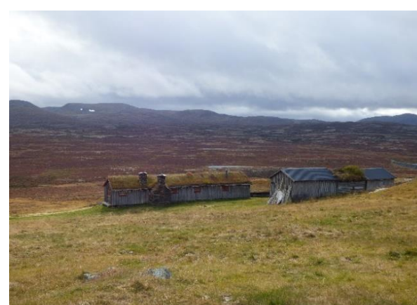
Seterstue med utvendig brannmur og pipe bygd av lokal naturstein.
