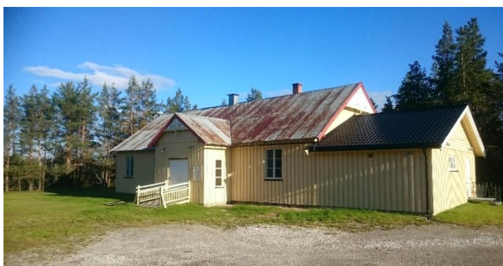
Grendehuset Vårtun fotografert 2020.
