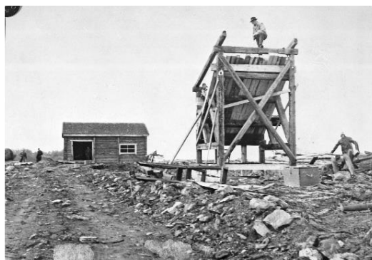
Heis- og kompressorhus og sjakttårn/ heistårn ved Grimsdalsgruva. Foto: MINØ.020821
