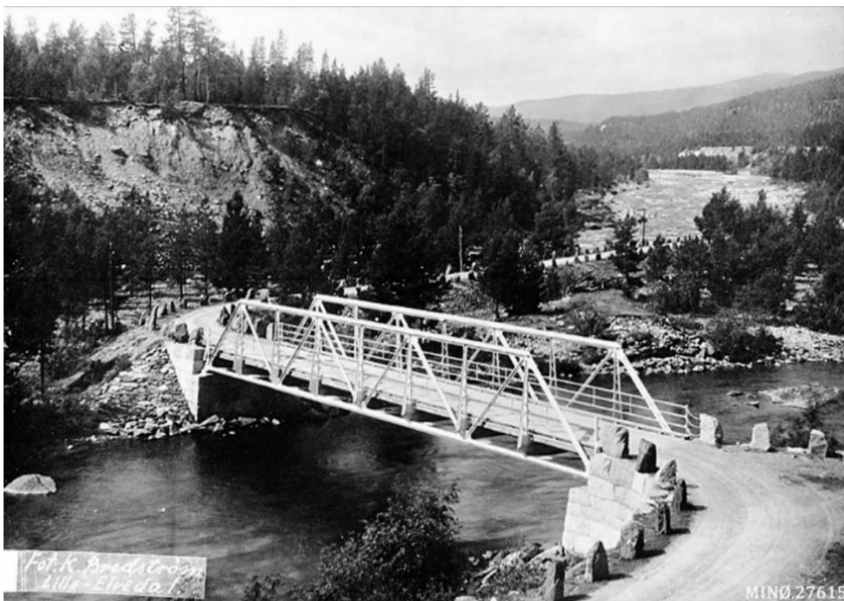
Den gamle brua over Einunna som ble sprengt i april 1940. Fotograf: Alexander Bredstrøm Ansberg, MINØ 027615.
