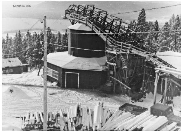
Sjakttårn og taubanestasjon ved Søndre Geitryggen fotografert 1956. Herifra gikk taubane opp til Nordre Geitryggen, og derfra videre til oppredningsanlegget ved Verket. Foto: Musea i Nord-Østerdalen, nr. 47706.
