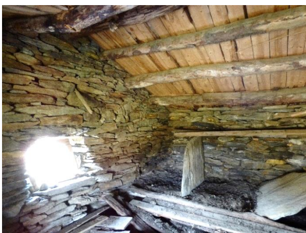
T.v.: I det gamle steinfjøset er store skiferheller satt opp som båskiller.
