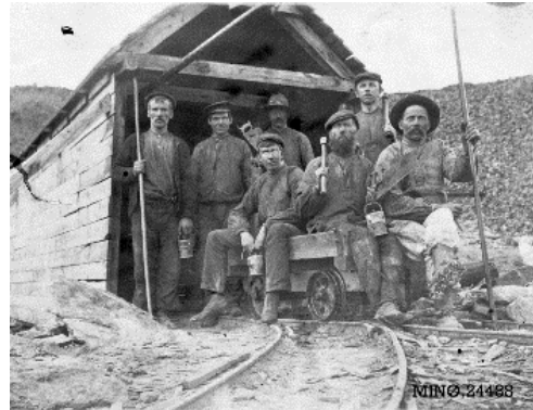
Gruvearbeidere ved Fолldal Verk. Foto: MINØ.024488
