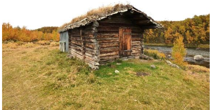
Stallen og bua er blitt bygget sammen, og den laftede bua er restaurert. Innvendig er det lagt nytt golv og bygget benker.
