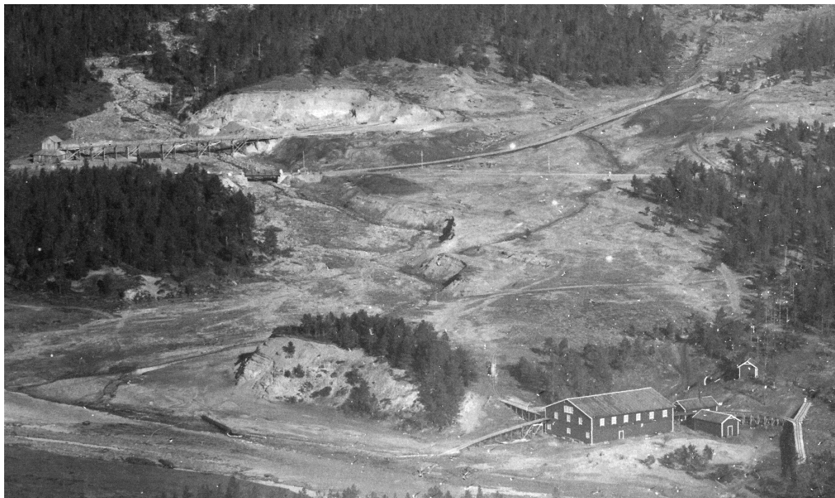
Industriområdet ved nedre smeltehytte. Sandbanens taubanestasjon til venstre i bildet, med taubanen som gikk opp til det øverste gamle gruveområdet. Litt lenger ned, ved elva, sto dampsagen som ble bygget i begynnelsen av 1900-tallet. Seinere (etter 1935) ble det anlagt en slamdam mellom veien og Folla. I dammen sedimenterte avgangen fra flotasjonsanlegget. Fotograf: Oscar Holte, 1910
