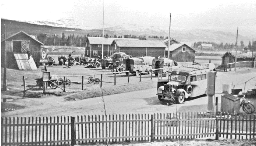
Bensinpumpen i Grimsbu på nordlig side av veien.
