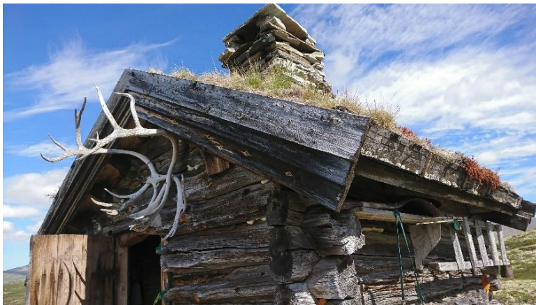
I 1978 fikk bua nytt tretak med torv oppå. Foto: Mari Tallerås
