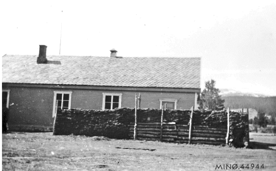
Våren 1945 forsterket okkupasjonsmakten sitt nærvær i Folldal. Tyske styrker inntok flere bygninger i Øvre Folldal: Fjellheim, Vårtun og Dalen skule. De lot russiske krigsfanger bygge skyttergraver og høye forskansningsmurer av stein/torv forsterket med tømmer rundt bygningene.
