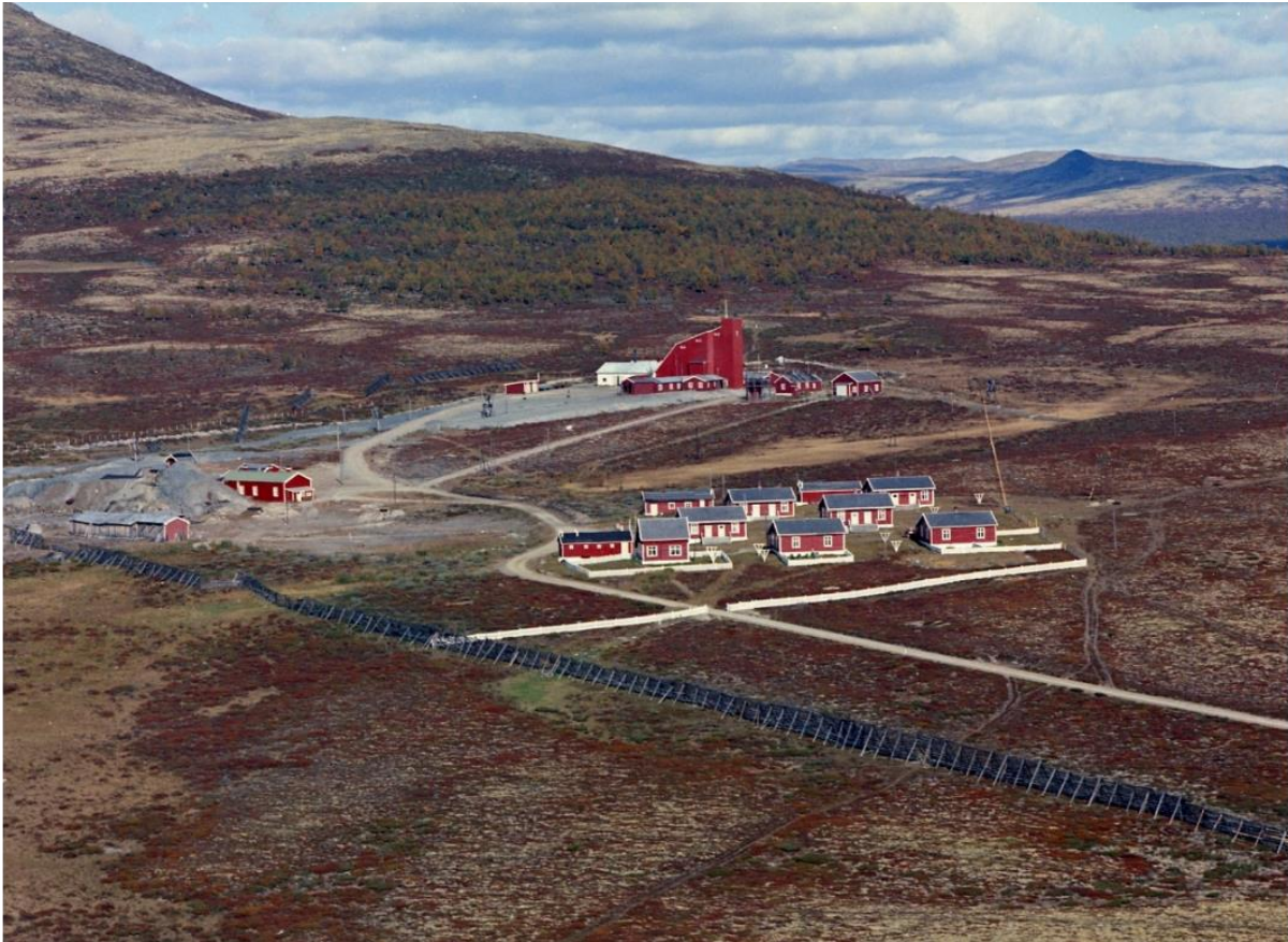
På bildet fra 1964 har det tilkommet flere boligbrakker ved Nordre Geitryggen, bl.a. en stigerbolig som er flyttet fra Nygruva. Heishuset (bakerst til høyre) står i dag på Verket, der det opprinnelig ble reist ca. 1930. Fotograf: Widerøes Flyveselskap A/S MINØ, nr. 018480
