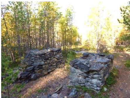
Sirkelsagen nedenfor det gamle pussverket ble bygget i ca. 1893. Det som står igjen i dag er de stødige steinfundamentene som bar det store vannhjulet (vasshjulet).
