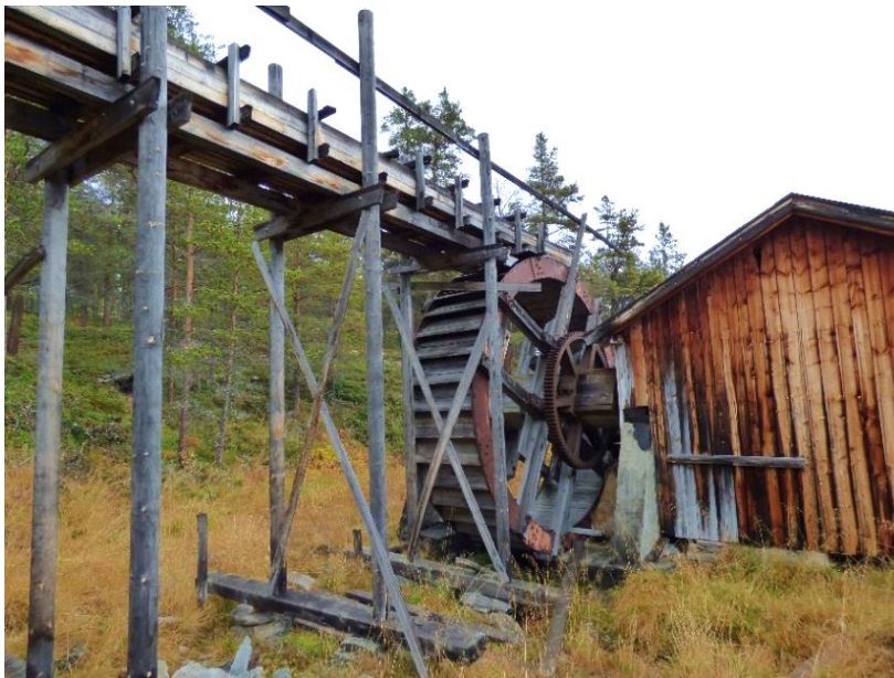
Vassaga i Mellomsbekken. Til venstre vises vannrennen som går frem til hjulet.
