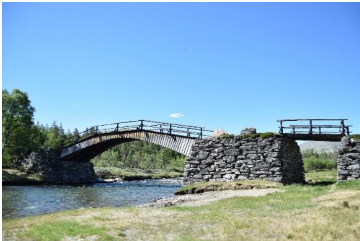
Gamle Grimsa bru. Sideløpet er bygget for å skåne brua fra flomskader.
