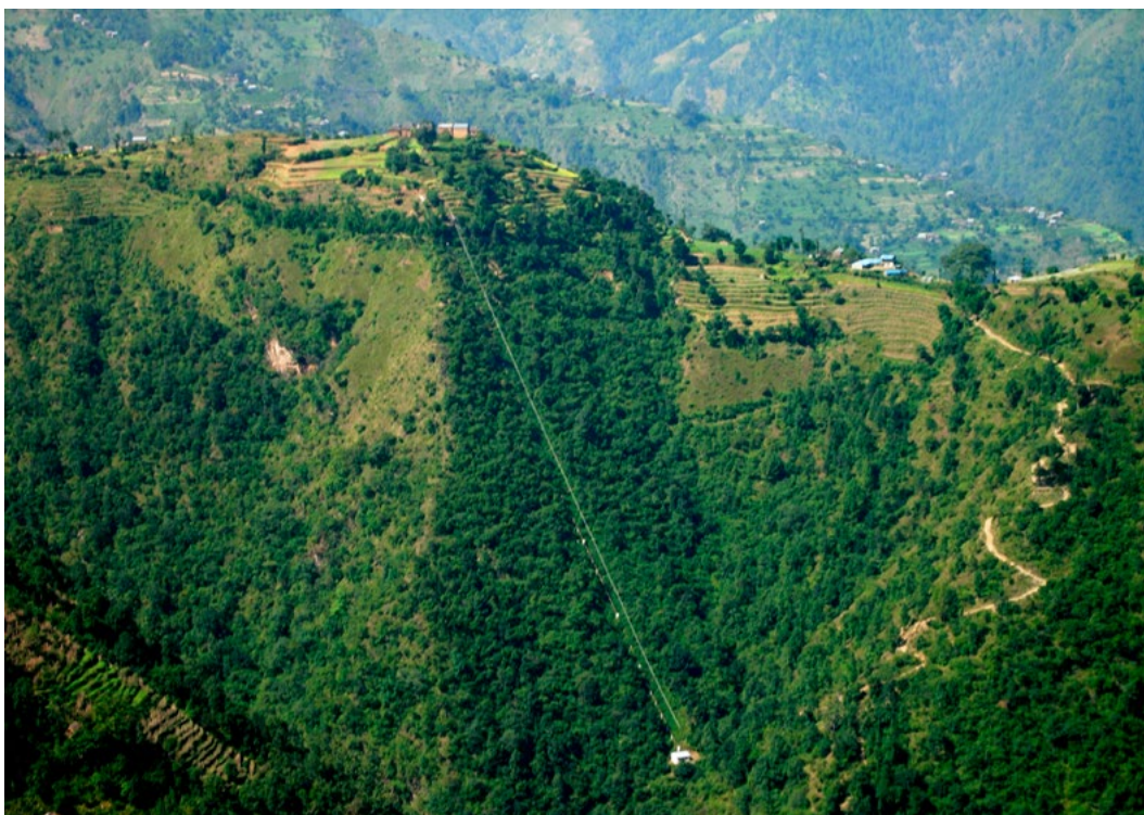
En avsidesliggende landsby i Nepal forsynes med strøm fra et mikrokraftverk bygget av et norskstøttet program. Programmet har bidratt til at over 400 000 husholdninger har fått tilgang til strøm fra solcelleanlegg eller mikrokraftverk.
