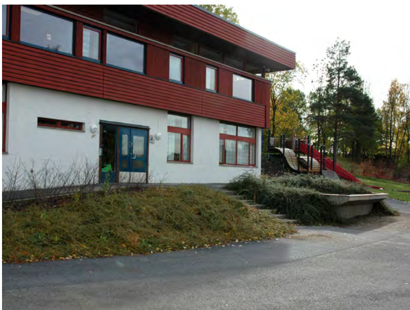
47 i. Haug skole og ressurscenter, Bærum
